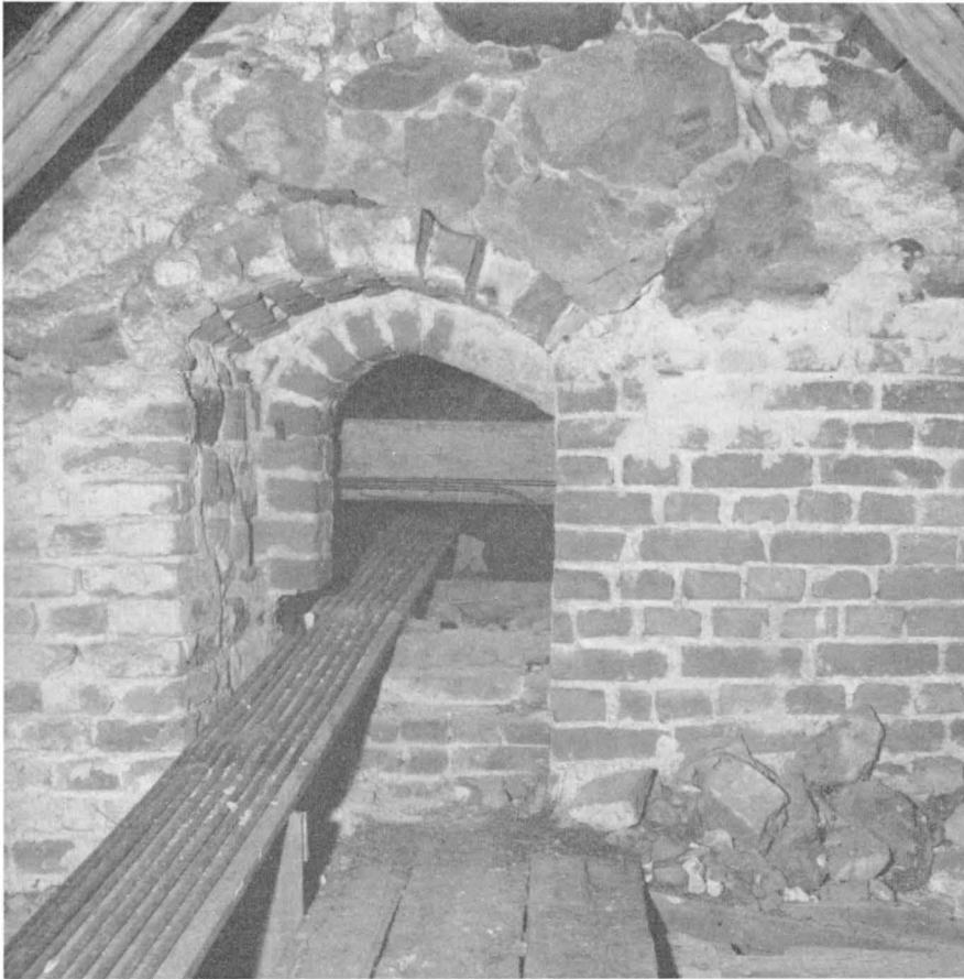
Fig. 199. Öppning mellan tornet och långhusets vind. Foto N. Lagergren 1957 Öffnung zwischen Turm und Boden des Lang- Opening between tower and attic of nave. hauses.
