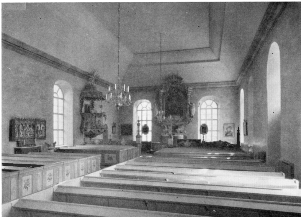
Fig. 149. Interiör mot Ö. Foto 1957. Inneres gegen O. Interior looking E.
