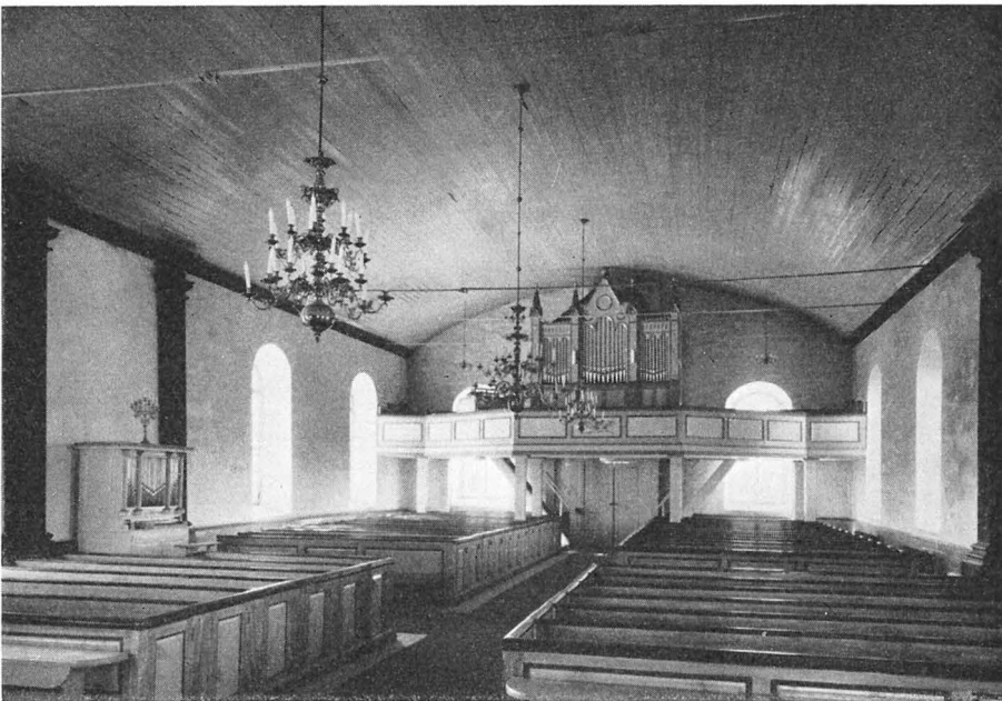
Fig. 219. Interiör mot N och mot S före 1960 års restaurering. Foto 1960. Inneses gegen N und S vor der Restaurierung von 1960. Interior looking N and S before restoration in 1960.
