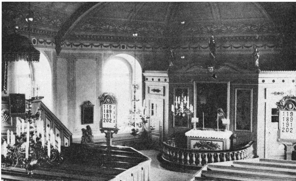
Fig. 120. Interiör mot Ö efter 1902 års restaurering. Foto ATA.
