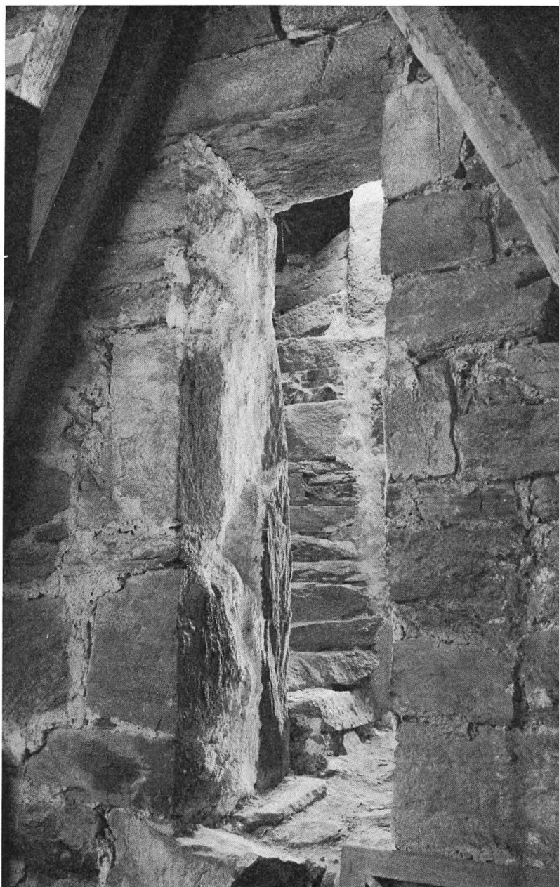
Fig. 156. Döröppning mellan tornets första övervåning och trapptornet. Foto 1964.
