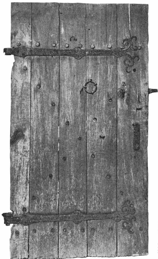
Fig. 208. Dörr med beslag av järn, möjligen medeltida. Har sannolikt tillhört gamla kyrkans huvudingång. Foto 1960.
