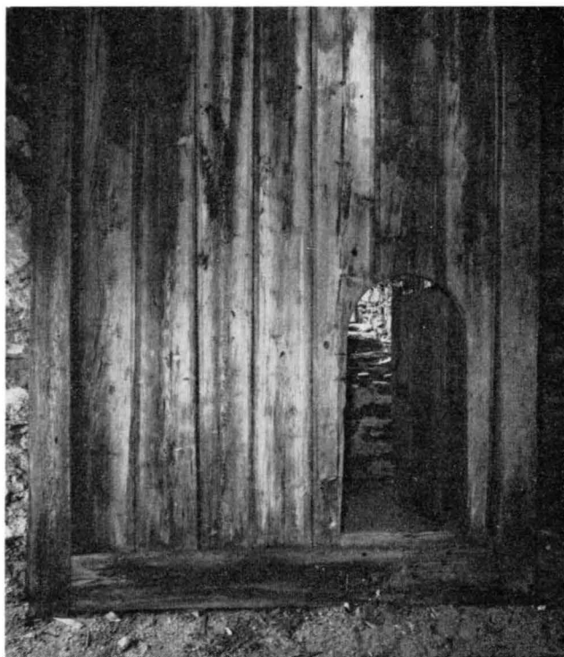
Fig. 26. Stavkonstruktion i tornets första våning. Foto 1960.
