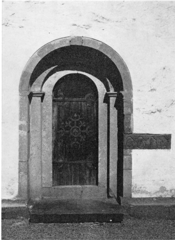
Fig. 12. Tornets V portal med inmurad relikkista av sandsten. Foto 1962. W Portal des Turms mit einge- W doorway of tower with relic chest mauertem Reliquiensarkophag aus of sandstone built in. Sandstein.
