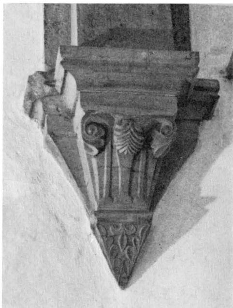
Fig. 129. Valvkonsol å långhusets S mur. Foto 1964. Gewölbekonsole an der S Mauer des Langhauses. Corbel on S wall of nave.
