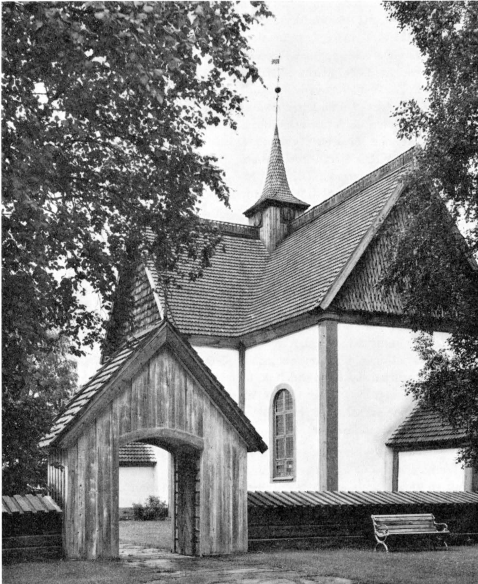
Fig. 192. Kyrkan från SO med stiglucka och bogård. Foto 1960. Die Kirche von SO. The church from SE.
