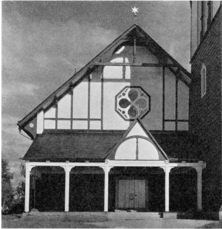
Fig. 240. Exteriör från V med huvudingång. Foto 1957. Fassade von W. Exterior from W with the main entrance.
