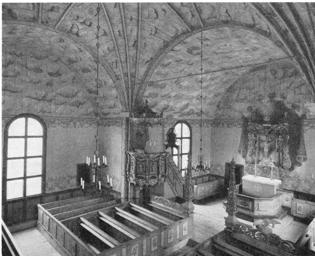
Fig. 201. Interiör mot NÖ. Foto 1957.
