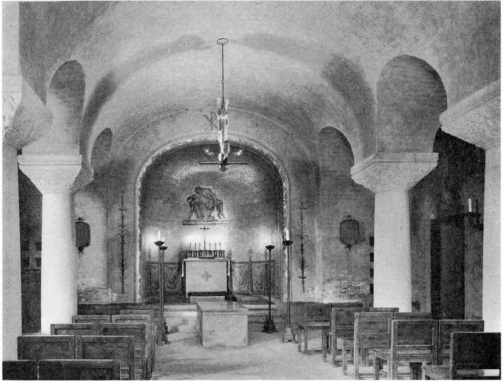
Fig. 297. Begravningskapellets interiör mot V. Foto 1965. Innes der Begräbniskapelle nach W. Burial chapel, interior looking W.
