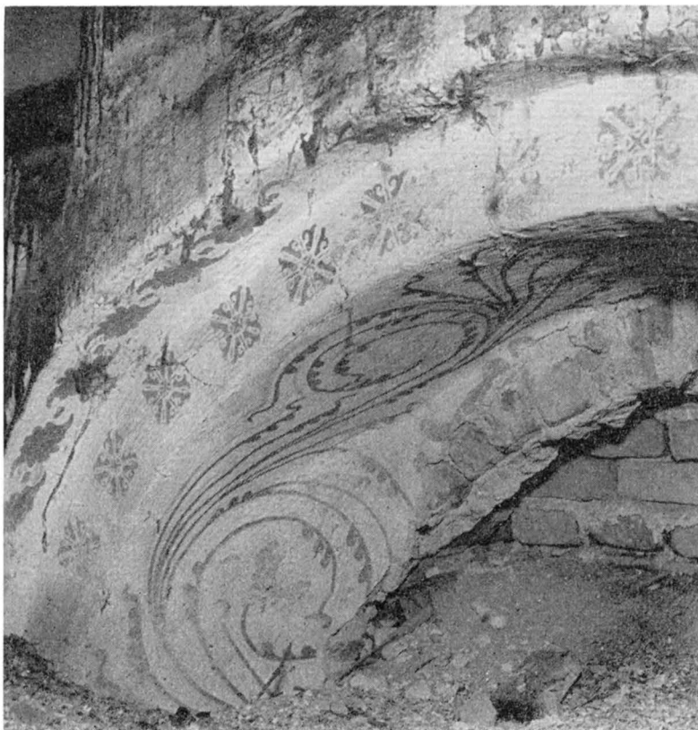
Fig. 37. Äldre fönsteröppning i Ö-gaveln. Omfattning och inre smyg med fragment av kalkmålningar från 1480—90-talet. Sedd från kyrkvinden. Foto 1965.
