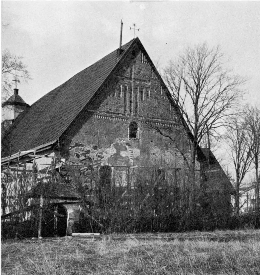
Fig. 15. Ö-gaveln, då putsen avknackats vid yttre restaurering 1951. Foto E. Bohrn 1951, ATA.
