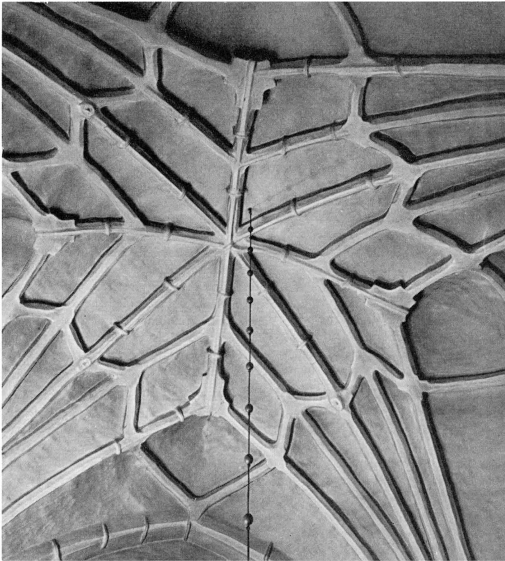
Fig. 82. Stjärnvalv i koret. 1400-talets slut. Foto 1965. S. 100. Stellar vaulting in chancel; end of 15th century.
