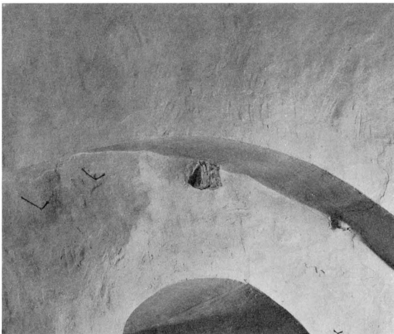
Fig. 136. Spår av äldre takkonstruktion ovanför S-murens V fönster. Foto 1965. S. 160. Traces of older roof construction above W window in S wall.
