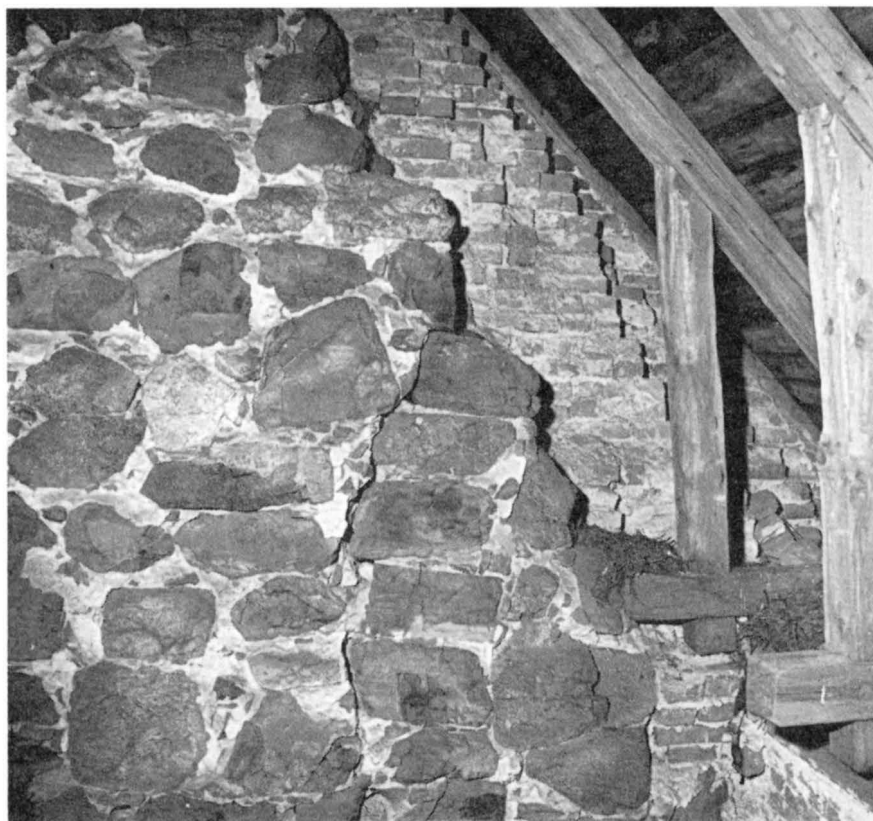
Fig. 70. Ö gavelröstets insida. Skarv efter påbyggnad med tegel åt S i samband med ändring av takstolens resning 1806. Foto 1965. S. 86.
