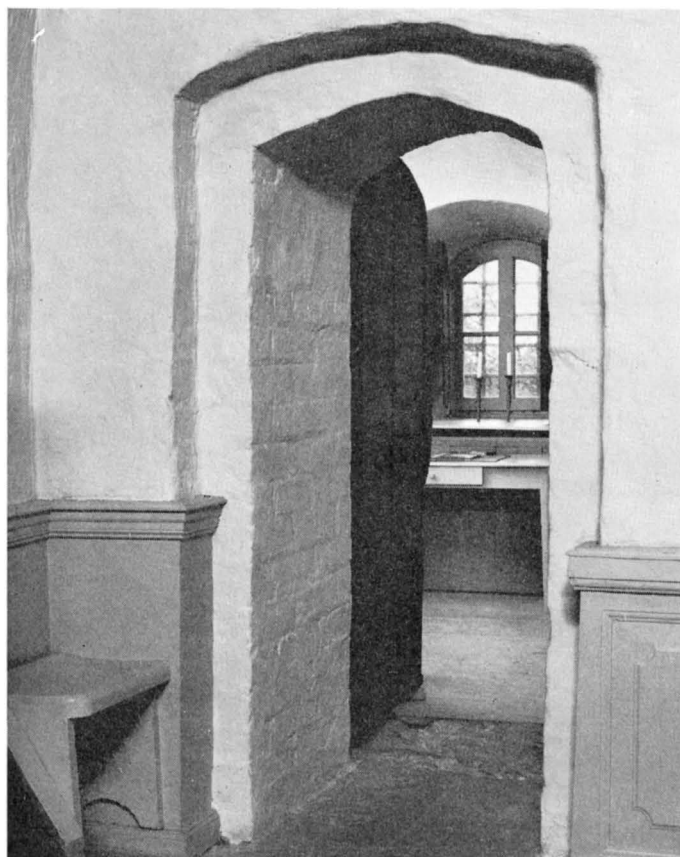
Fig. 140. Ingång till sakristian i korets N-mur. Foto 1965. Entrance to vestry in N wall of chancel.
