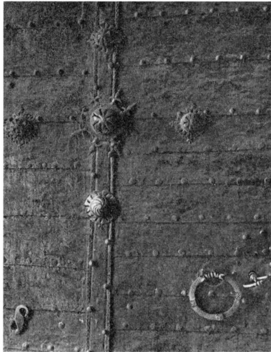
Fig. 33. Smidesbeslag på V-portalens dörr. Foto 1965. Ironwork on W door.
