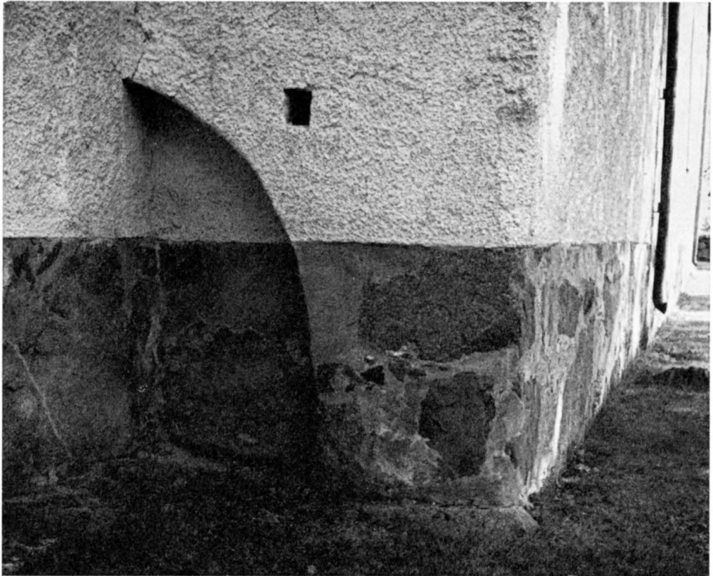
Fig. 20. Spår i V-gaveln S om tornet, sannolikt efter uppgång till pilgrimshärbärge på kyrkvinden. Foto 1962. S. 16.
