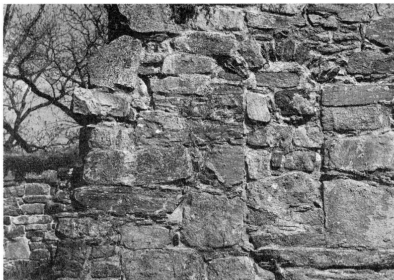
Fig. 254. Detalj av långhusets S yttermur med igenmurat medeltida fönster. Foto 1965. Vermauertes mittelalterliches Fenster in der S Außenwand des Langhauses. Detail of outer S wall of nave with closed medieval window.
