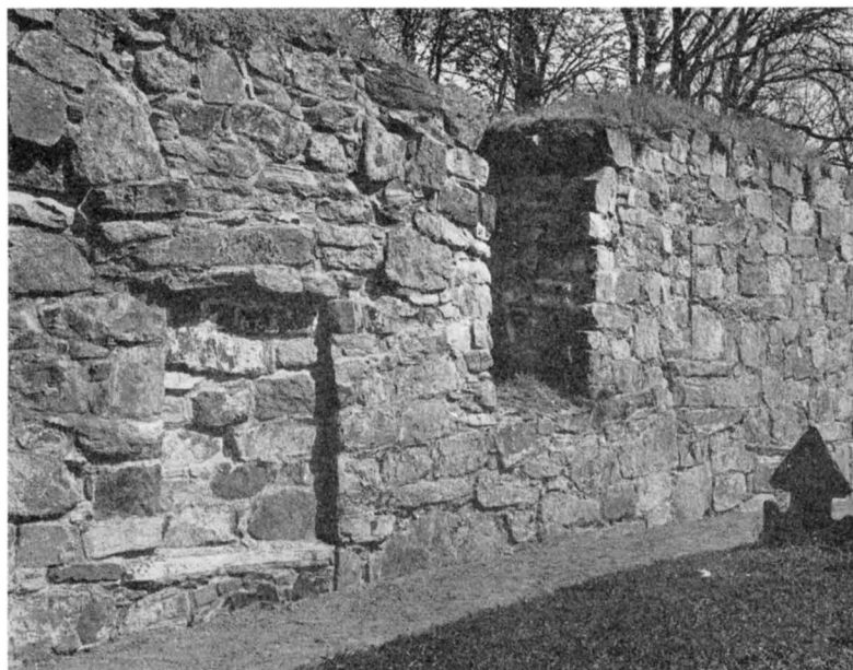
Fig. 255. Detalj av långhusets S yttermur med igenmurad medeltida portal. Foto 1965. Vermauertes mittelalterliches Portal in der S Außenwand des Langhauses. Detail of outer S wall of nave, with closed medieval doorway.
