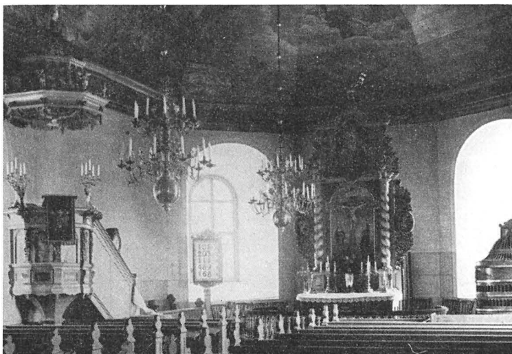
Fig. 323. Interiör mot Ö efter restaureringen 1905. Foto ATA. Kircheninneres nach O nach der Restaurierung 1905. Interior looking E after restoration in 1905.
