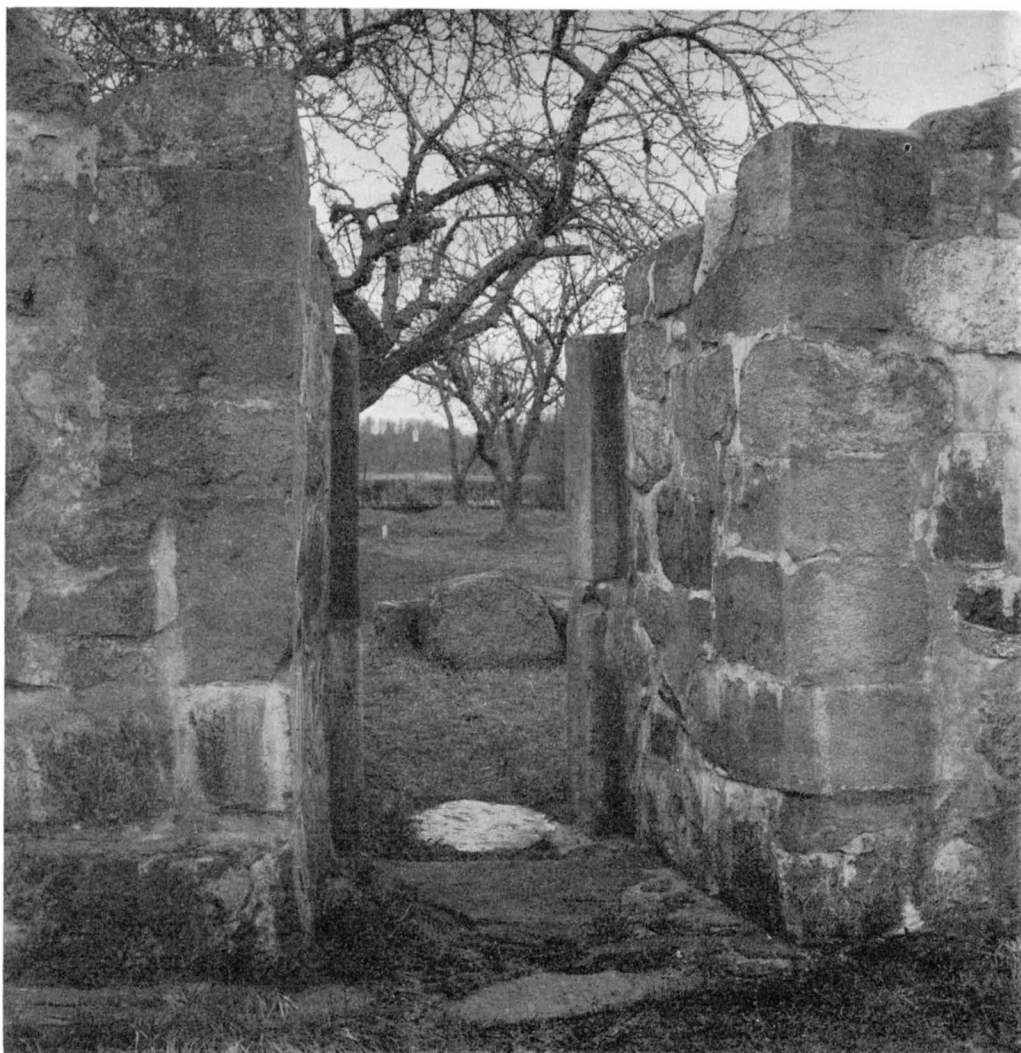
Fig. 770. S ingången, sedd inifrån långhuset. Genom dageröppningen ser man stenblock ur grunden till vapenhusets S mur. Foto S. Hallgren 1965.
