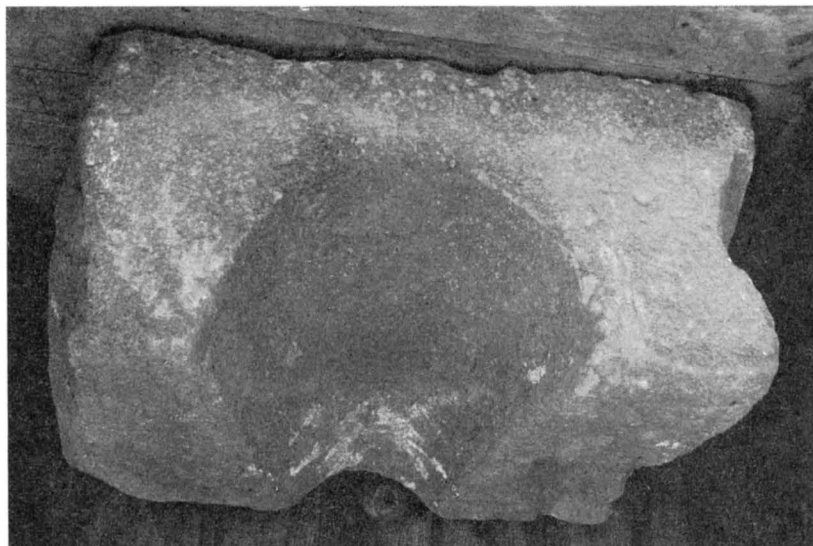
Fig. 775. Parti av omfattningen till en tittglugg med starkt skrånande smyg. Sandsten. Foto S. Hallgren 1965.
