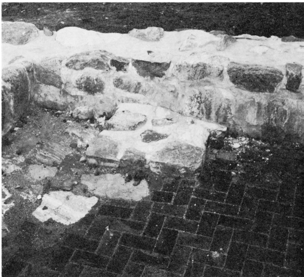
Fig. 780. Parti av tegelgolvet i sakristian, delvis rekonstruerat. Mot Ö muren grunden till ett altare. Foto R. Norberg 1937.
