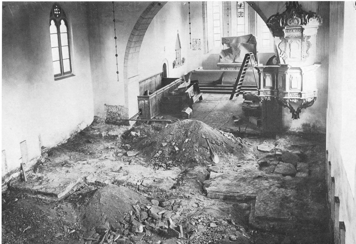
Fig. 43. Framgrävda grundmurar i långhusets östra del i samband med kyrkans restaurering 1923–25. Långhusets ursprungliga begränsning åt öster samt sidoaltaren tydligt synliga. Foto A Edle 1924.
