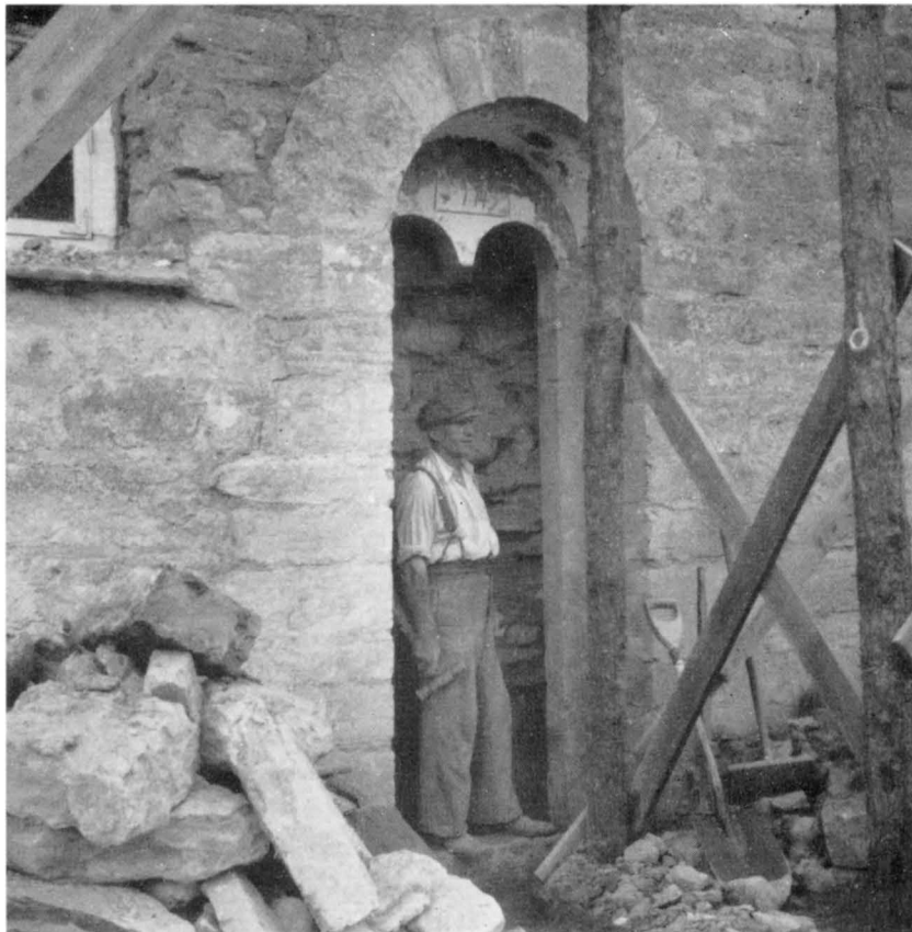
Fig 53. Portalen i norra korsarmen samt det omgivande murverket under framtagnandet. Foto R Boström 1942.
