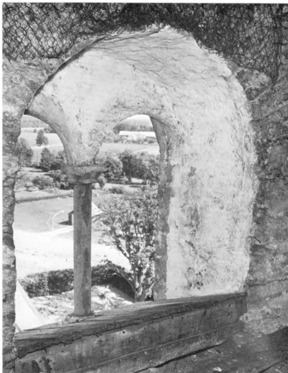
Fig. 200. Tornets östra ljudglugg med kolonnett och kapitäl av kalksten. Foto 1965.
