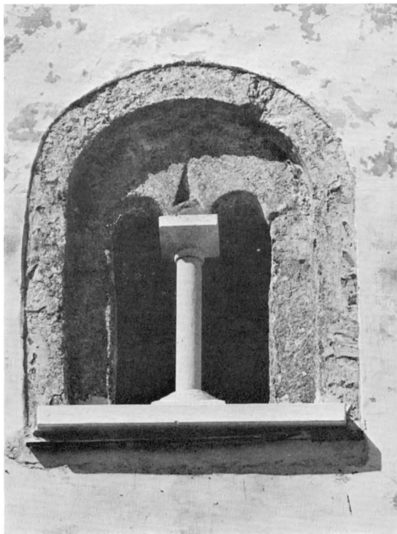
Fig 196. Ljuslugg i tornets första övervåning. Kolonnett och kapitäl av kalksten rekonstruerades vid restaureringen 1964-65. Foto 1965.
