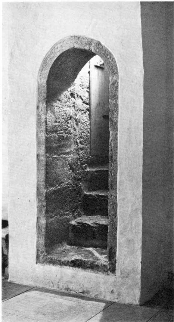
Fig 195. Ingång till torntrappan i västra tornbågens norra vederlag. Foto 1965.
