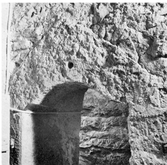
Fig 197. Torntrappans ingång till tornets första övervåning. Täckskena av kalksten med trepassformad nederkontur. Foto 1965.
