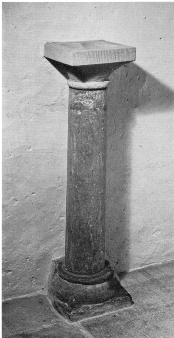
Fig 226. Piscina vid korets östra mur, kolonnett och bas medeltida, skålen utförd i samband med restaureringen 1964–65. Foto 1965.
