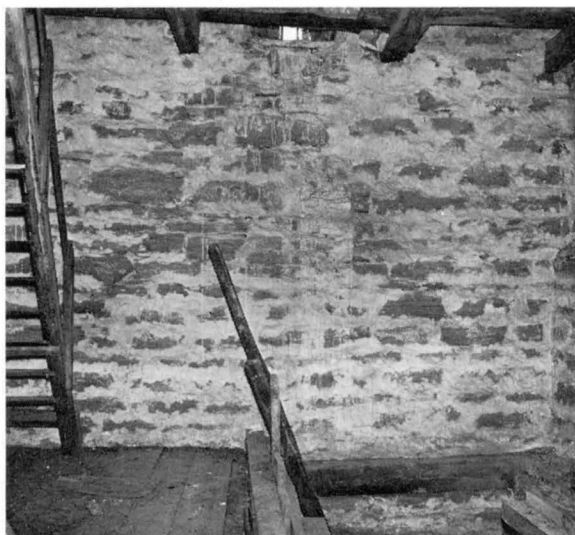
Fig 201. Västra muren i tornets andra övervåning med spår av tillfälligt yttertak. Foto 1965.
