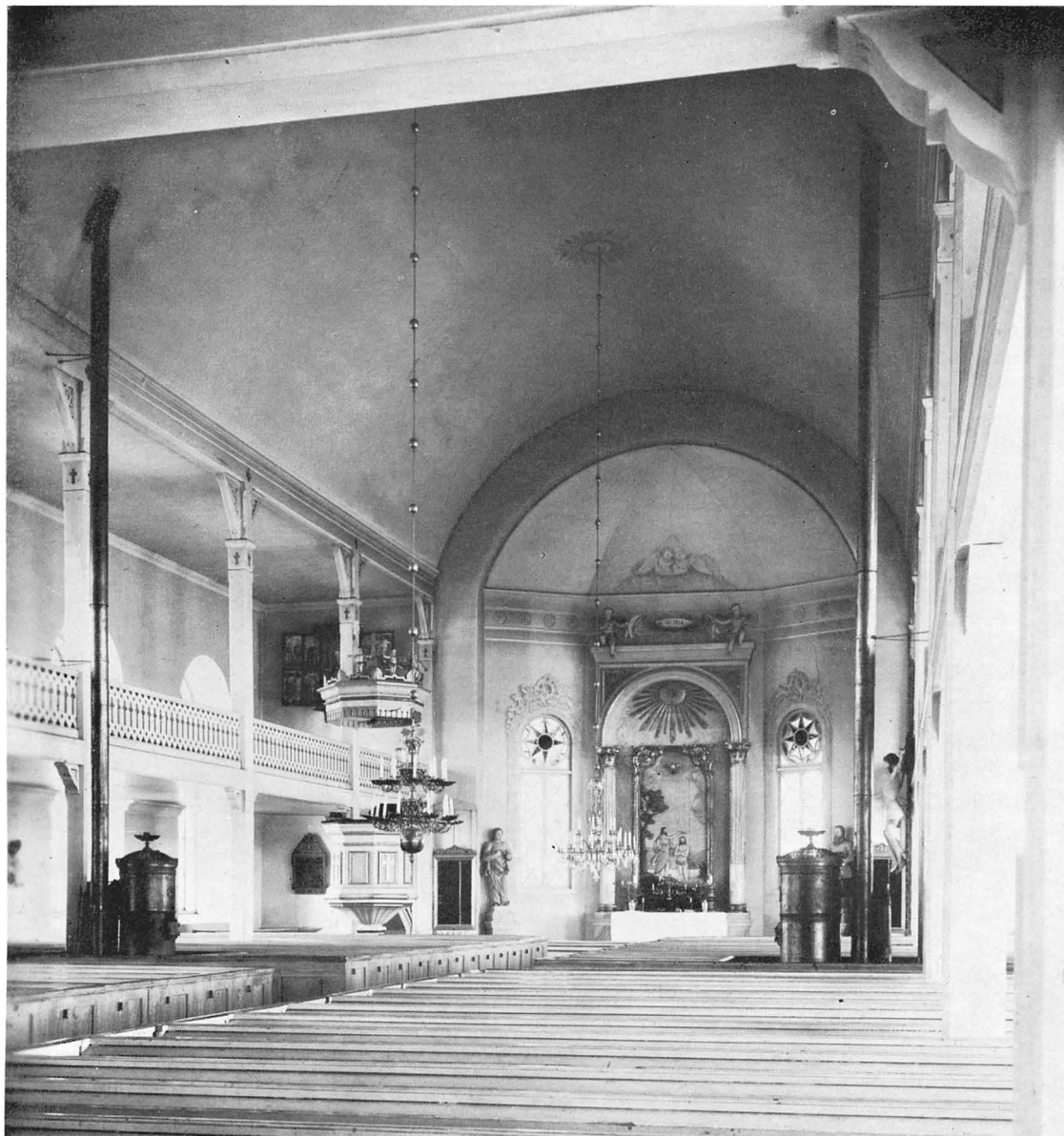
Fig 153. Interiör mot öster före restaureringen 1939. Foto A Edle 1935.
