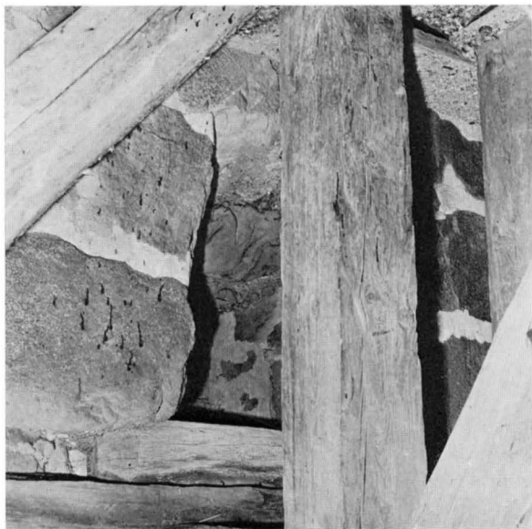
Fig 187. Igensatt medeltida ljusglugg i tornets sydmur. Foto 1967.
