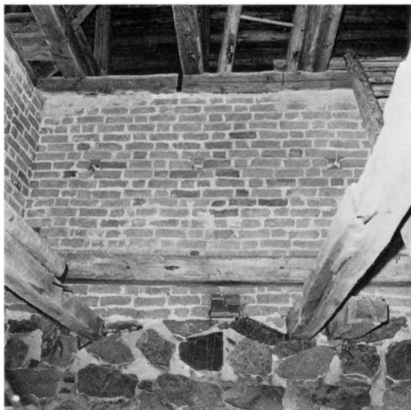
Fig 185. Påbyggnad av tornet med tegel i medeltidsformat. Omkr 1500. Foto 1967.
