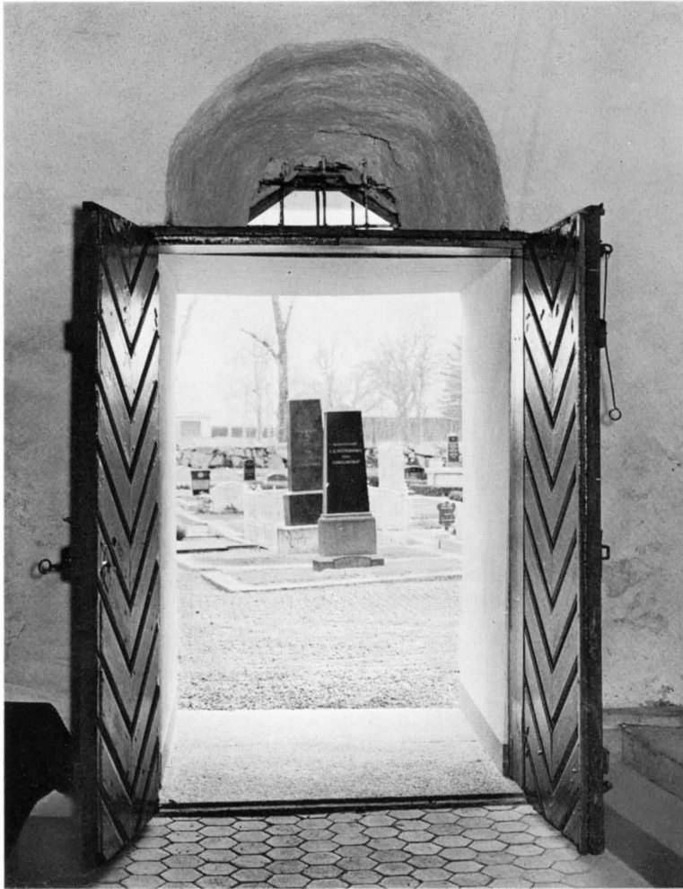
Fig 194. Ingång i tornets västmur, sedd från tornrummet. Övre delen troligtvis från början en ljusöppning. Foto 1967.
