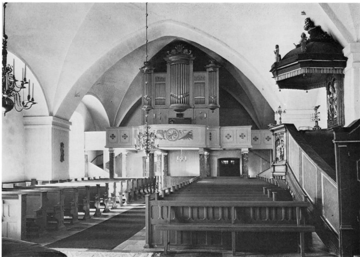
Fig 199. Interiör mot väster. Foto 1967. Interior looking west.
