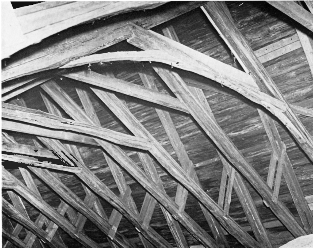
Fig 18. Ursprunglig takstol med spår efter medeltida trä-tunnvalv. Foto 1967.
