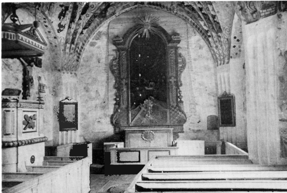
Fig 31. Interiör mot öster före restaureringen 1935. Foto P-O Westlund 1935.
