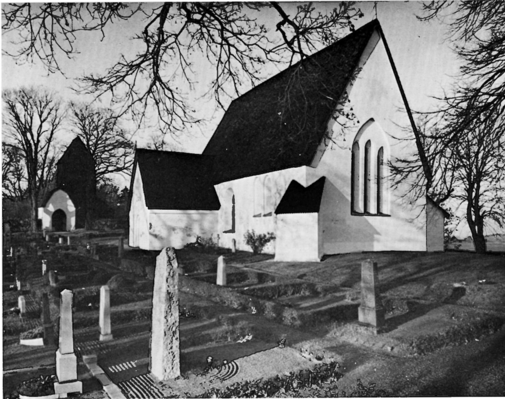
Fig 3. Kyrkan från sydost. Foto 1967.
