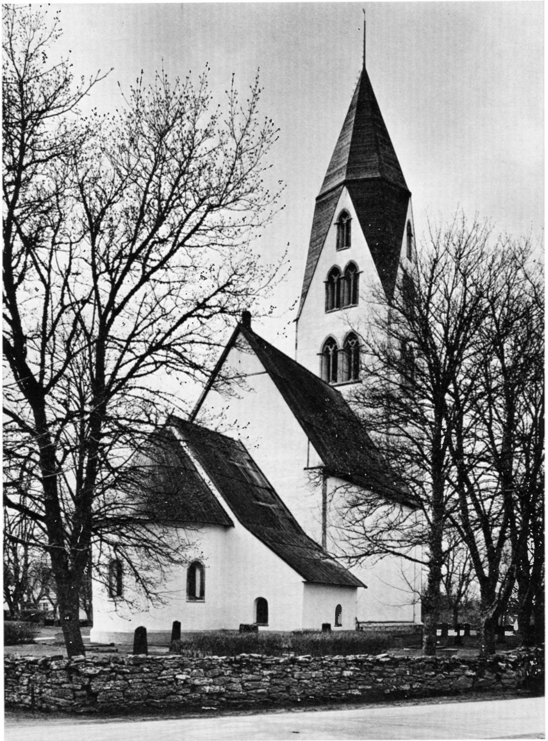
Fig 91. Kyrkan från nordost. Foto 1964. Church from NE.
