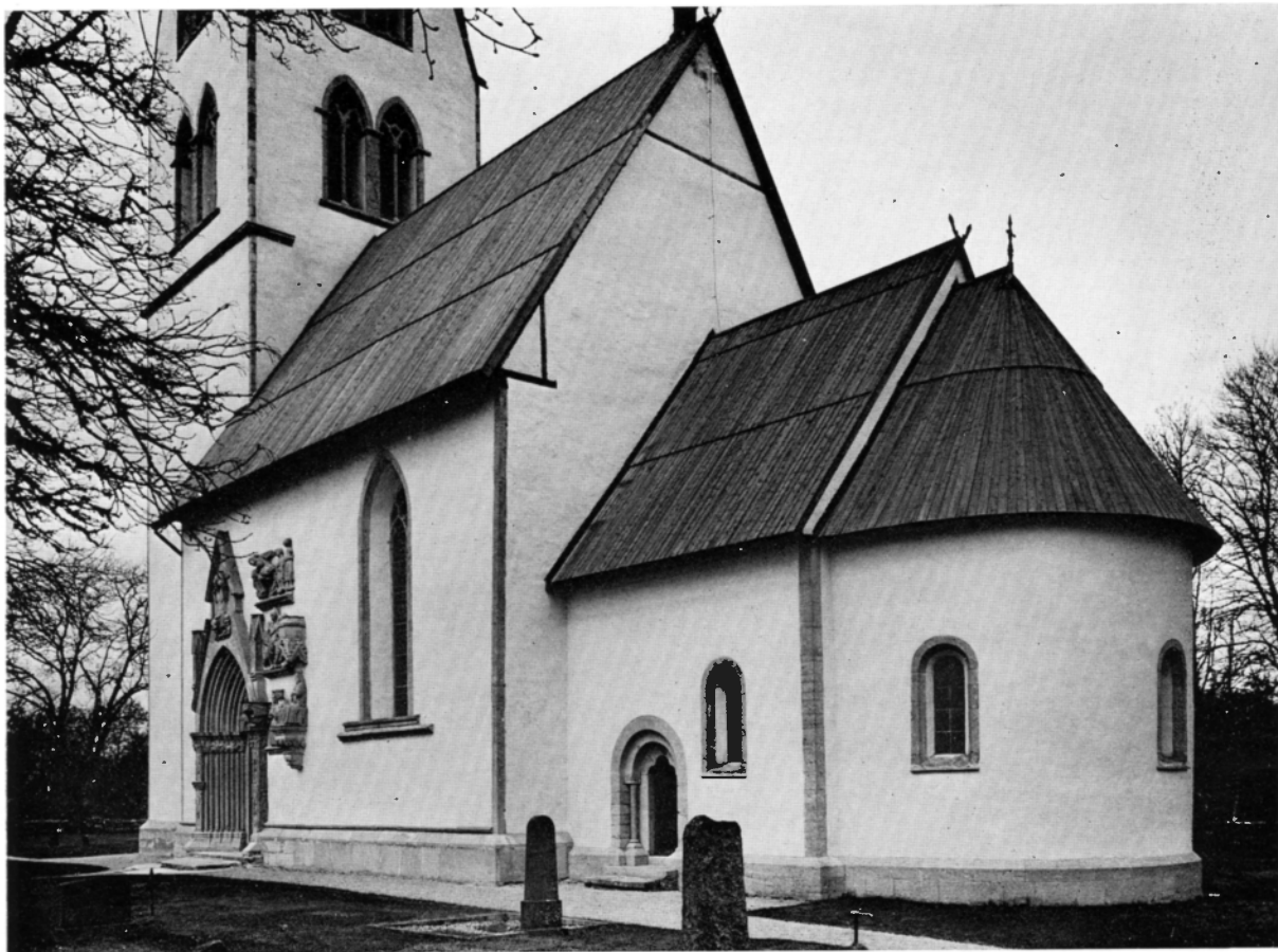
Fig 92. Långhusets och korets södra fasader. Foto 1964. South fronts of nave and chancel.
