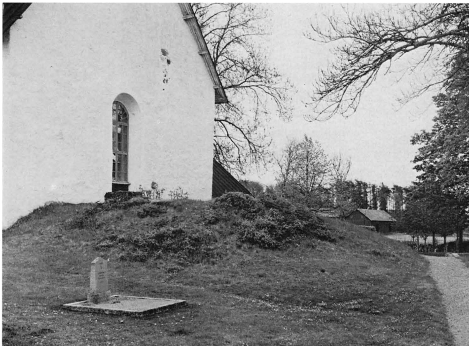
Fig 113. Ruin efter torn invid västra gavelmuren. Troligen från äldsta kyrkan. Foto 1965.
