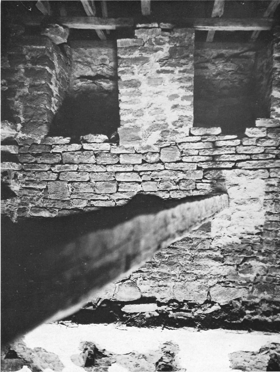
Fig 210. Västtornets norra vägg, övre delen, motsvarande tornets andra våning samt skyttevåningen, sedda från ingången till trappan. En förankringsbjälke vilar i en igenmurad ljusglugg (jfr planen fig 199:b). T v skymtar förtagningsstenar för västra väggens inre skalmur. Nedtill norra anfanget till 1760 års tunnvalv (jfr fig 238, 265:E). Foto A Edle 1931.
