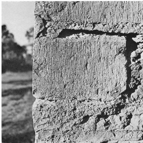
Fig 216. Kvaderstenar med mönsterbehuggning, sekundärt använda i västra stigtluckan (fig 189), troligen från långhusets mittpelare (jfr rekonstruktionen fig 218). Foto S Hallgren 1964.
