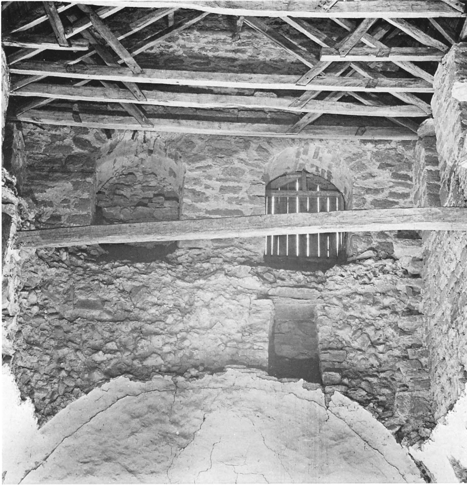
Fig 207. Västgaveins insida, motsvarande det forna tornets andra våning med en utifrån tillmurad högt sittande utgång (jfr fig 231) samt skyttevåningen. Foto S Hallgren. 1964.
