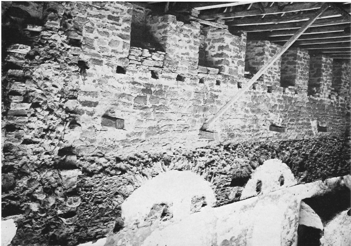
Fig 219. Kyrkans norra mur ovanför valven. Längst t v såret efter tornets bortbrutna östra mur. Foto A Edle 1931.
