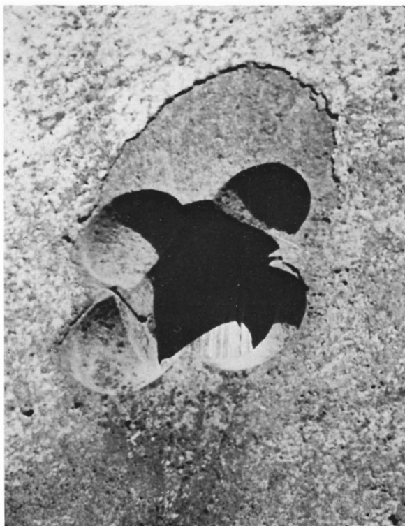
Fig 201. Fönsteromfattning av huggen kalksten, sekundärt använd i västra gavelröset (fig 200). Ursprungligen i det äldsta stenkoret absid(?). Foto S Hallgren 1964.
