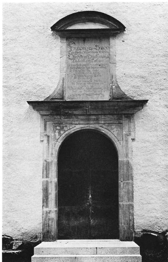
Fig 580. Tornets västra portal från 1679–80. Foto 1958. W doorway of tower, dating from 1679–80.
