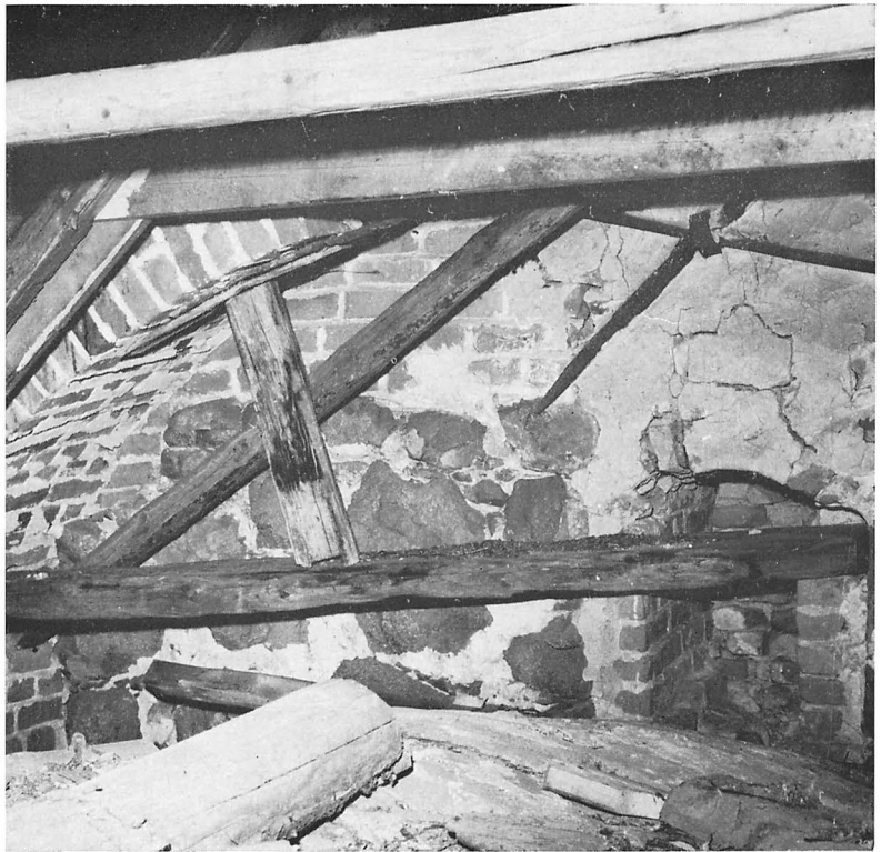
Fig 260 a–b, ovan och nedan t h. Avlastningsbåge av tegel tvärs över sakristians södra gavel mot sakristie- vinden. Uppförd då nuvarande långhus fogades till träkyrkans stensakristia. Foto O Ehn 1961. Upplandsmuseet.
