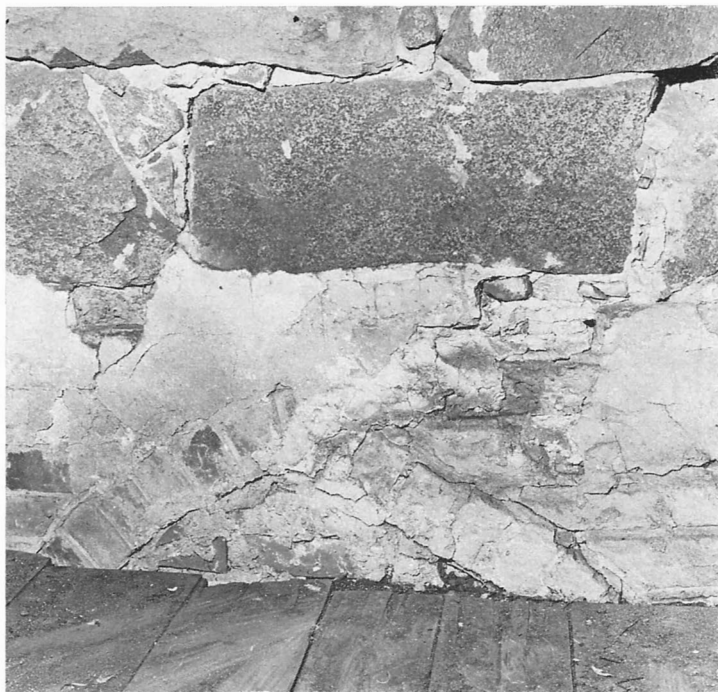
Fig 256. Spår efter sydportalens yttersta språng ovanför vapenhusets innertak, jfr fig 252. Foto 1968.
