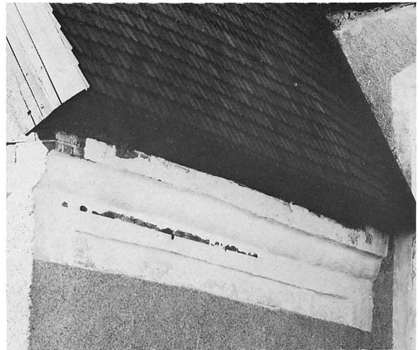
Fig 264. Vapenhusets taklist av formsten. Foto 1967.
