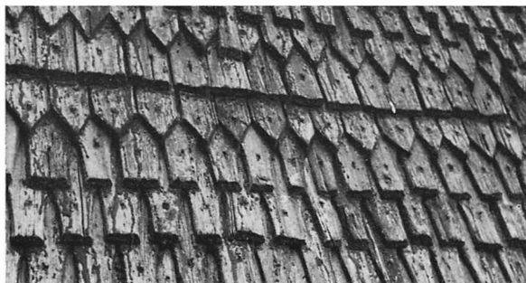
Fig 257. Kyrkans spåntak. Detalj av äldre spåntäckning. Foto L Gezelius 1963. Upplandsmuseet.
