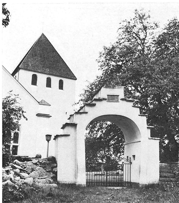
Fig 295. Norra stigluckan från norr. Foto R Boström 1964. North lychgate from N.
