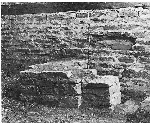
Fig 327 Interiör av västtornets andra våning med trappans mynning invid västra muren. I denna en vågrät slits som troligen utgjort upplag för täckflisorna i en trapphuv. Foto S Hallgren 1969.
