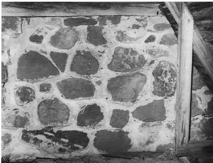
Fig 12. Kyrkans norra mur, sedd från sakristievinden. Foto 1969.
