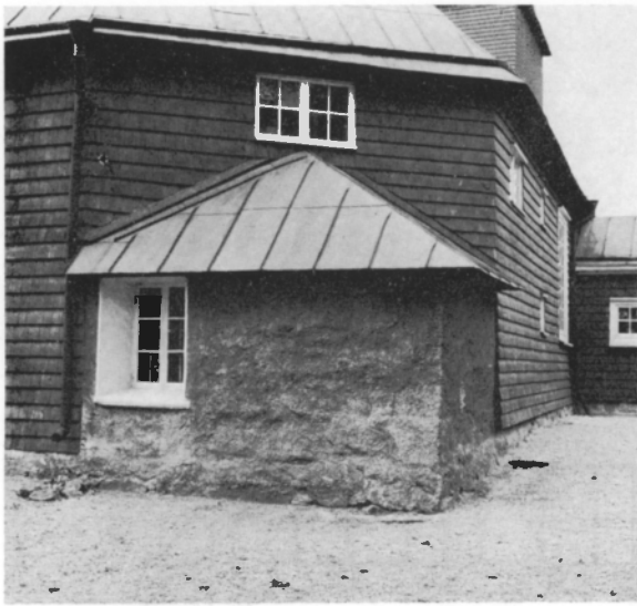
Fig 15. Den medeltida, murade sakristian sticker utför det avskurna nordöstra hörnet. Foto 1968.
