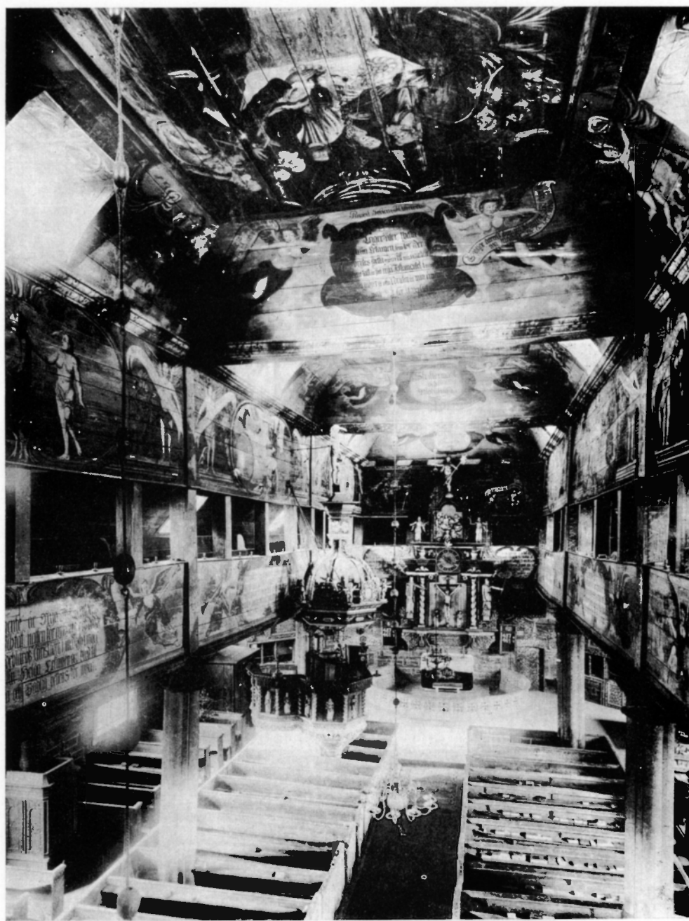
Fig 19. Kyrkorummet sett från orgelläktaren, före 1907 års restaurering. Järnkamin, invändigt vindfång på norra sidan och äldre bänkindelning. Foto Holm, Jönköping, före 1899, ATA.
