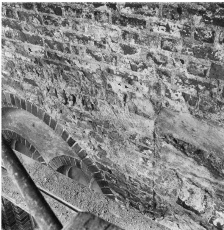
Fig 81. Detalj av södra sidoskeppets fasad, visande skarven mellan 1300-talskapellet sydmur och den senmedeltida utfyllnads-muren mellan kapellet och södra korsarmen. Jfr pl VIII. Foto E Gustafsson 1959.
