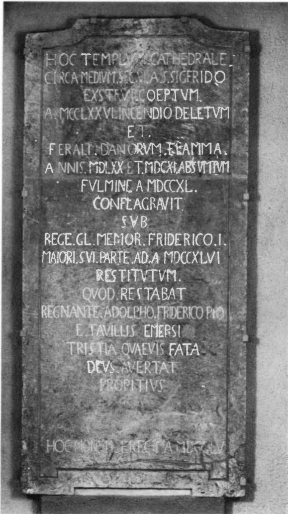
Fig 56. Minnestavla från 1755, ursprungligen placerad på tornets västfasad, nu uppsatt på södra väggen i tornets bottenvåning. Foto 1968.
