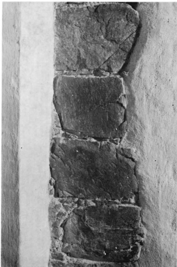
Fig 29. Murverk från 1100-talet i mellersta pelaren mellan mittskeppet och södra sidoskeppet. Foto 1968.
