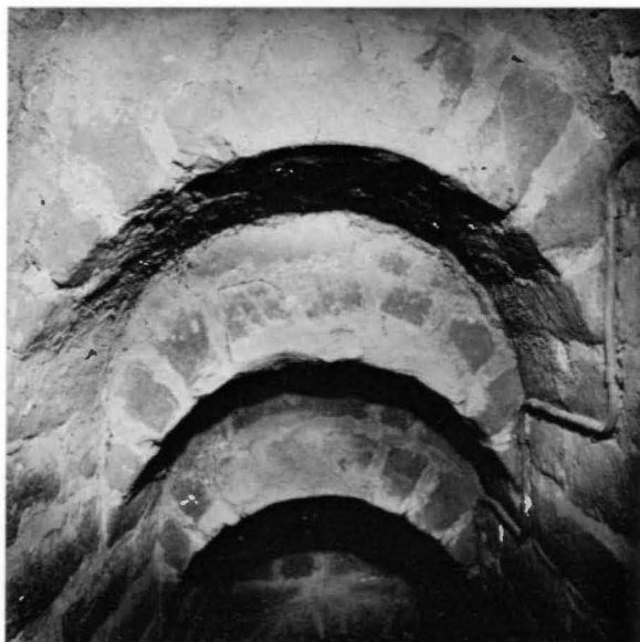
Fig 72. Detalj av valvet i västra tornmurens trappa. Foto 1969.
