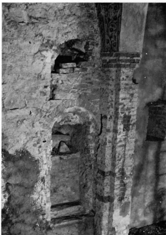
Fig 92. Detalj av norra sidoskeppets västligaste travé med igenmurad ljusglugg och dörröppning till en murtrappa, som sannolikt fört till ett s k predikotorn. Foto E Gustafsson 1959.
