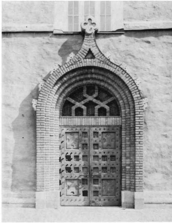
Fig 38. Kyrkans västportal. Omfattningen utförd 1853, den kopparklädda kyrkporten och tympanonfältets gallerverk i tegel och koppar från 1959. Foto 1968.
