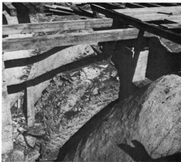
Fig 98. Högmur på vilken det senmedeltida valvet i tvärskeppets mittkvadrat haft upplag. Nuvarande valv från 1740-talet. Foto Smål Mus 1958.
