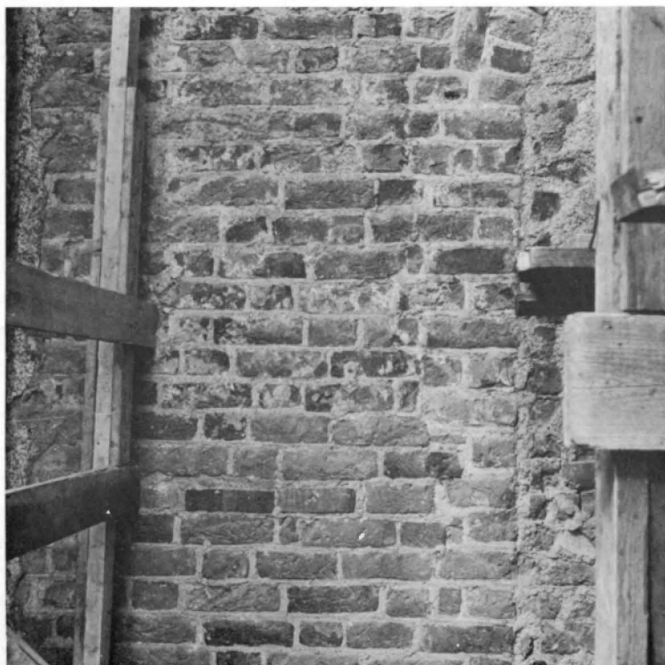
Fig 82. Detalj av södra sidoskeppets fasad, västra travén, visande fönsteromfattning från 1300-talet som förhöjts under senmedeltiden. Lägg märke till att teglen i omfattningens övre del ej svarar mot skiften i 1300-talsmurverket. Jfr pl VIII. Foto E Gustafsson 1959.
