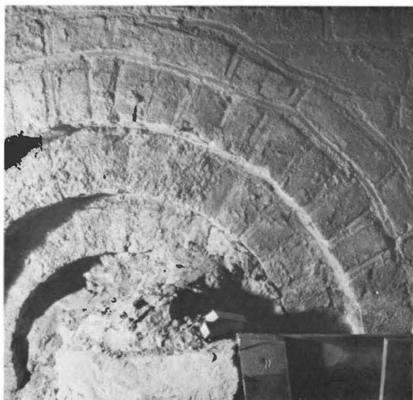
Fig 87. Detalj av fönsteromfattning i södra sidoskeppets ursprungliga västgavel. Jfr fig 85. Foto Smål Mus 1958.
