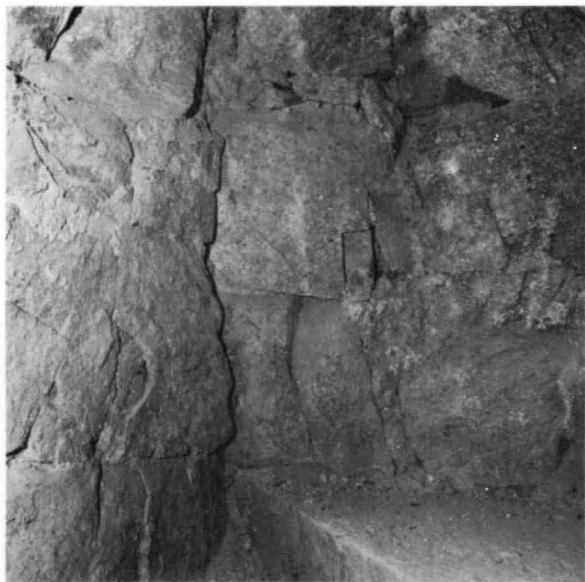
Fig 64. Nordöstra hörnet i tornets bottenvåning med stötfog mellan norra tornmuren och 1100-talskyrkans långhusgavel. Foto E Gustafsson 1958.
