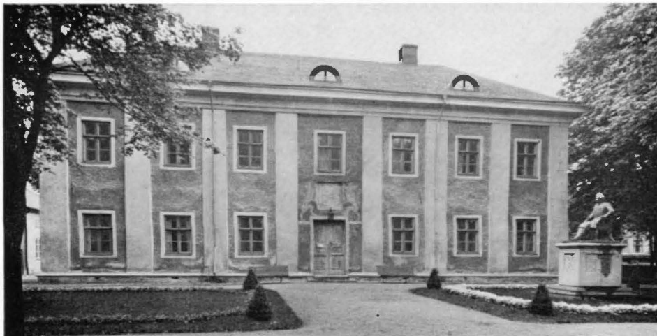
Fig 22. Gamla gymnasiet från söder. Uppfört 1697. Foto ATA.
