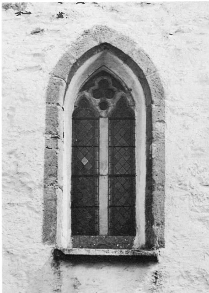
Fig 335. Fönster i tornets västra fasad. Foto 1968.
