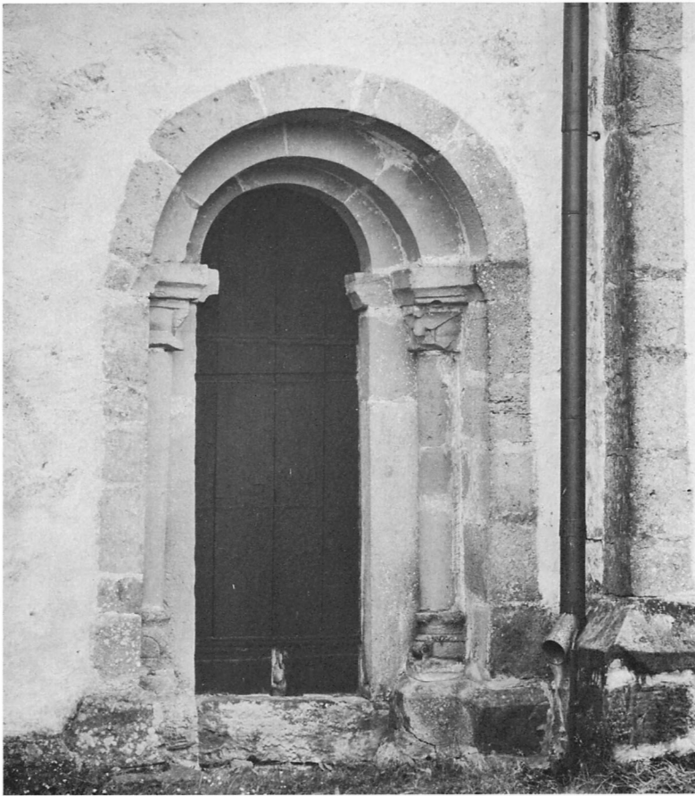
Fig 326. Långhusets norra portal, ursprungligen på södra sidan, 1200-talets förra hälft. Foto 1968.
