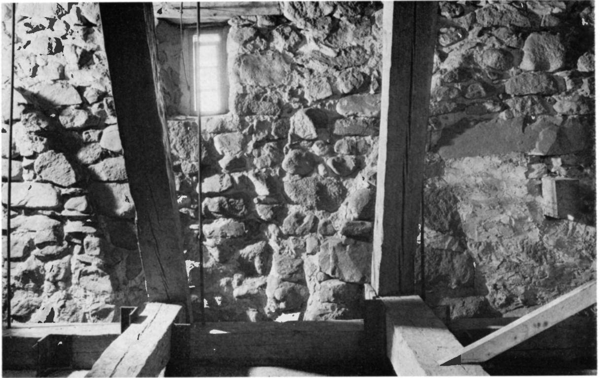
Fig 22. Avtryck å tornets innermurar av det bortbrutna valvets sköldbågar. Foto 1968. Impression of the demolished wall arches in interior wall of tower.
