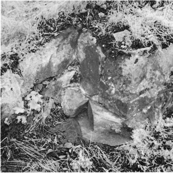
Fig 65. Det norra hörnet mellan långhuset och koret. Foto 1969.
