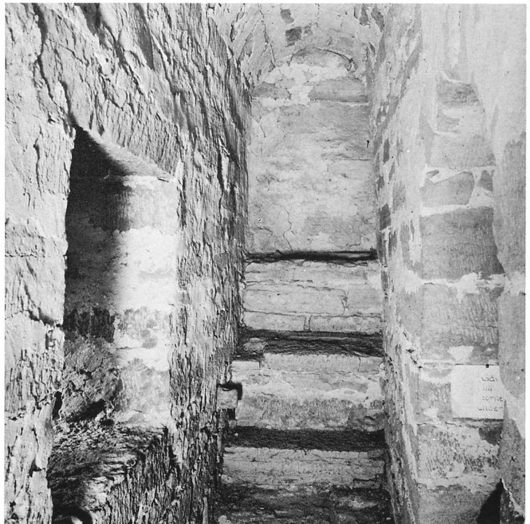
Fig 419. Västtornets andra våning, trappans tunnvalvda vilplan i västra muren, mot söder. Observera avtryck av skälbräder i valvet. Foto S Hallgren 1964.
