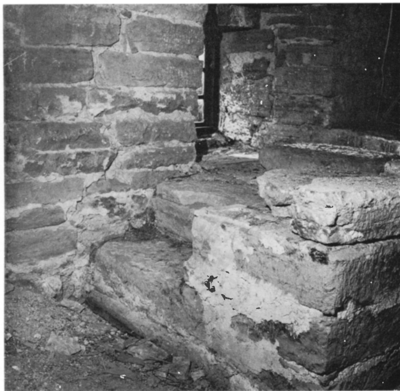
Fig 436. Västtornets tredje våning, rester av trappa i sydvästra hörnet (jfr fig 431, 451, 452). Foto R Boström 1967.
