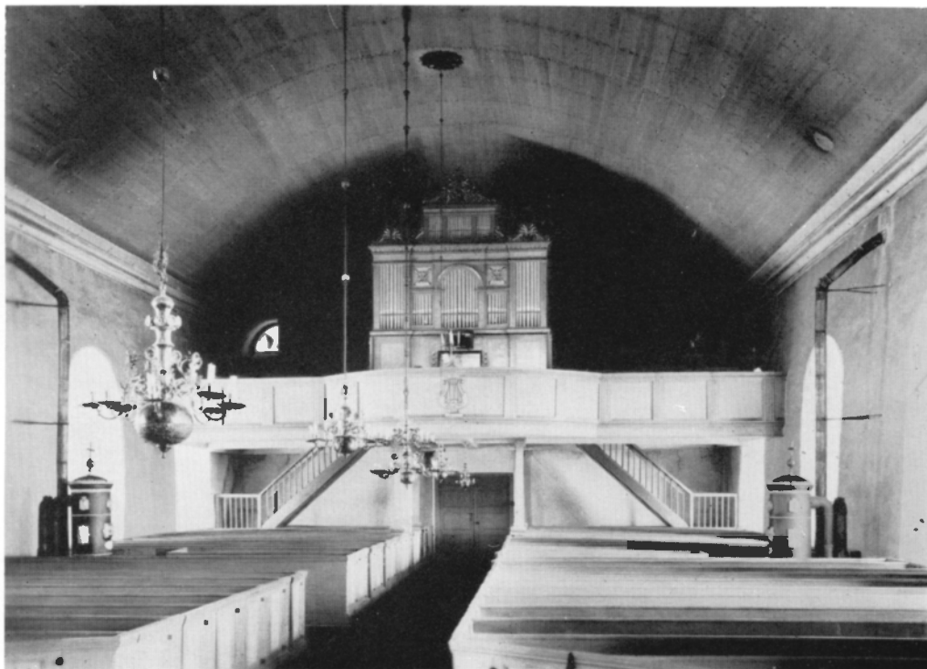
Fig 470. Interiör mot väster före restaureringen 1955. Foto A Edle 1935.
