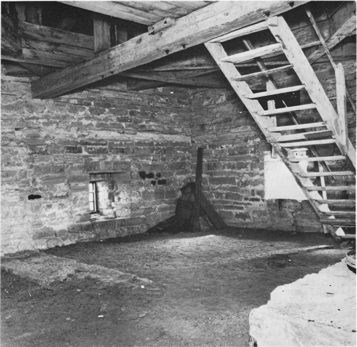
Fig 435. Västtornets tredje våning, sydöstra hörnet. T v grunden till skiljemuren samt dess avtryck på östra muren. Det mörka partiet i golvet under trätrappan utvisar var det översta hålet för klocklinan är beläget. Det ljusa, horisontala partiet över fönstret på östra muren är avtryck av en takbjälke, som ingått i det bjälklag vilket utgjorde golv i en sedermera raserad fjärde våning (jfr fig 451, 452). Foto S Hallgren 1964.
