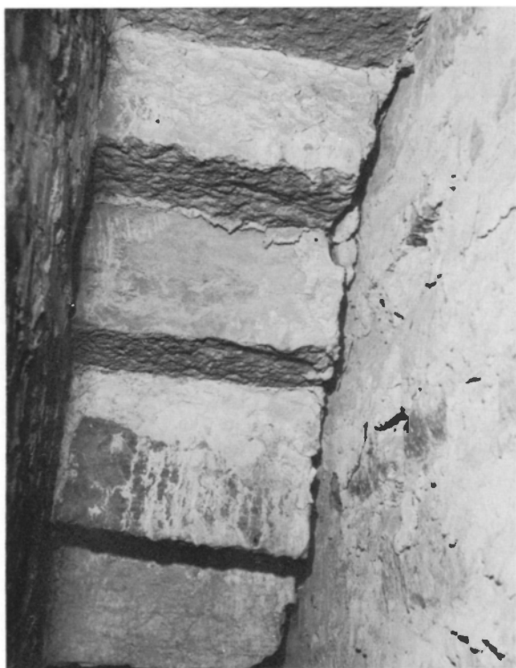
Fig 411. Murtrappans avtäckning i nivå med första tornvåningen, ej i förband med yttermuren. Foto R Boström 1963.
