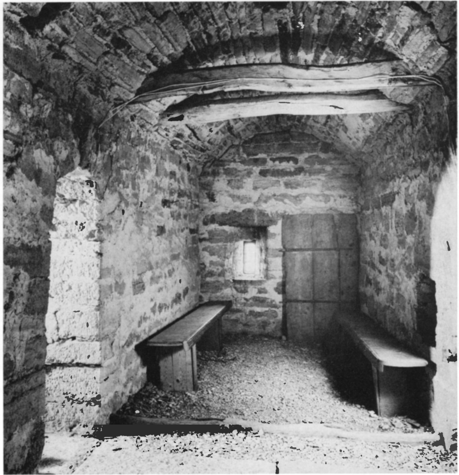
Fig 413. Västtornets första våning, östra kammaren, mot norr. T v ingången till västra kammaren, t h utgången till läktaren. I golvet en syll, i valvet däröver ett remstycke från en mellanvägg av trä i stavteknik (jfr fig 416, 417). T v ingången till västra tornkammaren, t h utgången till läktaren. I bakgrunden den gamla läktardörren, troligen medeltida (jfr fig 414). I valvhjässan i förgrunden det ena klockline-hålet (jfr fig 429). Foto S Hallgren 1964.
