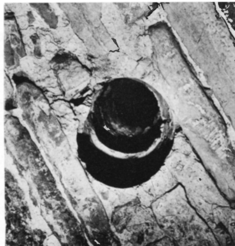
Fig 429. Västtornets första våning. Två av löphålen i fig 428 sedda underifrån. Foto R Boström 1970.
