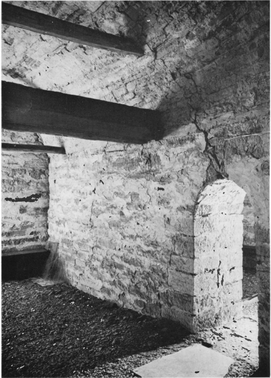
Fig 405. Västtornets första våning, västra kammaren, mot nordöst. Den breda plankan är en rest av den medeltida stavkyrkan (jfr fig 406–408). Foto S Hallgren 1964.
