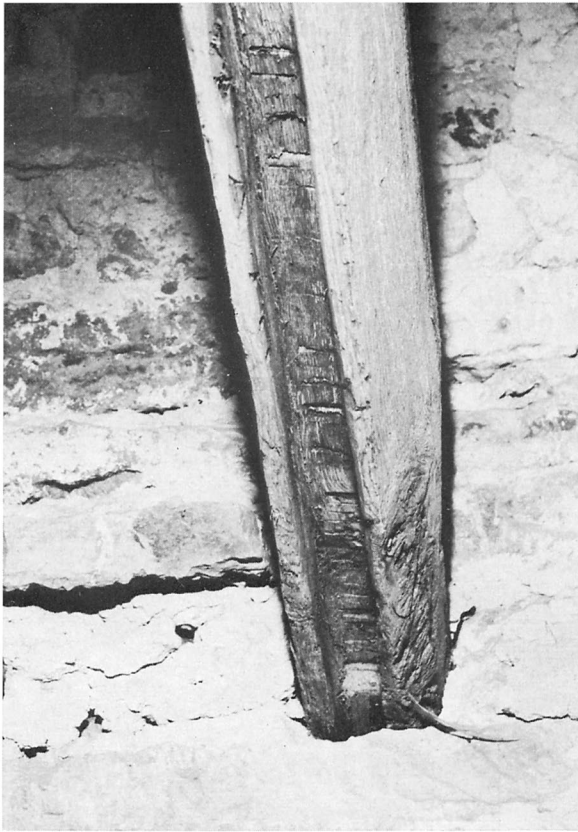
Fig 408. Detalj av nåten på stavkyrkokplankans undersida, med märken efter ett grovt huggjärn. Foto R Boström 1970. Detail of groove on the underside of the stave church plank, with marks of a broad chisel.
