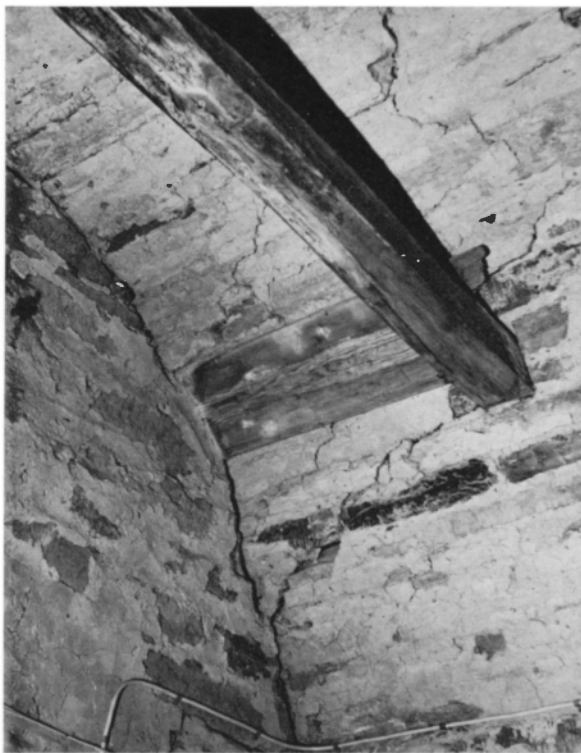
Fig 403. Fastklämd skålningsbräda i valvet över första tornvåningens västra kammare. Foto R Boström 1963.
