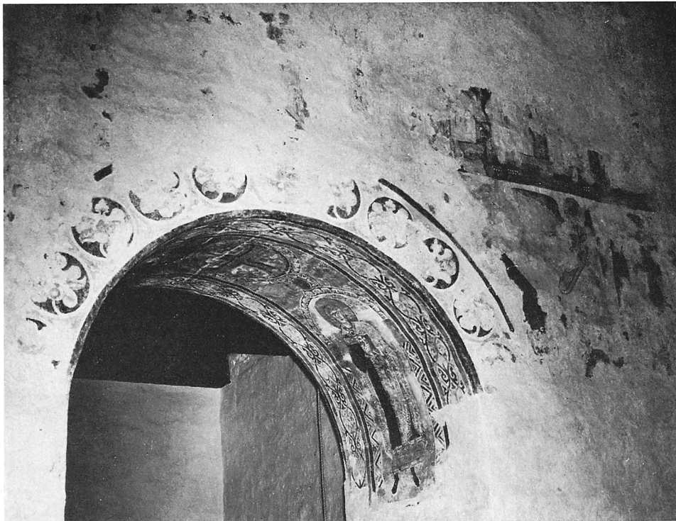
Fig 340. Långhusets västra vägg samt tornbågen med kalkmålningar från tiden omkr 1200. Foto 1969.
