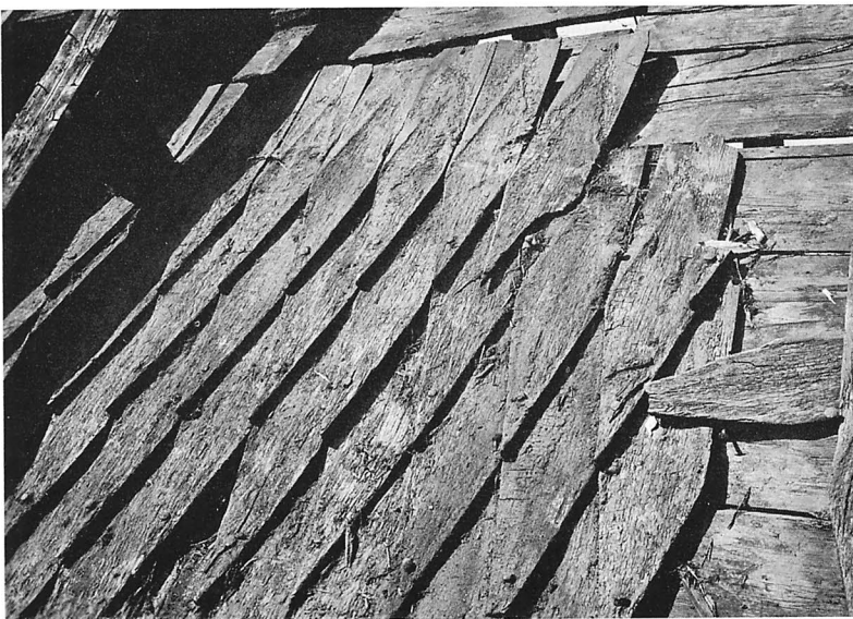
Fig 310. Medeltida ekspån på det romanska taket. Foto A Edle 1930.
