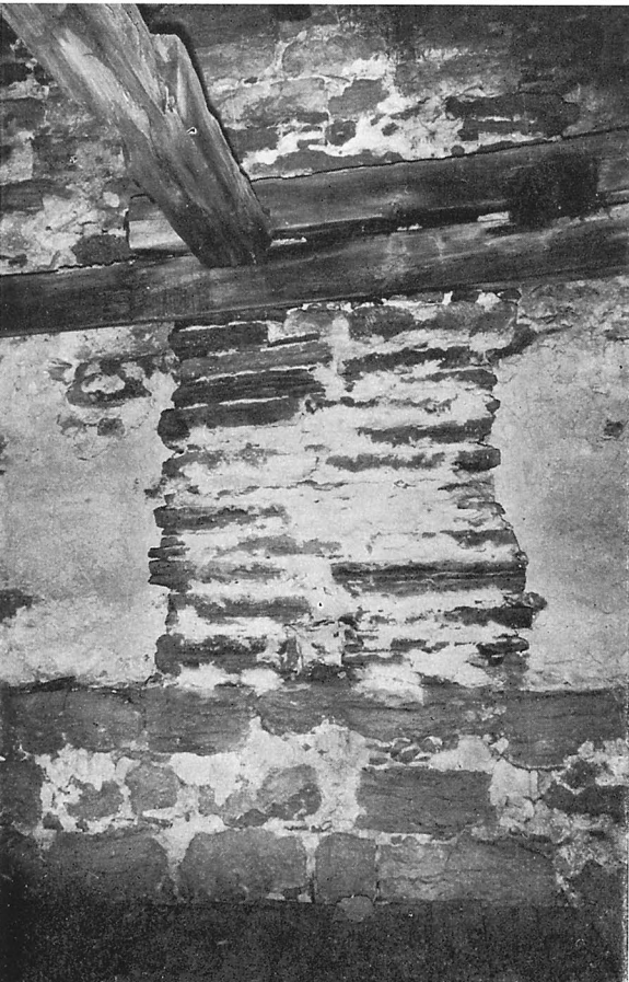
Fig 302. Igenmurning av ljudglugg i tredje tornvåningen, norra sidan. Foto R Engeström 1972.
