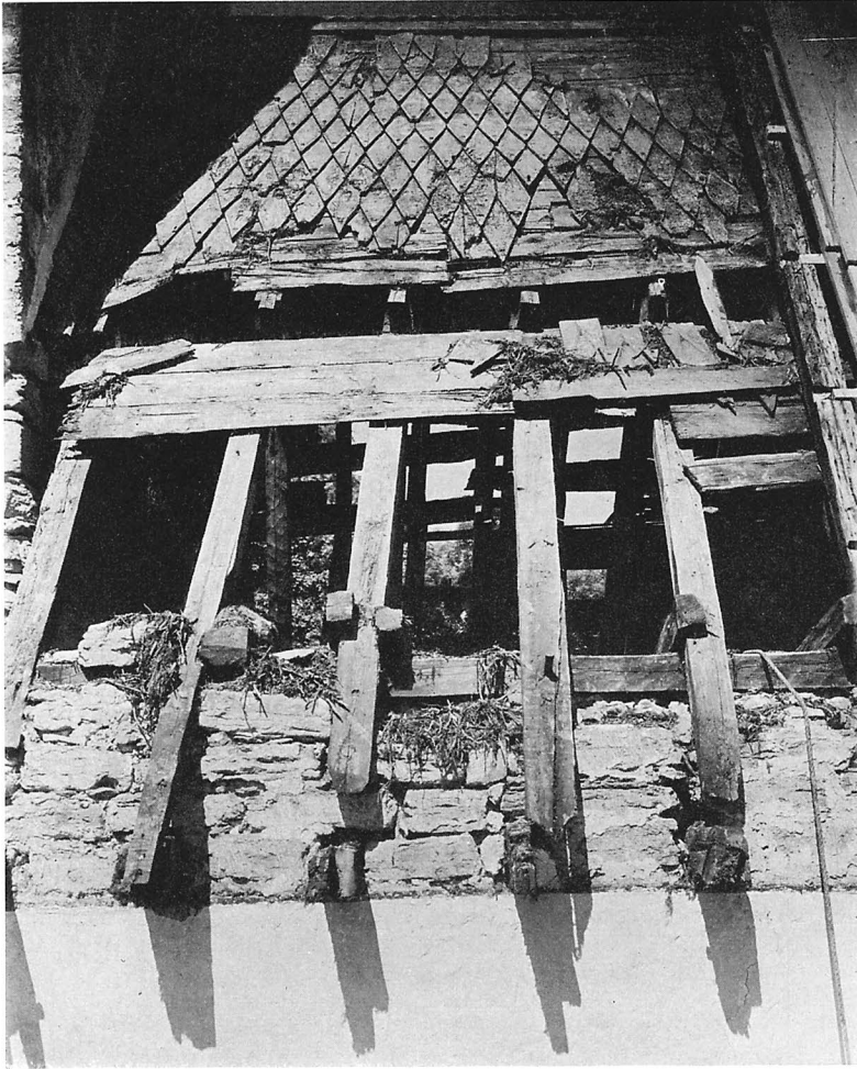
Fig 309. Den romanska takstolen vid en takomläggning 1930. Foto A Edle 1930.
