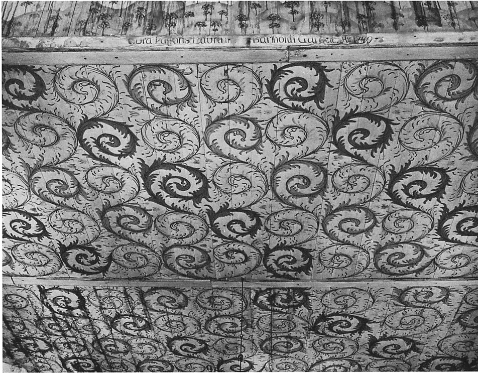
Fig 319. Långhusets innertak med målning daterad 1749. Foto N Lagergren 1960.
