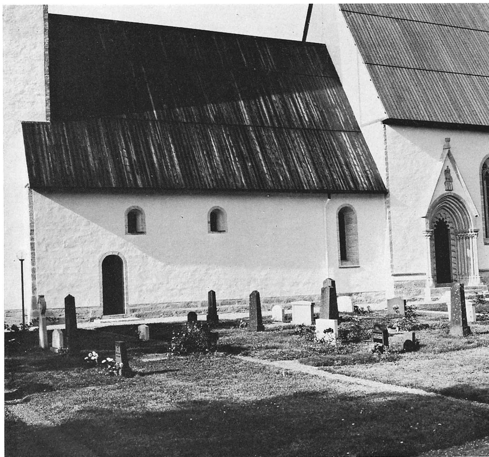
Fig 282. Långhusetets södra fasad. Foto 1969. S front of nave.
