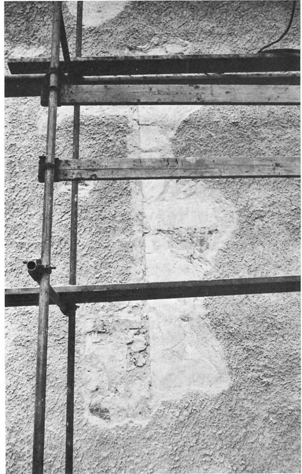
Fig 37. Hörnkedja i det romanska tornets nordvästra hörn. Foto R Bennett 1971.
