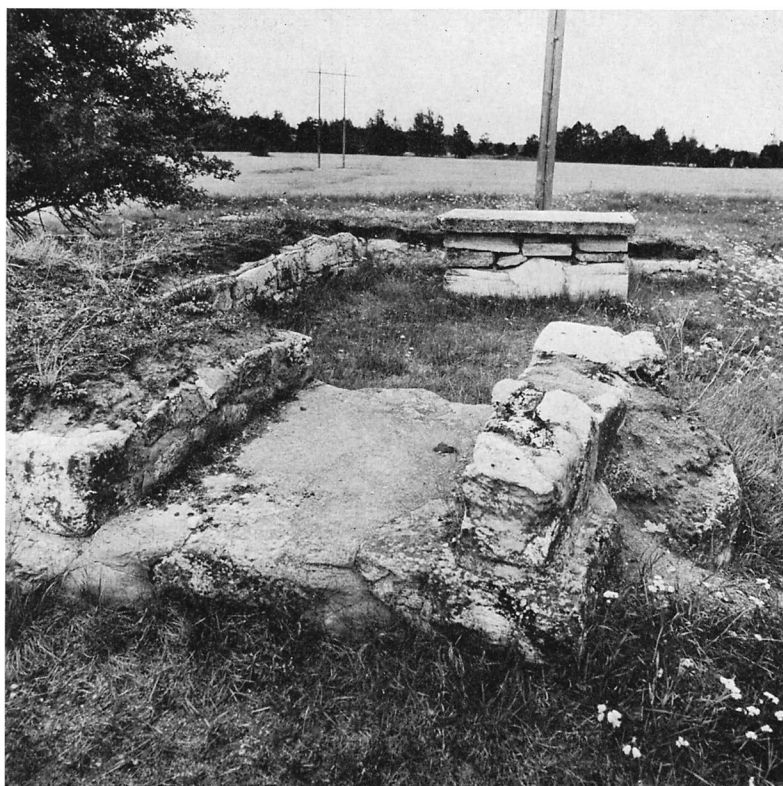
Fig 844. Kvarstående murar till Kullkyrkan i Mosås socken. I förgrunden den trånga triumfbågen. Foto 1971.
