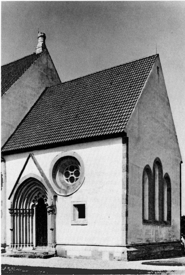
Fig 404. Koret från sydost. Märk den medvetna färgväxlingen i hörnkedjan, åstadkommen genom olikfärgad kalksten. Foto 1970.
