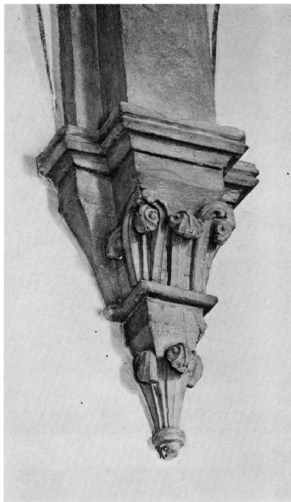
Fig 446. Långhusets norra konsol. Foto 1970.
