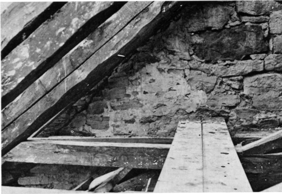
Fig 33–35. Långhusets västra gavelröste, insidan, samt två detaljer av densamma, södra delen, fotograferade i dagsljus under takomläggningen. Foto R Boström 1969.
