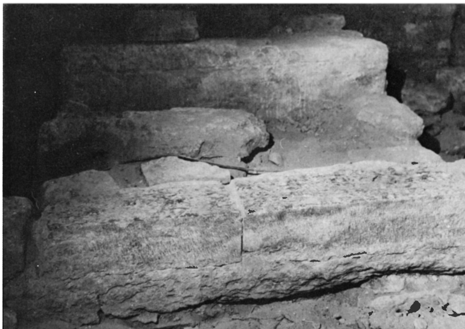
Fig 125–126. Framkanten till korpodium nr 2, av huggen sten med mycket nött översida. Sättsprickorna i fig 126 är orsakade av att stenen ligger tvärs över kanten till podium 1 a. Nederst i fig 126 är ett tunt vitt kalklager synligt, vilket markerar gränsen mellan det nedersta korgolvet (A) och den naturliga sandåsen. Foto R Boström 1969.
