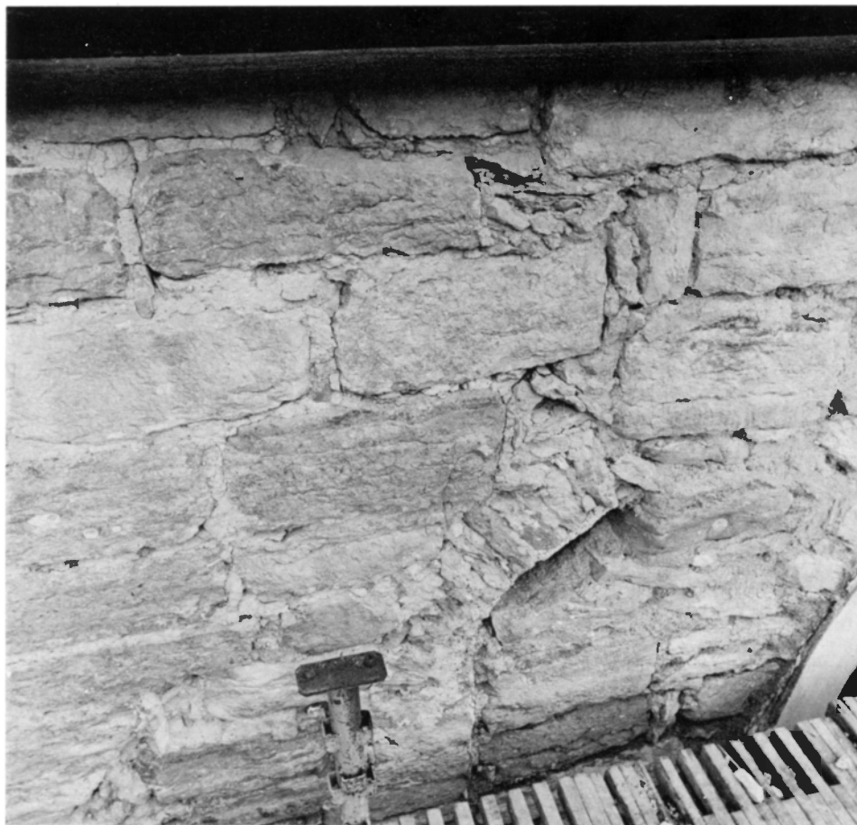
Fig 46. Rester av sekundärt fönster (T) i långhusets östra del (jfr fig 23, 196). Fönstret skjuter upp i den profana övervåningens murverk. Foto S Hallgren 1969.
