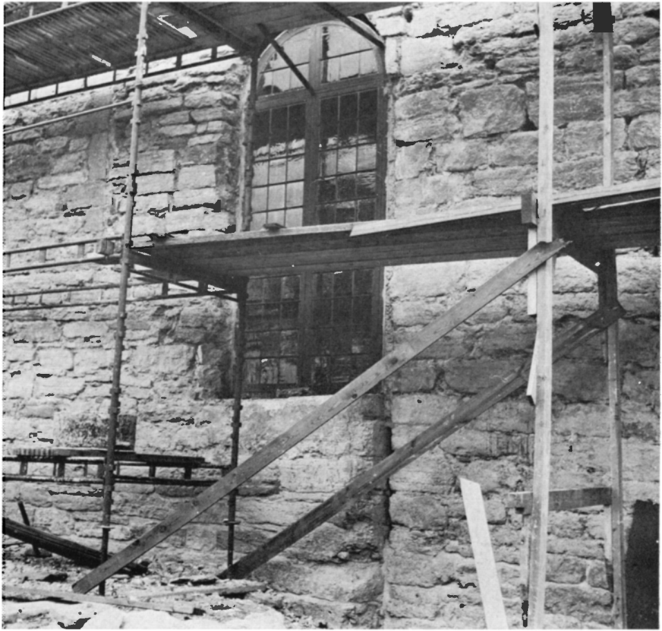
Fig 85. Stöttfogen mellan östtornet och långhusförlängningen (O) samt närmast angränsande murverk. Se även fig 159. Foto R Boström 1969.
