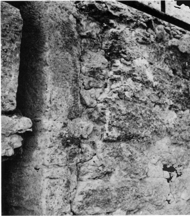
Fig 114–115. Senromanskt fönster (R) i östtornets- korets östgavel (jfr fig 24, 86, 106). På 1300-talet (?) ändrat till gotiskt (fig 27, 154).
