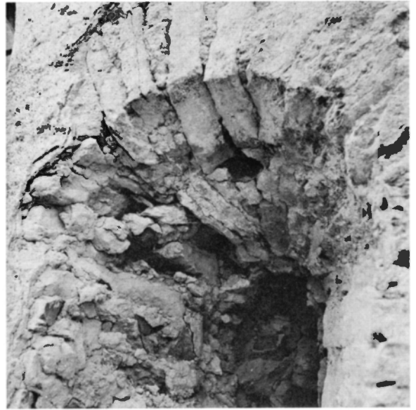
Fig 43. Valvet i fönstret (A) av vald kalksten. Foto R Boström 1969.
