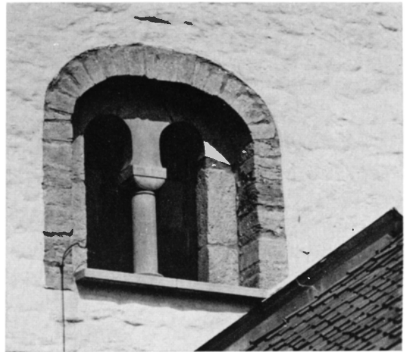
Fig 62. Östra ljudgluggen (L) med kolonnätt från 1937. Foto S Hallgren 1972.
