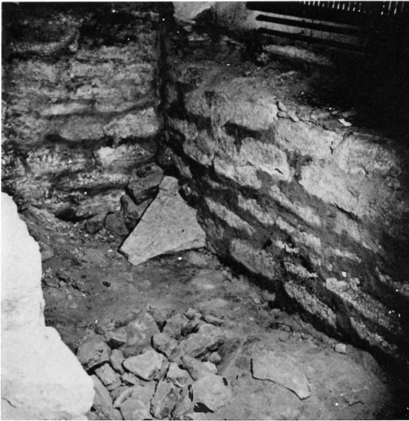
Fig 118. Östtornets-korets sydöstra hörn med det delvis rivna innerlivet. Foto R Boström 1969. — Numera är stora delar av detta parti dolda bakom de plintar som bär upp korgolvet.
