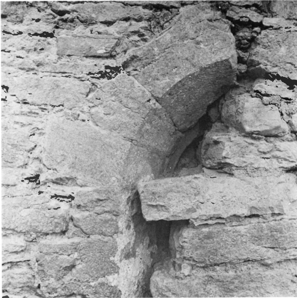
Fig 131. Detalj av fönstret (P) med omgivande murverk. Foto S Hallgren 1969.
