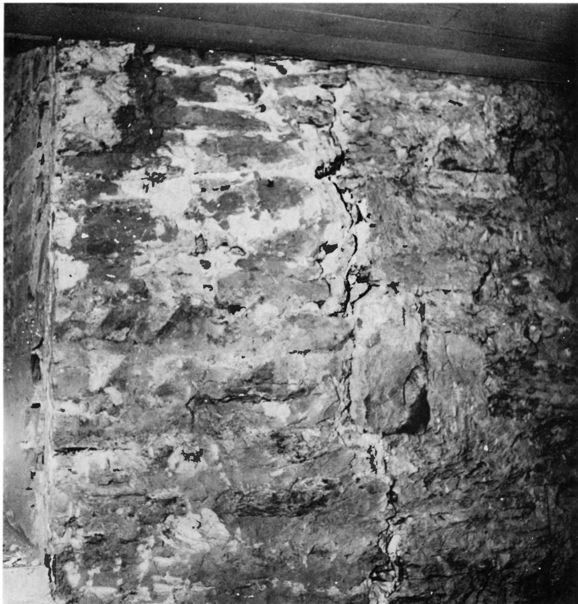
Fig 162. Senromanska målningsfragment på södra långhusväggen invid portalen (S), jfr kalkering i fig 163. — Th skarven mellan ursprunglig mur (spår av portal B?) och den sekundära portalen (S). Foto R Boström 1969.
