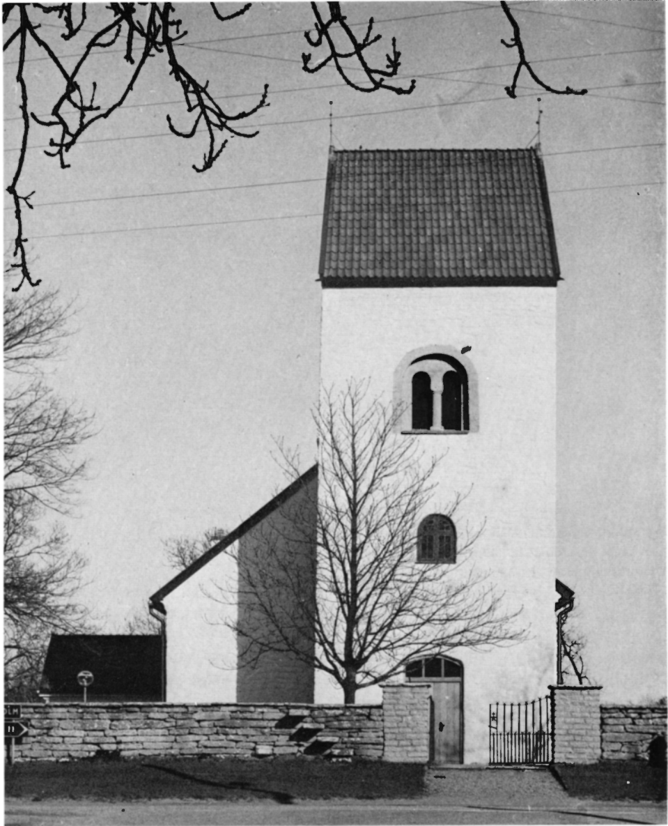
Fig 51. Västra kyrkogårdsingången med klivstätta (t v), bestående av i muren inskjutna hällar. I bakgrunden kyrkans västfasad. Foto R Boström 1972.
