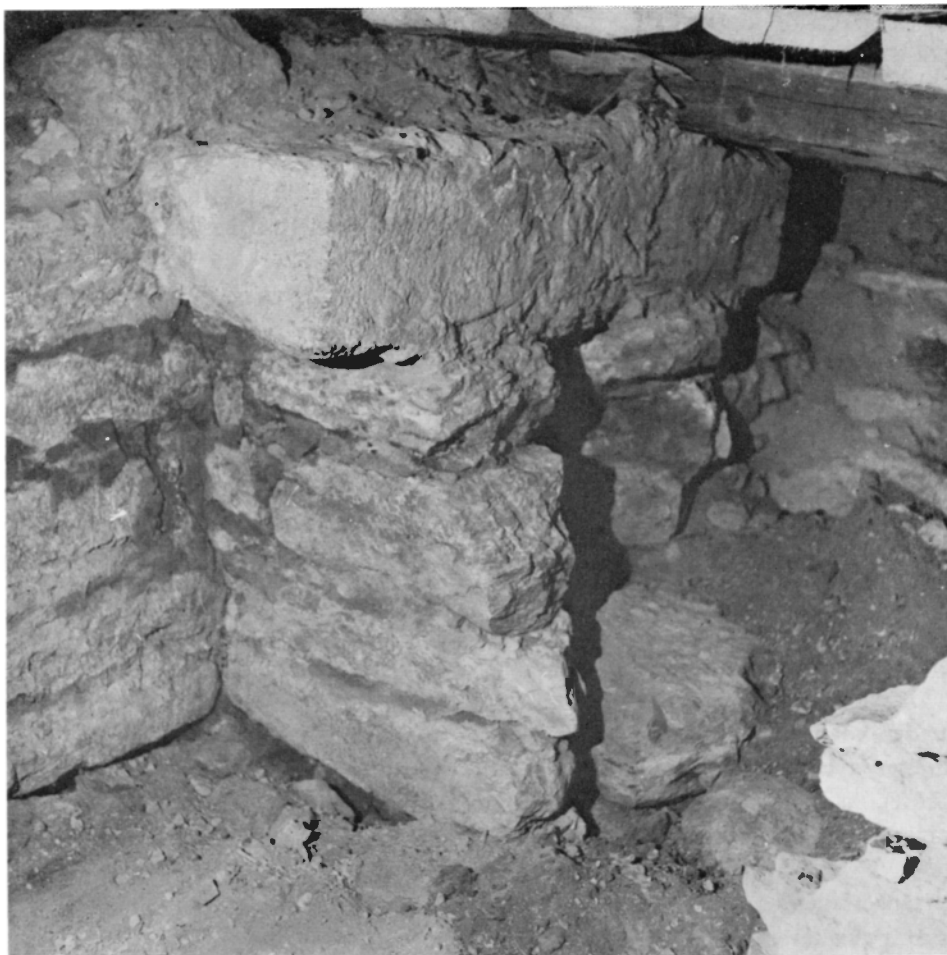
Fig 116. Östtornets-korets sydvästra innerhörn. T h om skuggan skymtar absidresterna. På detta murverk vilar en bas av huggen kalksten, hörande till vederlaget i triumfbåge nr 3. Jfr fig 26, 47, 82 C, 153. Foto R Boström 1969.
