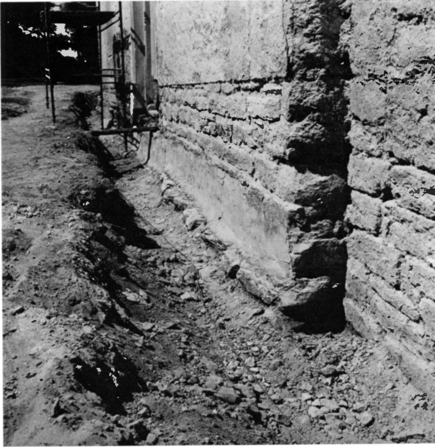
Fig 129. Långhusförlängningens sula efter isole-ringens. T h därom östtor-nets sydvästra hörn. Foto R Boström 1969.
