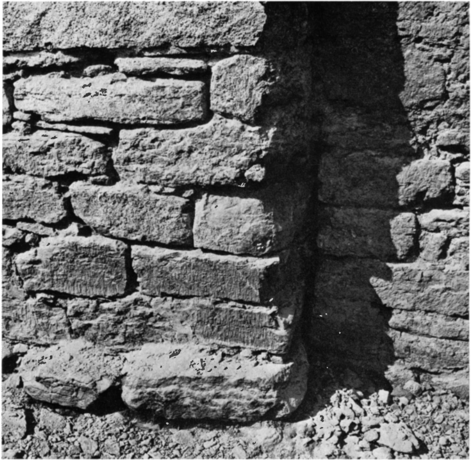
Fig 130. Detalj av långhusförlängningens sydöstra hörn med väl huggna kvadrer. Stöt-fogen (O) mellan långhusförlängningen och östtornet är en 3–4 cm bred springa. Foto R Boström 1969.
