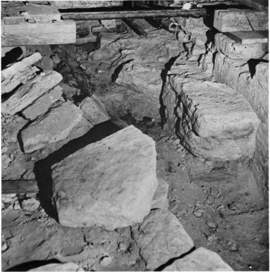
Fig 117. Östtornets-korets norra triumfbågsvederlag. Jfr fig 26, 48, 82 D, 153. Stenraden, som bildar en diagonal i bilden, är den s k gravmuren (fig 82: 5). Foto R Boström 1969.
