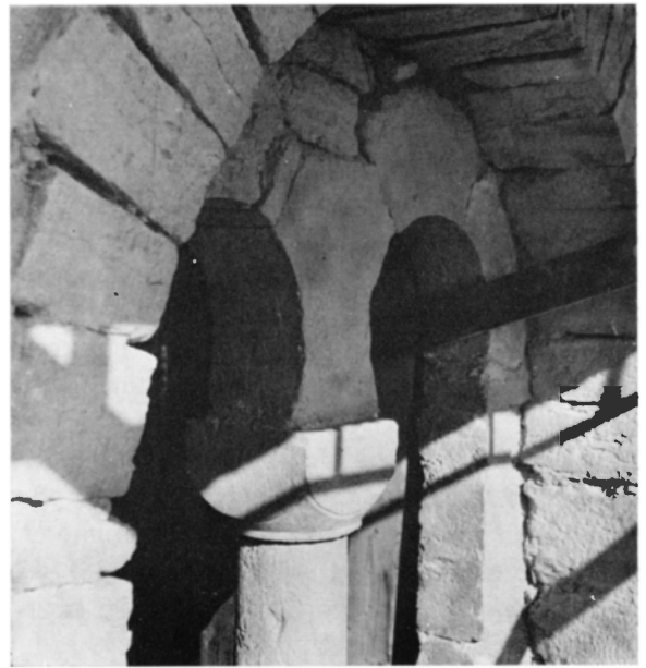
Fig 65. Södra ljudgluggen (K), del av omfattningen och kapitälet. Foto R Boström 1969. The S sound hole (K), part of the surround and the capital.
