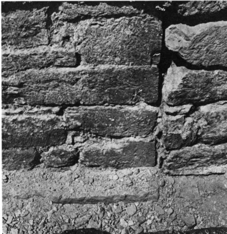
Fig 90. Detalj av kyrkans östra mur: Stötfogen (J) mellan östtornets nordöstra hörn och murverk från 1795. Foto R Boström 1969.
