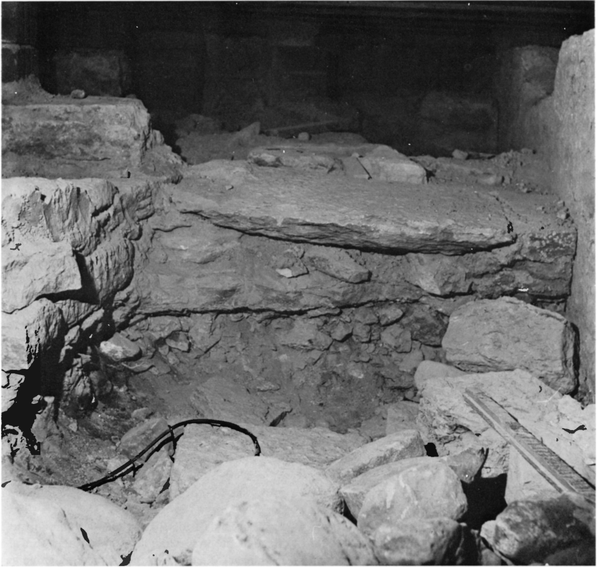
Fig 127. Korpodiets nordvästra del. Den slarvigt murade kanten i podium 1 a skymtar t v (jfr fig 123, 128). T h därom synes överst slitytan av kalkflisor i podium 1 b samt den fyllning av kalkbruk och sten som utgör dess underlag. Därunder syns tydligt som en mörk linje kontaktytan mellan podium 1 b och det understa kalkbruksgolvet (A), som är lika högt i hela koret. Längst t h östtornets nordmur. Jfr fig 119. Foto R Boström 1969.
