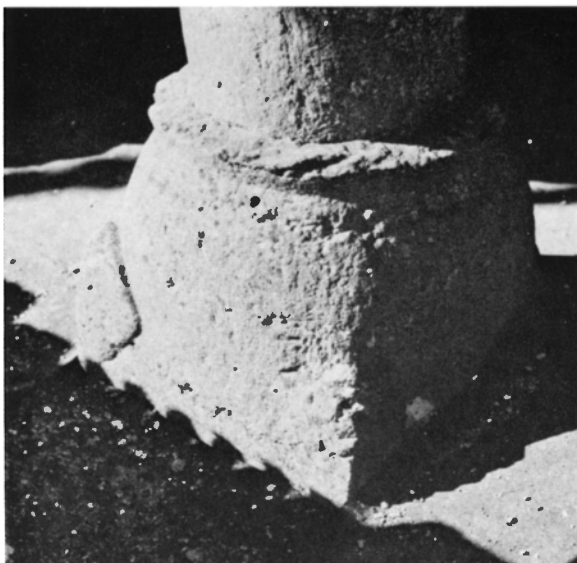
Fig 66. Södra ljudgluggen (K), kolonnettens bas. Foto R Boström 1969.
