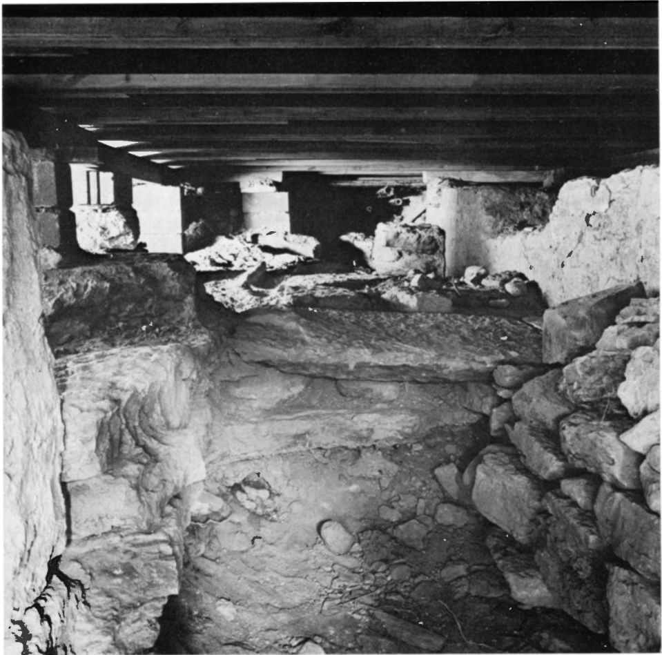
Fig 128. Källaren under koret mot nordväst (jfr fig 27, 127, 193). I fonden skimtar rester av absidkoret, något t h norra vederlaget till triumfbåge nr 3. Utmed norra östtornsmuren längst t h är numera de stora stenarna från det bortrivna korpodiet upptravade. Foto S Hallgren 1972.
