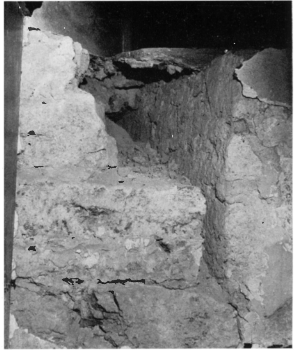
Fig 107. Fönstret (G), rester av innersmygens södra sida med bevarade, brett utstrukna fogar. Foto R Boström 1969.
