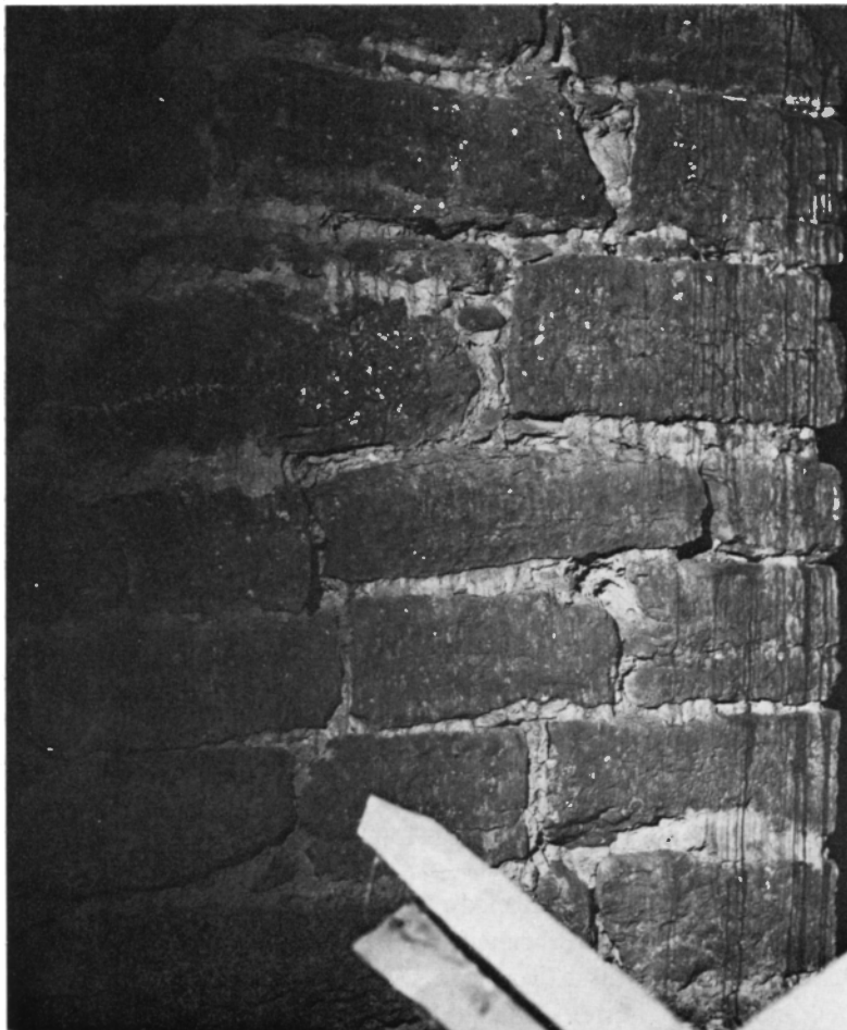
Fig 60. Murverket i västtornets mellersta parti (period IV B) med välhuggna kvadrer. Ett stycke av östra muren med östra ljudgluggen (L). I förgrunden skymtar en likbår från 1700-talet (?). Foto R Boström 1969.
