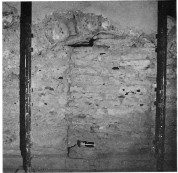
Fig 138. Del av tornbågens valv med svagt spetsig hjässa, sedd från läktaren (jfr fig 52). Dörröppningen tillhör troligen ombyggnaden 1795. Av allt att döma murades den igen helt 1892. Foto R Boström 1969.
