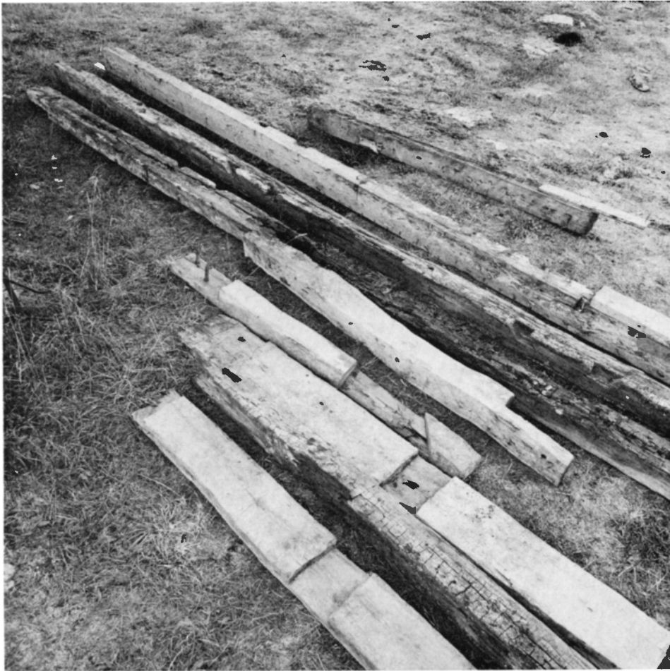
Fig 77. Rester av takstolar, sekundärt använda 1795 som regler i korgolvet, 1969 upplagda på långhusvinden. Jfr fig 78. Foto S Hallgren 1969.
