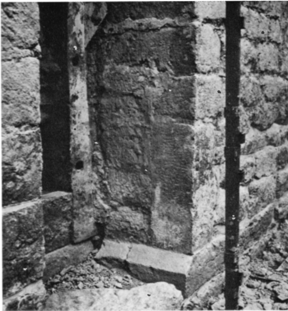
Fig 94. Korportalen (E), östra smygens nederdel med ursprungliga fogar. Foto R Boström 1969.
