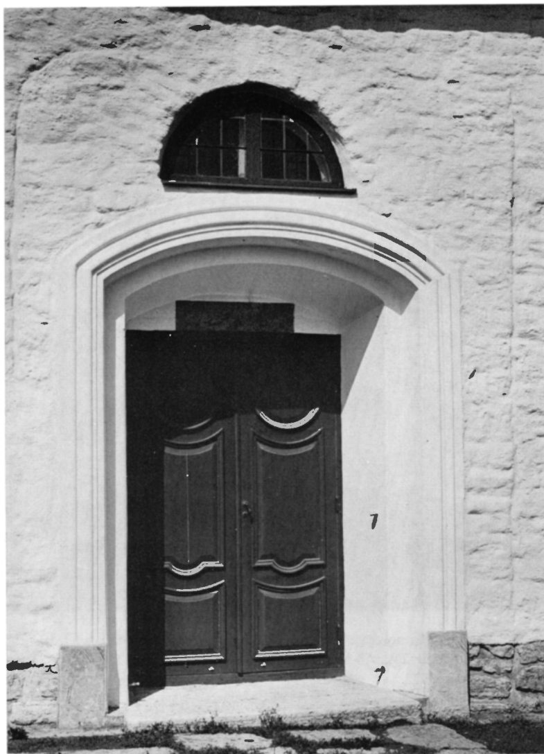
Fig 196. Långhusets stora sydportal från 1892 (Å i fig 23). T h skymtar det äldsta långhusets sydöstra hörn (C 1, fig 23), t v avtecknar sig resterna av ett fönster (T i fig 23, 46). Foto S Hallgren 1972.
