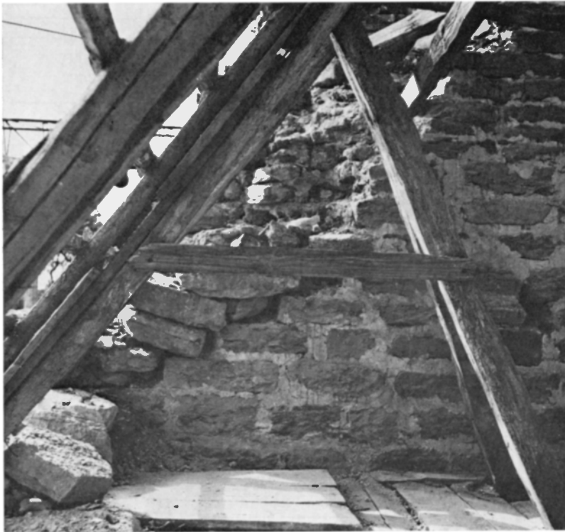
Fig 79. Västtornets södra gavelröste, insidan, och en del av takstolen (jfr fig 25). Bilden tagen innan murverket kompletterades och takstolen förstärktes. Foto R Boström 1969.
