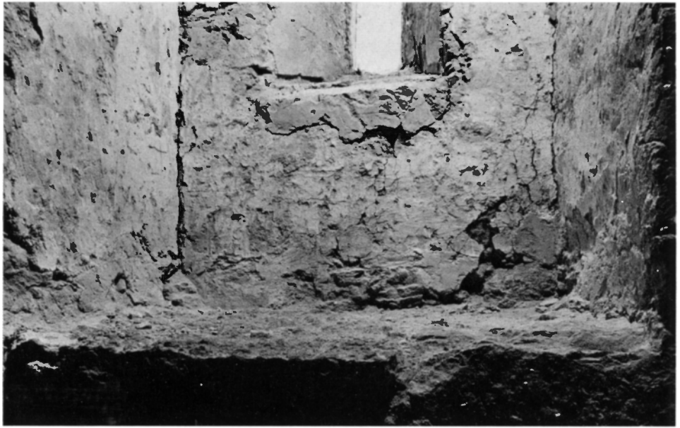
Fig 111. Detalj av sakristienischens södra smyg med ett inmurat virke, i vilket en skjutregel från en dörr har varit inskjuten. Foto R Boström 1972.
