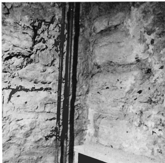
Fig 135. Långhusets sydvästra hörn under läktaren. Spår av kvaderrits på det äldsta murverket på ömse sidor om hörnet (jfr fig 32 samt 136). Tornbågens södra omfattning är av huggen sten (jfr fig 137). Th därom fyllnadsmur från 1795. Upptill skimtar en bärlina från en läktare, inmurad tvärs över tornbågen och byggd 1668 av Mattis Heijdeman (jfr fig 52 E). Dess överkant visar golvnivån i denna. Överst tv panelen under nuvarande läktare. Foto R Boström 1969.
