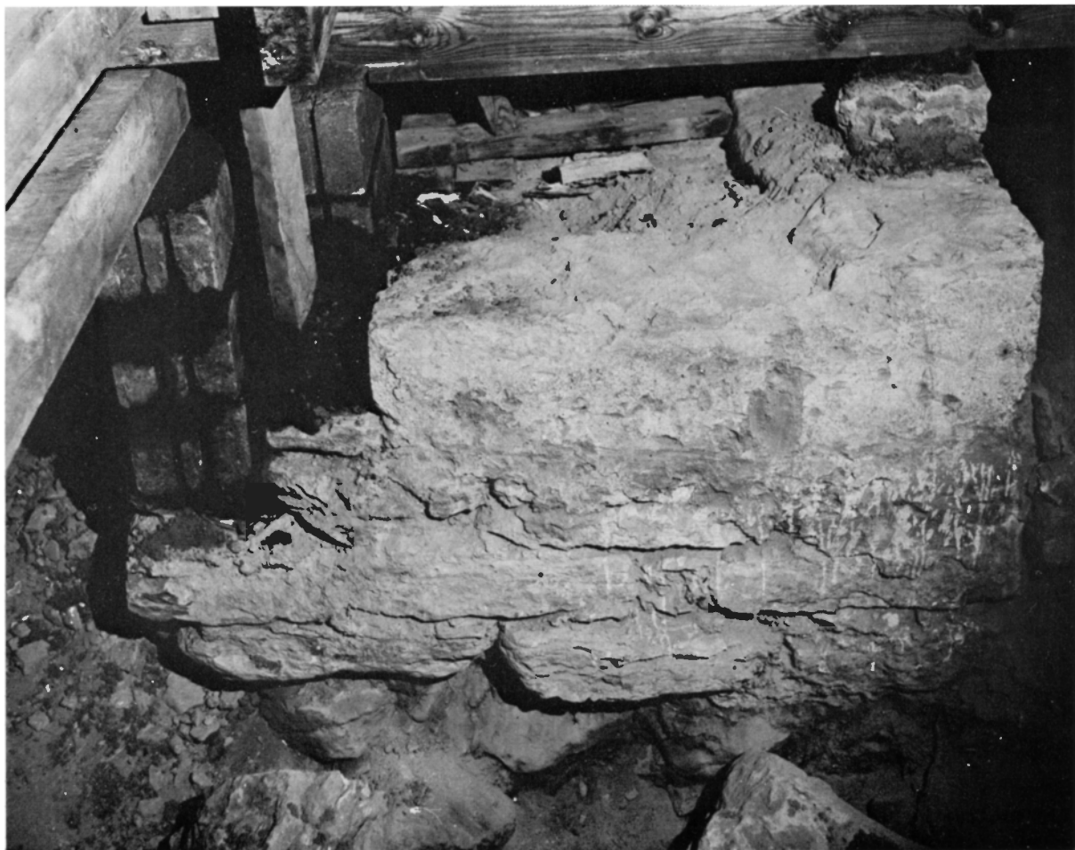
Fig 122. Det murade högaltarets norra sida. Jfr fig 124. En del av altaret har varit putsad och vitkalkad. Under en golvnivå har kalken runnit ned i långa strängar. Foto R Boström 1969.
