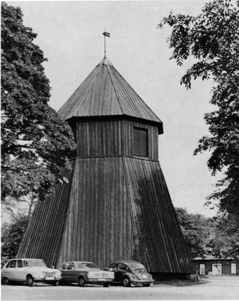
Fig 135. Klockstapeln, sedd från sydväst. Foto 1972.
