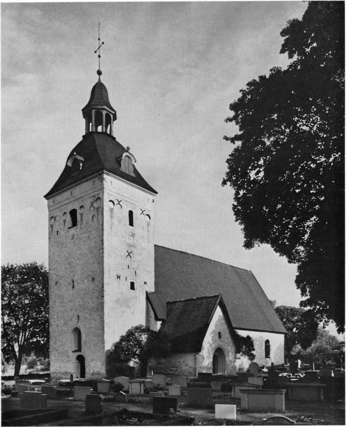
Fig 140. Ösmo kyrka från sydväst. Foto 1972. Ösmo Church from SW.
