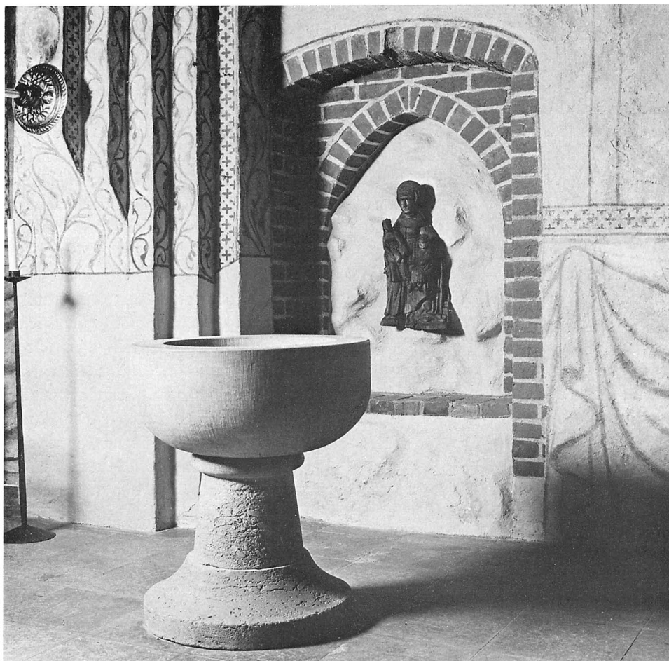
Fig 215. Dopfunt av kalksten. Foten gotländsk från omkr 1300, cuppan nyhuggen. I bakgrunden syns den framtagna omfattningen till 1300-talskyrkans korportal. Foto 1972.
