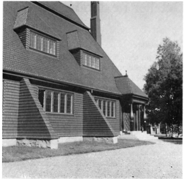
Fig 54–55. Norrfjärdens kyrka, ritad 1908 av Torben Grut. Nedbrunnen 1963 och ersatt av nybyggnad. Tätspröjsade fönstersnickerier var från början vitmålade. Foto G Lindahl 1962.
