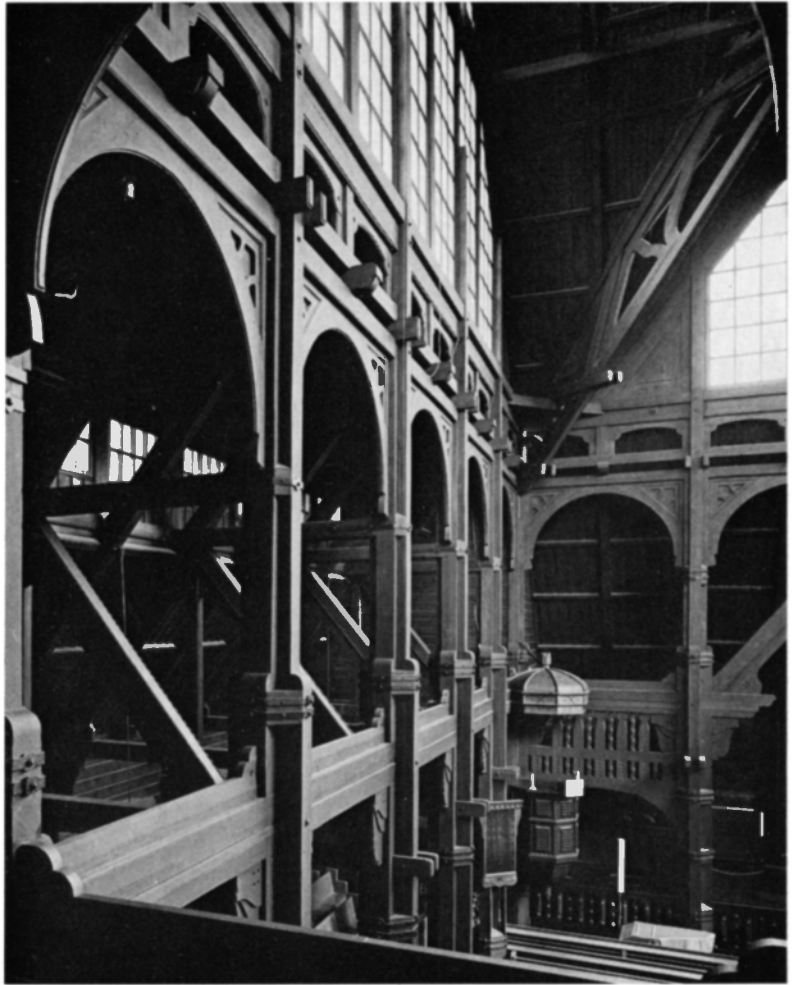
Fig 26. Detalj av sidoskeppets takkonstruktion, som stöder mittrummetts pelare. Foto 1971.
