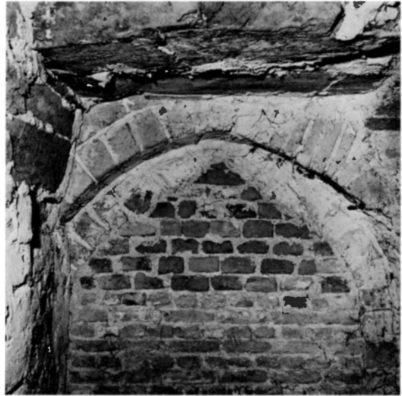
Fig 88. Igenmurad medeltida fönsteröppning i långhusets västra mur, synlig från trappan i tornets norra mur (jfr fig 89). Foto 1972.
