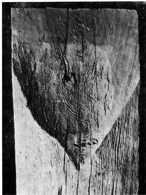
Fig 531. Detalj av väggplanka av furu, övre delen. Avsaknaden av tjära tyder på att den varit placerad i en sydvägg. Foto 1973.
