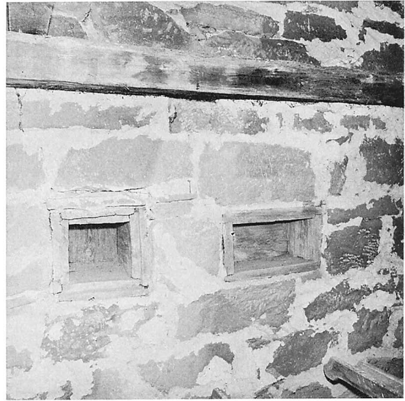
Fig 563. Brädfodrade nischer i tornets andra övervåning, östra väggen. Foto 1971.
