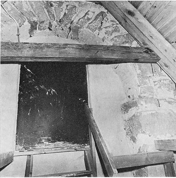
Fig 562. Avlastningsbåge samt ingång till tornet från långhusvinden. Foto 1971.
