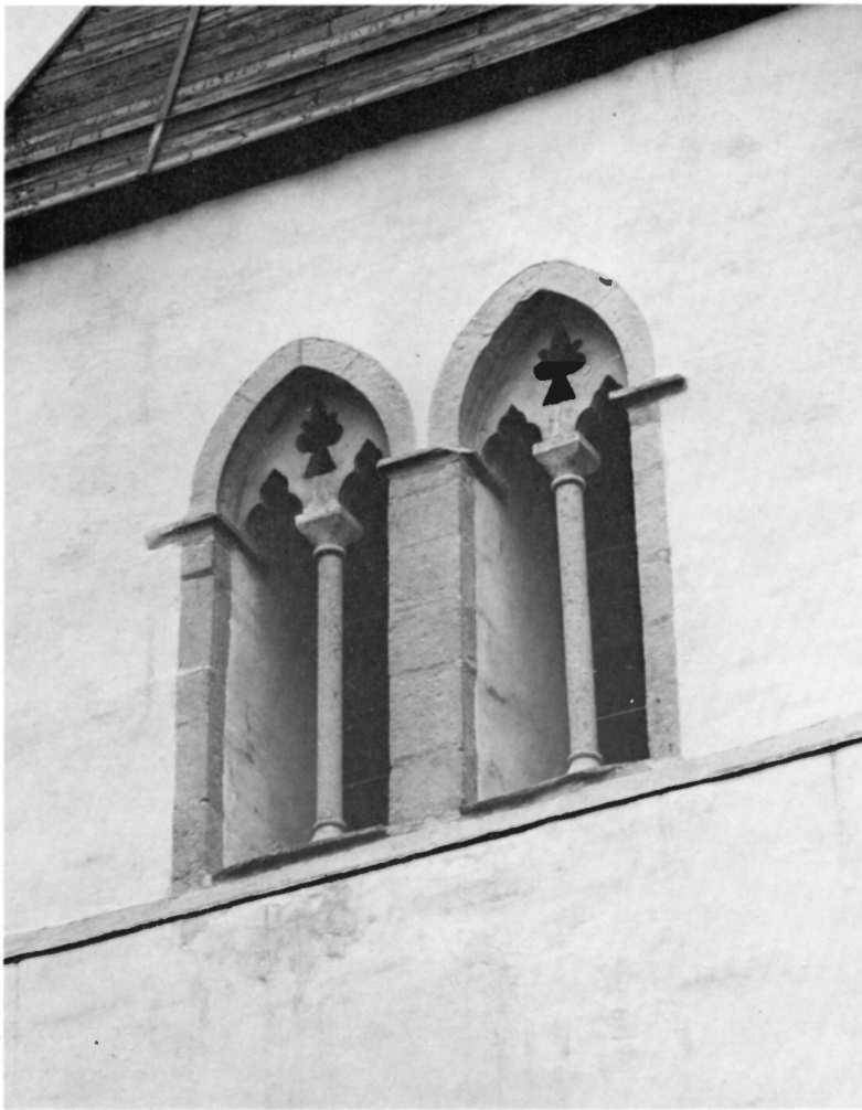
Fig 565. Kopplade ljudöppningar i tornets södra fasad, fjärde övervåningen. Foto 1971.
