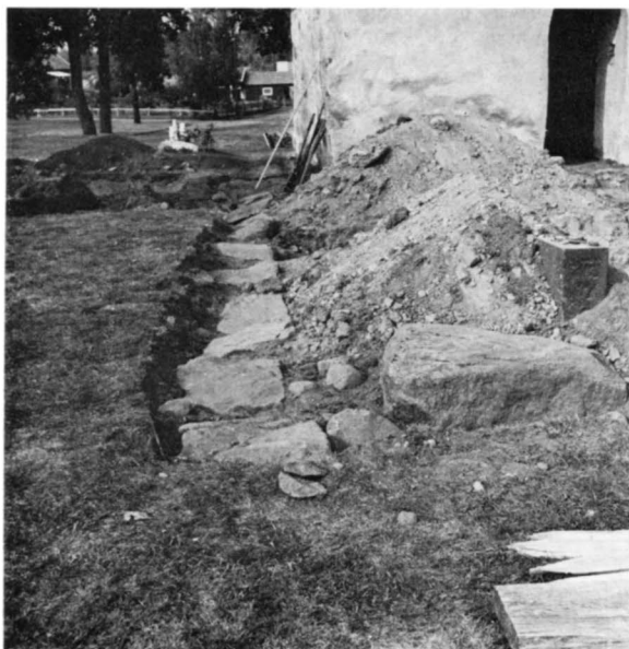
Fig 71. De vid grävningsundersökningen frilagda grundstenarna till triumfbågsväggen. Foto A Liepe 1973.
