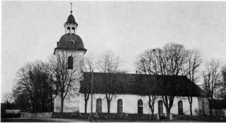
Fig 87. Kyrkan från öster innan portalbyggnaden framför östportalen uppförts 1916. Foto 1901. SM.
