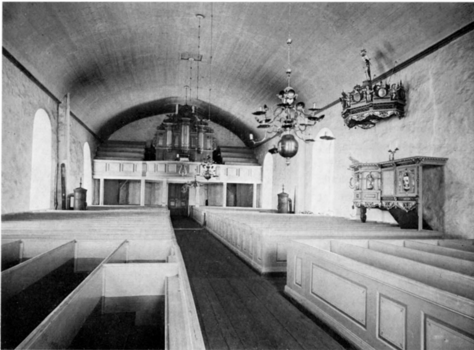
Fig 22. Interiör mot väster före restaureringen 1936–37. Foto 1923. ATA.
