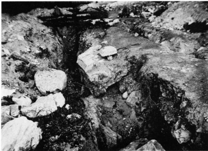
Fig 110. Grund till strävpelare i norra kapellradens norra vägg, sedd från nordväst (nr 8 på pl I). Rosmans bildunderskrift: »Murparti av Bykyrkan. Sockel med skråkant som vid kyrkans sprängning kastats utanför murlivet.» Foto G Weiden 1924.
