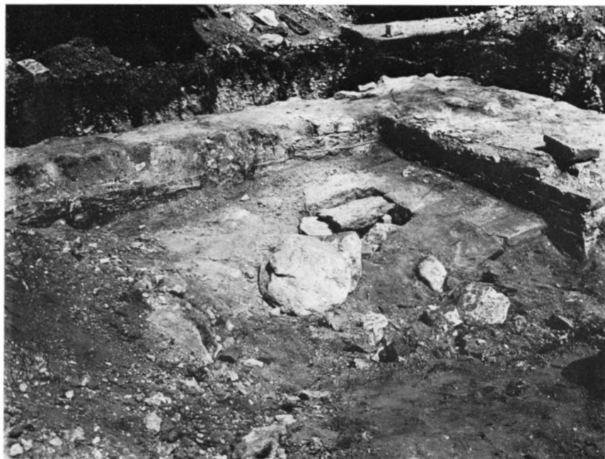
Fig 112. Samma parti som föregående fig 111 sedan utgrävningen framskridit mera; (foto 9b); nr 9 på pl I. »Murarna i nordöstra hörnet visa tydliga kalkstensmurar med ett invändigt lager av \frac{1}{2} stens tegel. I detta hörn påträffades golv av tegelsten» (Rosman s 29). — »I nordöstra delen sticka sockelstenarna utanför murlivet med 1 cm utan skråkant» (Rosman s 29, not). Foto G Weiden 1924.
