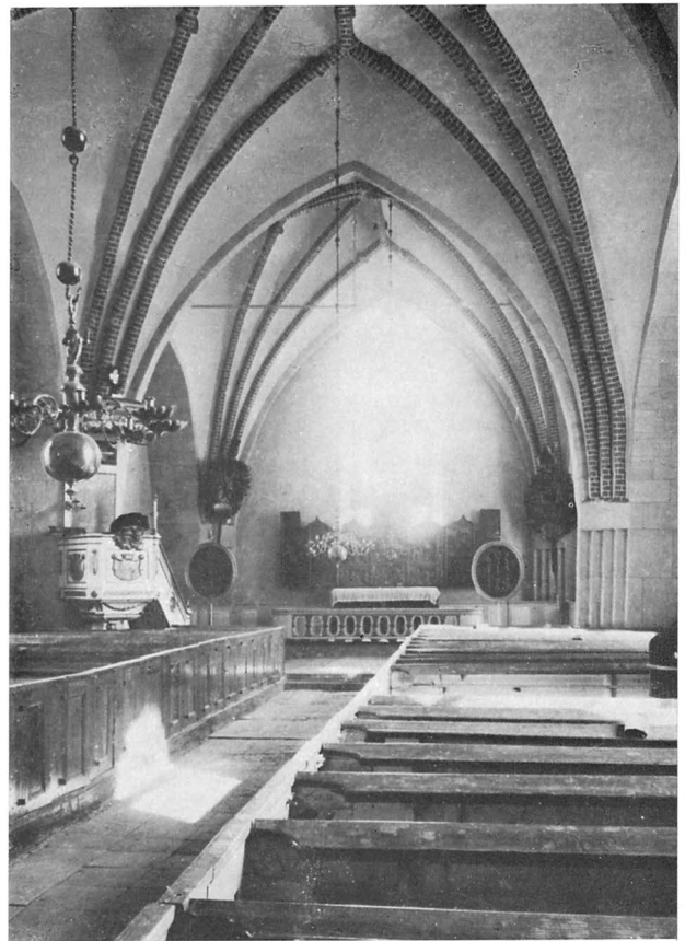
Fig 24. Interiör mot öster före restaureringen år 1903. Foto i ATA.
