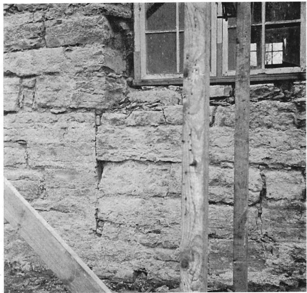
Fig 360. Resterna av den igenmurade, ursprungliga nordportalen. Foto R Boström 1959.
