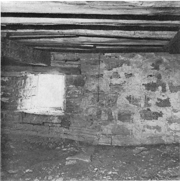
Fig 274a–b. Västtornets fjärde våning mot söder och nordväst. I valvgenombrytningen (från 1797) syns avtryck av en träkonstruktion (jfr fig 250). Foto R Boström 1963 resp S Hallgren 1973.
