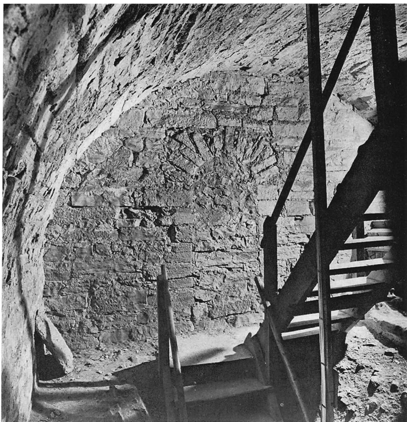
Fig 267. Det medeltida långhusets västgavel, sedd från västtornets andra våning med igenmurad ingång till den forna profanvåningen över det medeltida kyrkorummet. Foto S Hallgren 1973.
