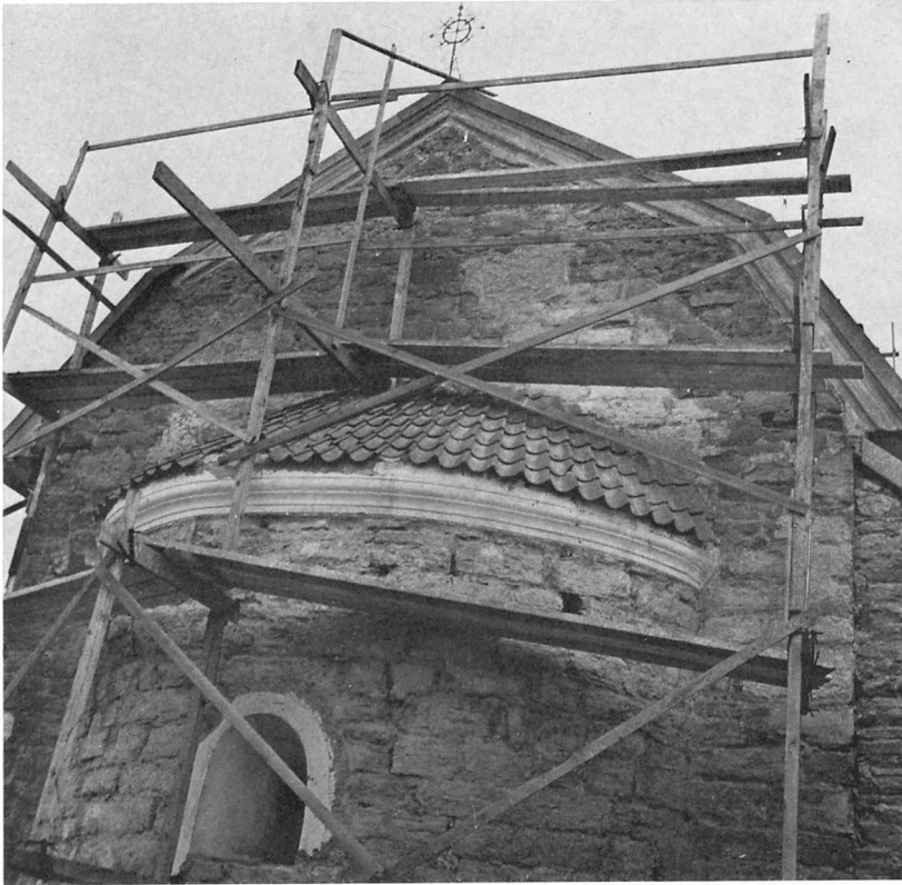
Fig 351 a–b. Korets murverk. a. Östra gaveln utan puts. Den ursprungliga gavelkonturen och den nordöstra hörnkedjan av huggen sten framträder tydligt. Foto R Boström 1959. — b. Ett stycke av nordmuren, sedd genom sakristians vindsglugg, Foto R Boström 1974.
