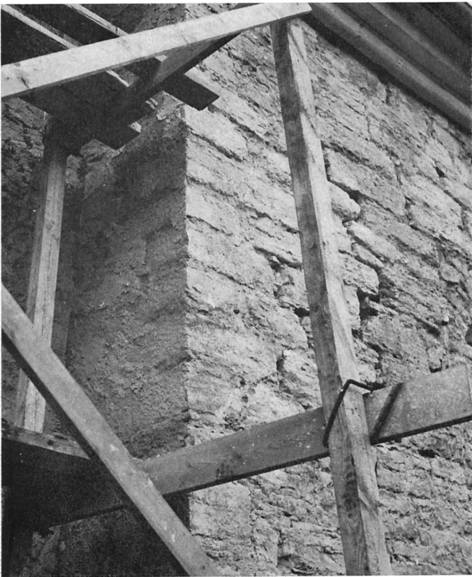
Fig 356. Ett stycke av långhusets sydvästra hörnkodja av finhuggna kvadrer. Foto R Boström 1959.
