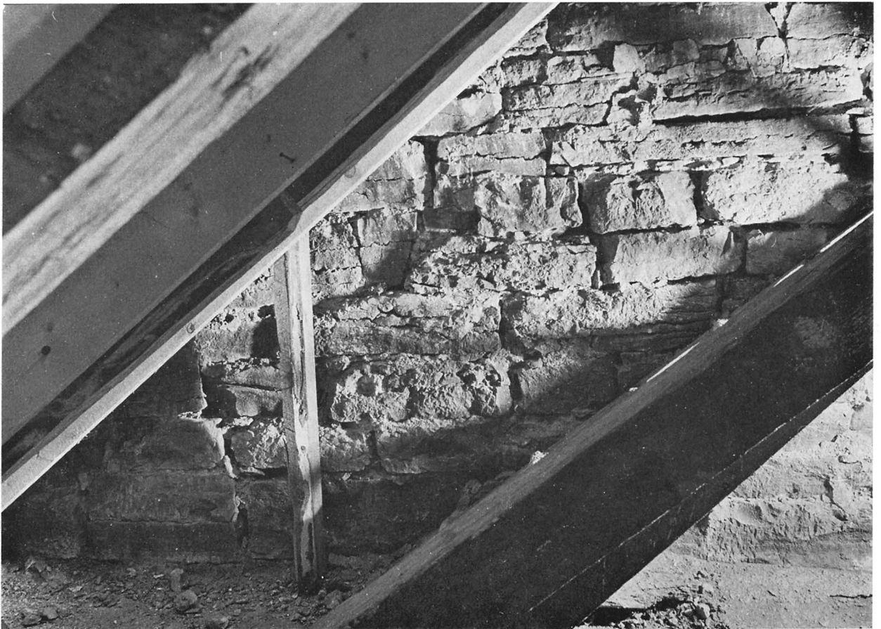
Fig 258. Utsidan av västtornets östra mur med den inbakade långhusgaveln. Foto S Hallgren 1973.
