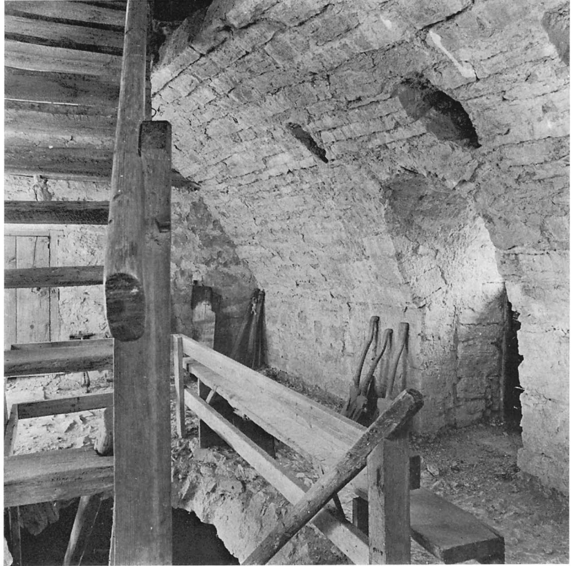
Fig 268. Avtäckning av murtrappan i västtornet. Detalj från andra tornvåningen. T h ljusglugg, t v rundbågig ingång till andra tornvåningen. Foto S Hallgren 1973.
