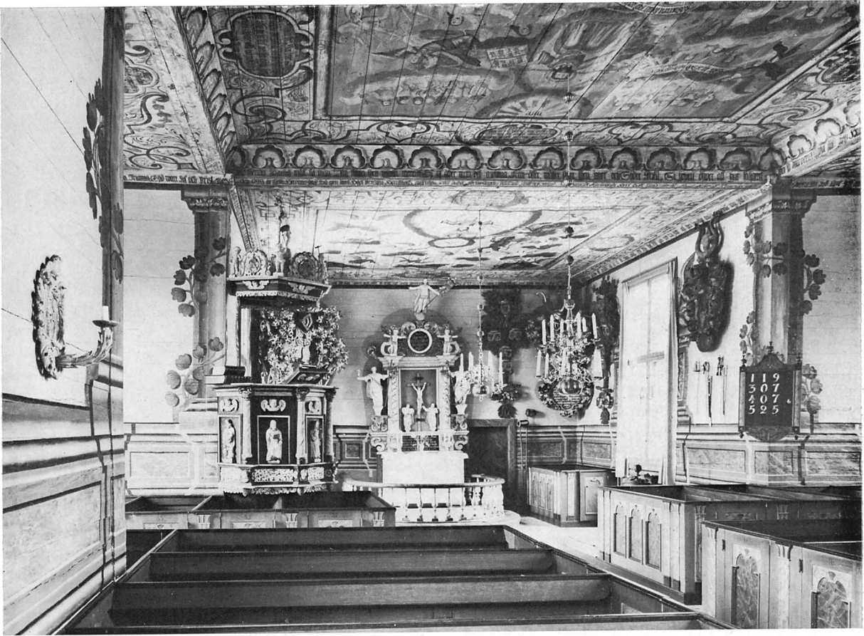
Fig 105. Interiör mot öster. Foto 1975. Interior looking E.
