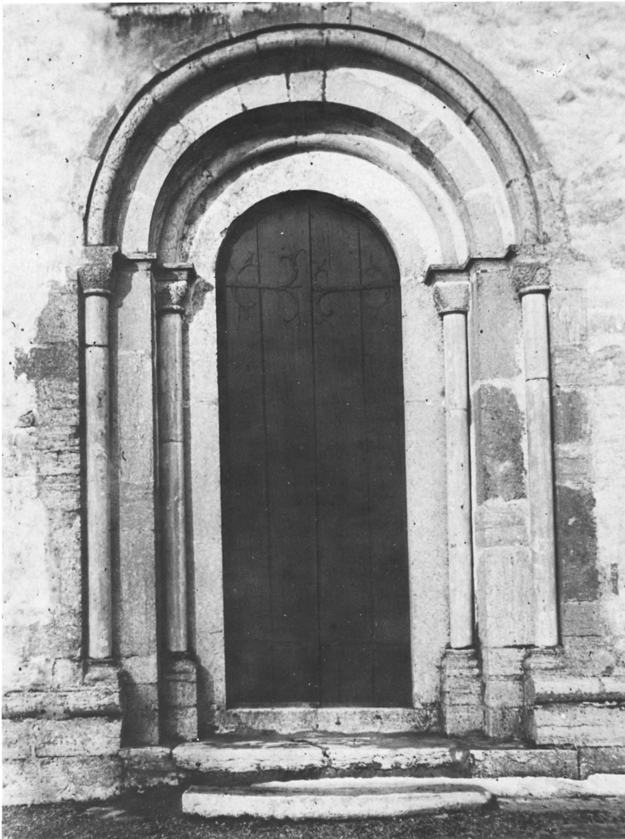
Fig 652. Långhusets sydvästra portal, 1200-talets andra fjärdedel. Foto ATA.
