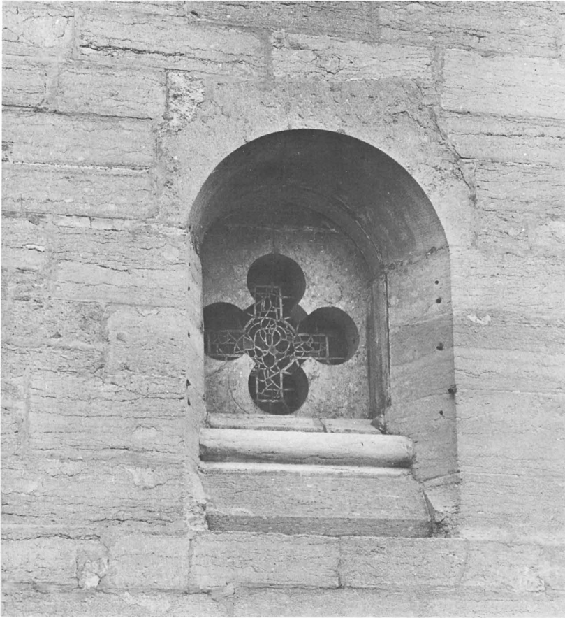
Fig 671. Fönster i det romanska korets södra korsarm, inmurat i det nuvarande korets sydmur. Foto S Hallgren 1964.
