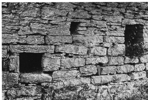
Fig 642. Prästgårdsruinen, rum I, västra väggen. Foto R Hejdström 1974.
