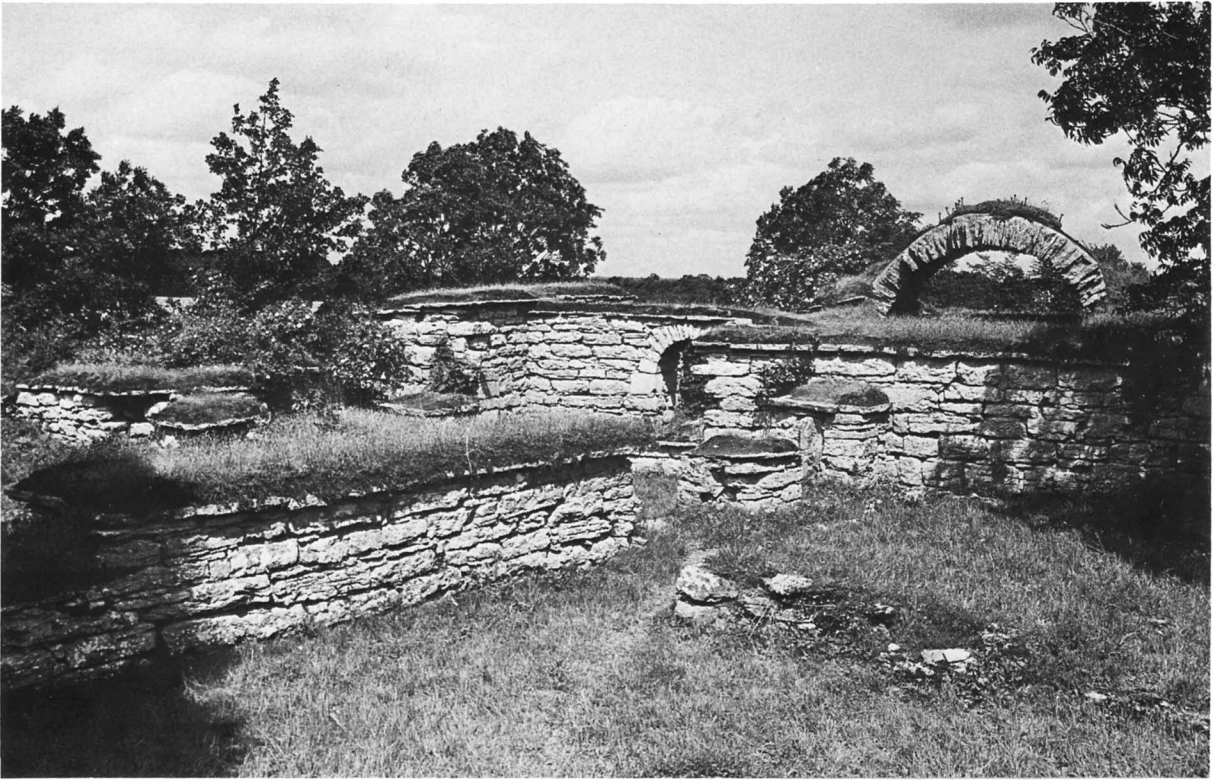
Fig 639. Prästgårdsruinen från sydost. Foto R Hejdström 1974.
