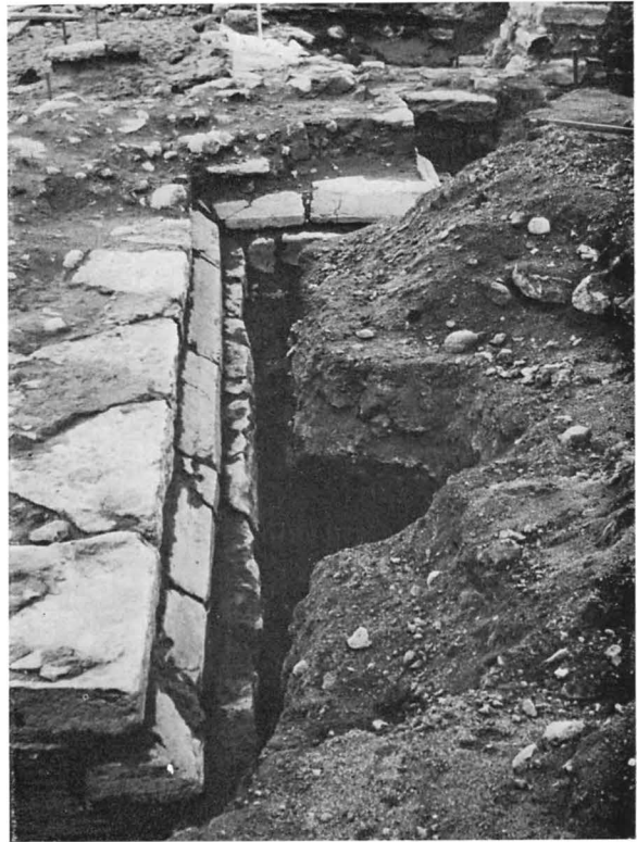
Fig 29. Sockelparti utmed tornets södra sida och långhusets sydvästra hörn. Foto T Billig 1971, ATA.
