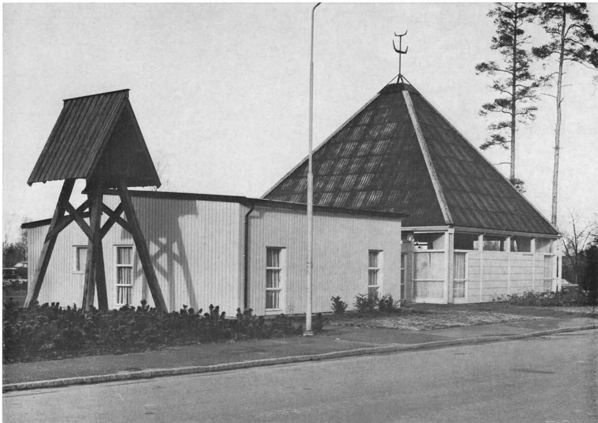
Fig 159. Hällabrottets kyrka. Prefabricerad småkyrka, s k Törebodakyrka. Tillbyggnaden av Jerk Alton 1974. Foto H Persson, Ateljé Stil, Kumla, 1975.
