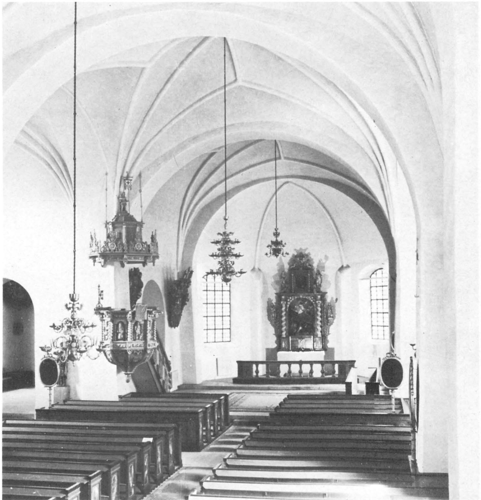
Fig 33. Interiör åt öster efter den av Ove Leijonhufvud ledda restaureringen 1938. Trävalven har ersatts med höga stjärnvalv av tegel, sidoläktarna har tagits bort, ny bänkinredning har tillkommit och kyrkorummets inredning har fått en ny färgskala, där rosa och grått dominerar. Foto i ATA.
