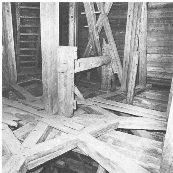
Fig 14. Tornkrönets bjälklag jämte hisstock som använts vid klockornas upphängning. Foto 1975.
