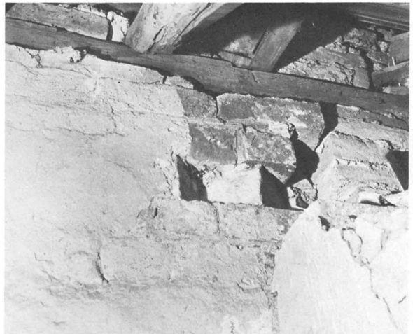
Fig 9. Medeltida påmurning med tegel av norra långhusmuren. Foto 1975.
