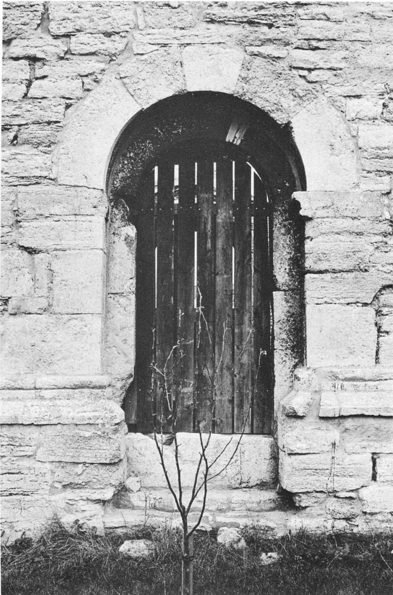
Fig 164. Långhusets norra portal. Foto R Hejdström 1976.
