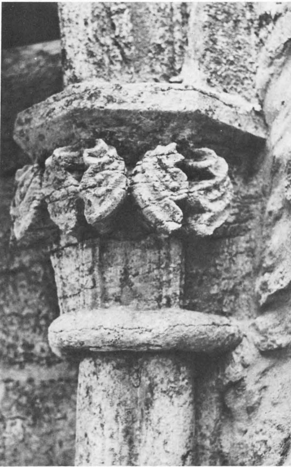
Fig 88. Kapitäl i korutsprånget mellan sydöstra och södra muren. Foto G Svahnström 1958.
