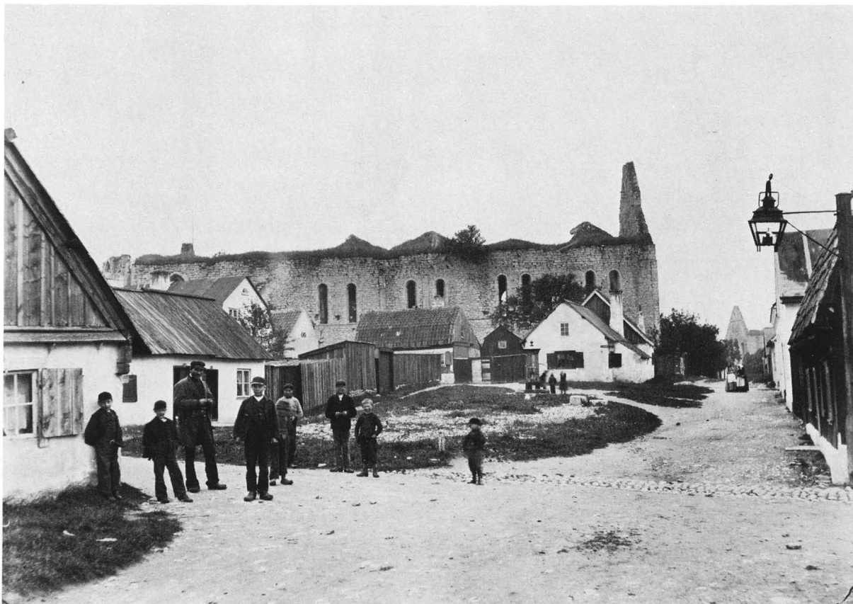
Fig 131. Ruinen från norr. I förgrunden "Norra pumptorget". Foto i ATA.
