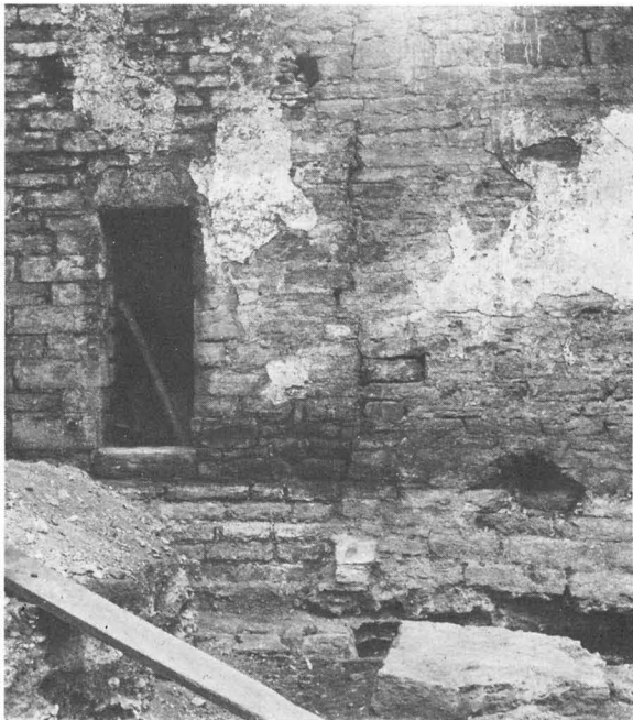
Fig 25. Södra murens insida i S2. I mitten skarven mellan mellankyrkans murverk till vänster och murverket i förlängningen åt väster till höger. Till vänster om skarven öppningen till trapprummet i södra muren. Foto A Edle 1913.
