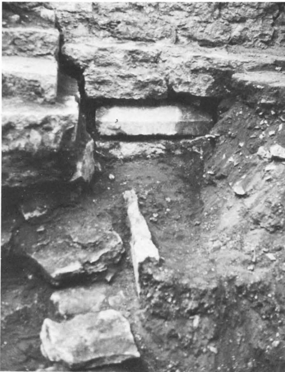
Fig 42. Hörnet mellan grunden till rakslutna kyrkans södra kormur, till vänster, och till östra muren i den nuvarande kyrkans södra sidoskepp. Observera att i sistnämnda grund ligger en huggen sten med skråkant, härrörande från mellankyrkans sockels nedersta skift. Foto E Bohrn 1934.
