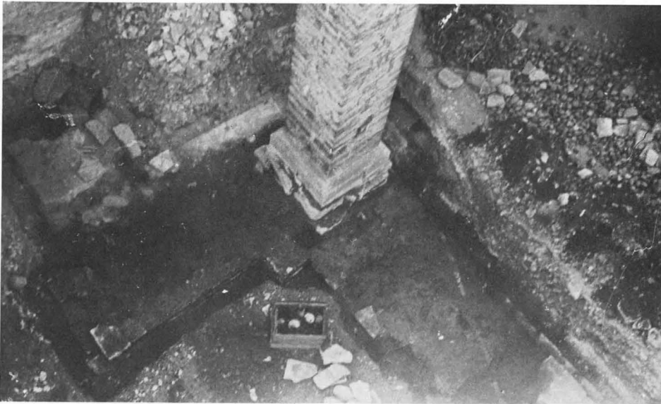
Fig 21. Grunden till mellankyrkans västparti med grunden till södra sidoskeppets västmur uppåt vänster och därefter torngrunderna. I mitten pelaren C2. Foto E Bohrn 1934.
