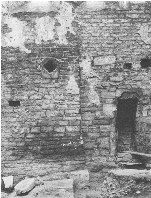
Fig 26. Norra murens insida i N2. I mitten skarven mellan mellankyrkans murverk till höger och murverket i förlängningen åt väster till vänster. Till höger om skarven ingången till trappan i norra muren och till vänster därom den från mellankyrkan härrörande sekundärt använda ljusöppningen till trappan. Foto A Edle 1913.
