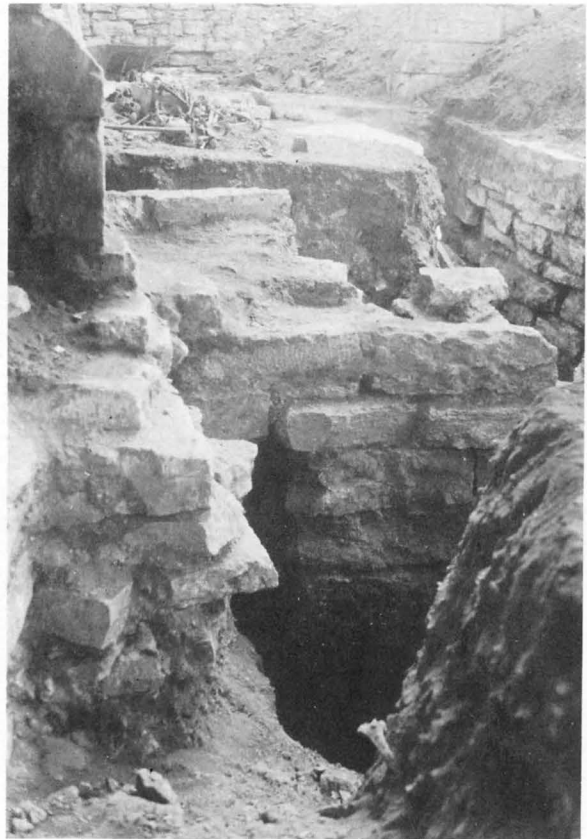
Fig 20. Grunder till östra muren i absidkyrkans aldrig utförda norra sidoskepp, sedd från väster. Observera den vertikala skarven synlig omedelbart till höger om den närmaste grundklacken. Foto E Bohrn 1935:
