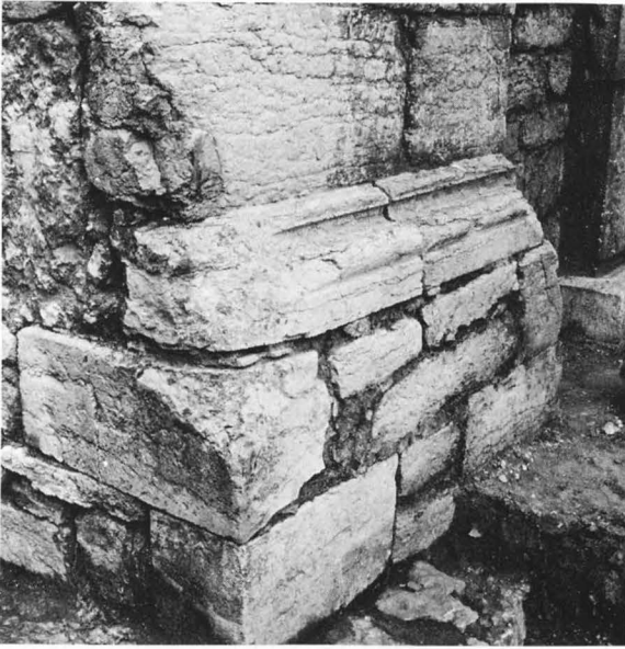
Fig 176. Basen till pilastern på östra sidan av bågen mellan koret och tvärskeppet. Observera basens krönlist som har samma profil som sockeln på långhusets södra mur mellan vapenhuset och korsarmen. Foto S Hallgren 1972.
