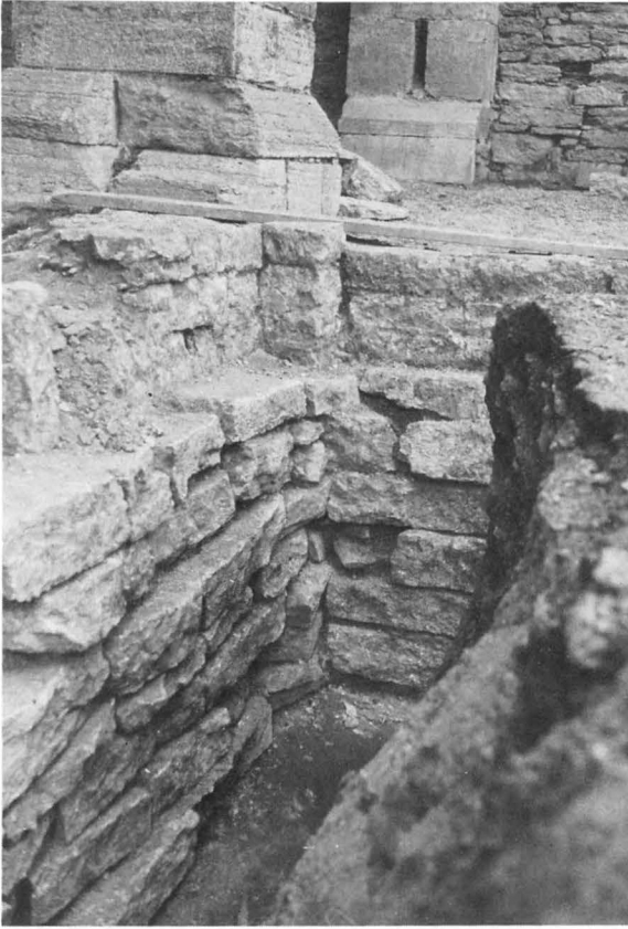
Fig 15. Grunderna till västra (t v) och norra kormuren i absidkyrkan. Upptill pelaren B5 och väggpilastern A5. Foto E Bohrn 1935.
