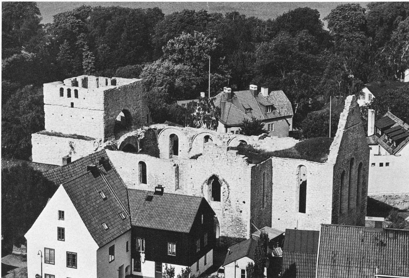
Fig 135. Exteriör från sydost. Foto R Hejdström 1976. Exterior from SE.
