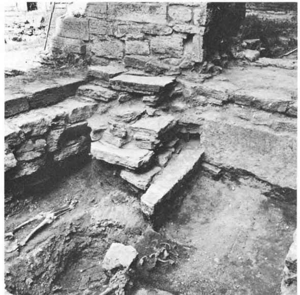
Fig 200. Grunderna till södra murarna i de bägge absidkoren, det äldsta längst till vänster. Grunden till det större absidkoret har till största delen brutits bort för en begraving. Foto W Falck 1972.
