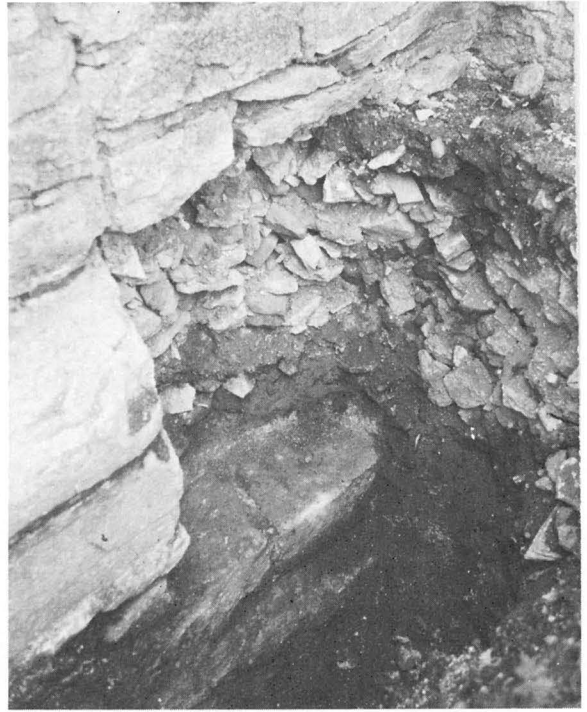
Fig 66. Parti av grunden till det nuvarande korets norra mur med resterna av en igensatt dörröppning, som med en trappa lett från ett välvat rum i vinkeln mellan koret och norra sidoskeppets östra mur. Djupast ned syns de nötta trappstegen. Foto E Bohrn 1935.
