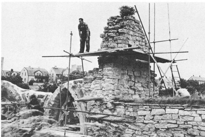
Fig 79. Södra delen av östra gavelröset från nordväst under konservering 1958. Omedelbart ovanför ställningen syns ett in i muren åt sydöst gående hål. Foto G Svahnström 1958.
