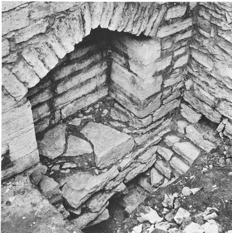
Fig 188. Grunden i sakristians sydvästra hörn samt nisch i dess södra mur. Foto W Falck 1972.
