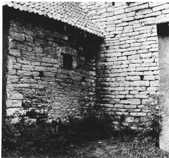
Fig 147. Hörnet mellan vapenhuset – till vänster – och långhusets södra mur. Under det kvadratiske fönstret syns igen-sättningen på platsen för en sekundär ingång till vapenhuset. Foto S Hallgren 1972.
