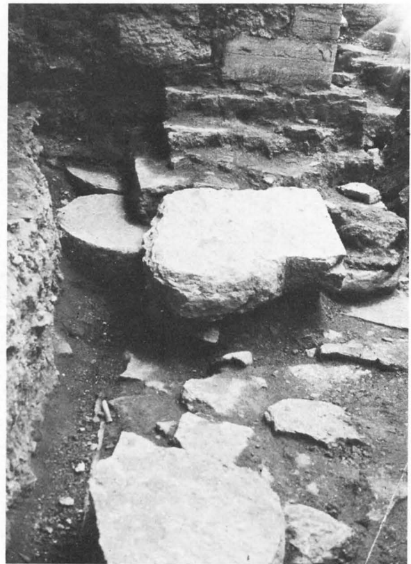
Fig 44. Grunden till norra kormuren i rakslutna kyrkan, sedd från väster. Observera de två kolonntrummorna till vänster. Högst upp hörnet mellan nuvarande norra sidoskeppet och koret. Foto E Bohrn 1934.
