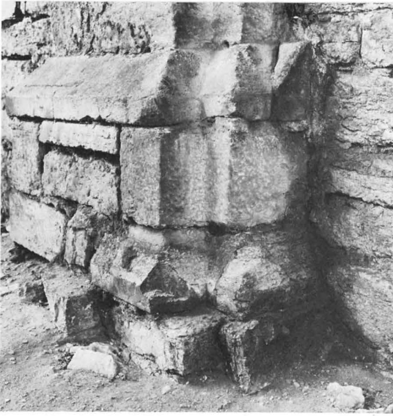
Fig 85. Sockeln under väggpilastern D5, sedd från nordväst. Den nedre skråkantssockeln anger läget för mellankyrkans sydöstra innerhörn och torde ligga i ursprungligt läge. Foto R Hejdström 1974.
