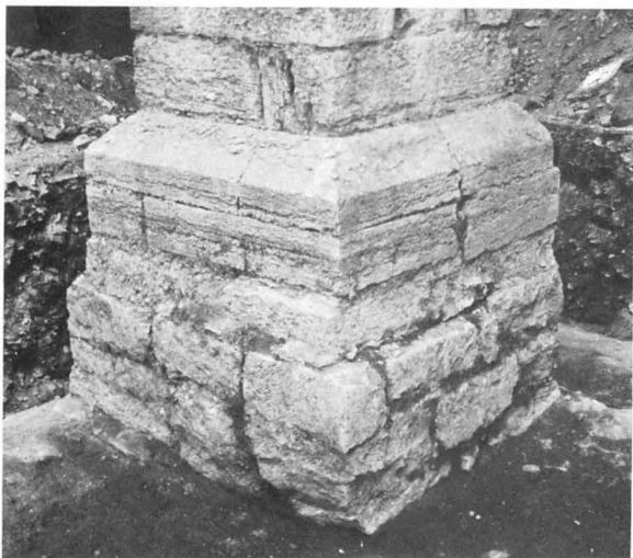
Fig 28. Grunden till pelaren B2 från sydöst. Foto E Bohrn 1934.
