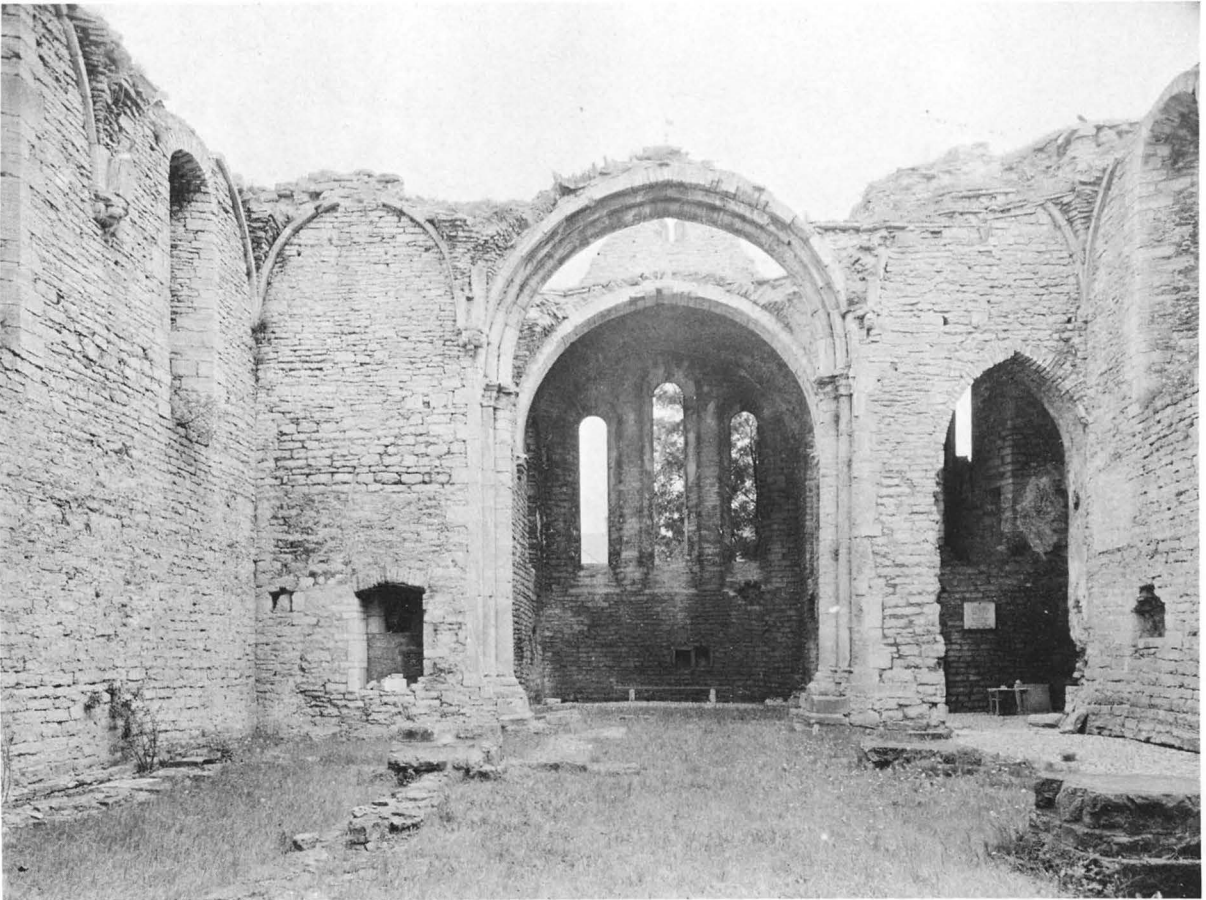
Fig 170. Långhuset mot öster. Till höger öppningen till korsarmen och till vänster nischen i långhusets östra mur. Närmast till höger grunden till långhusets sydvästra kolonn. Foto H Faith-Ell 1931.
