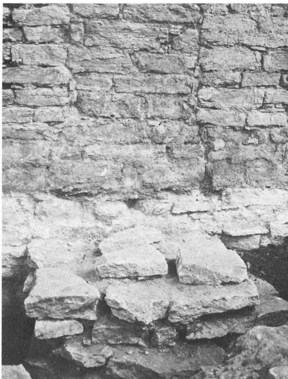
Fig 30. Grunden till bortbrutna väggpilaster i N4. Foto E Bohrn 1935.
