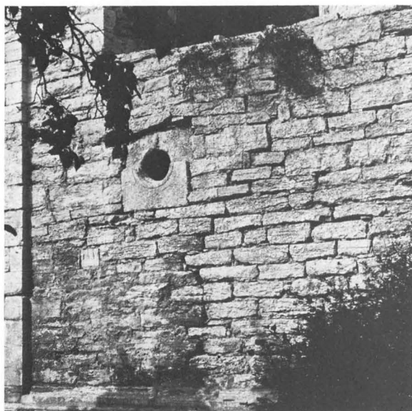
Fig 76. Parti av sydfasaden under fönstret i S2 med skarven mellan mellankyrkans murverk till höger och murverket från förlängningen åt väster till vänster. På bilden syns också den sekundärt använda ljusöppningen till trapprummet med ingång från S2.
