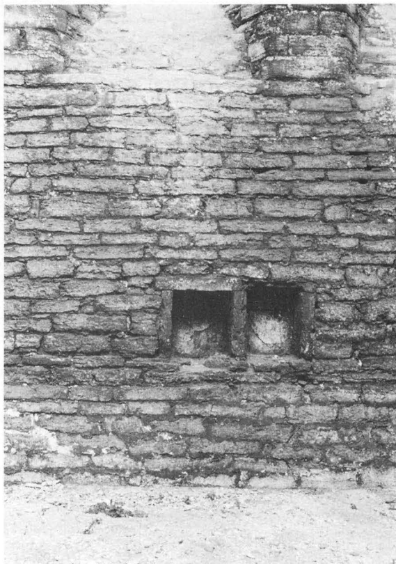
Fig 182. Väggnischer på insidan av korets östra mur. Foto S Hallgren 1972.
