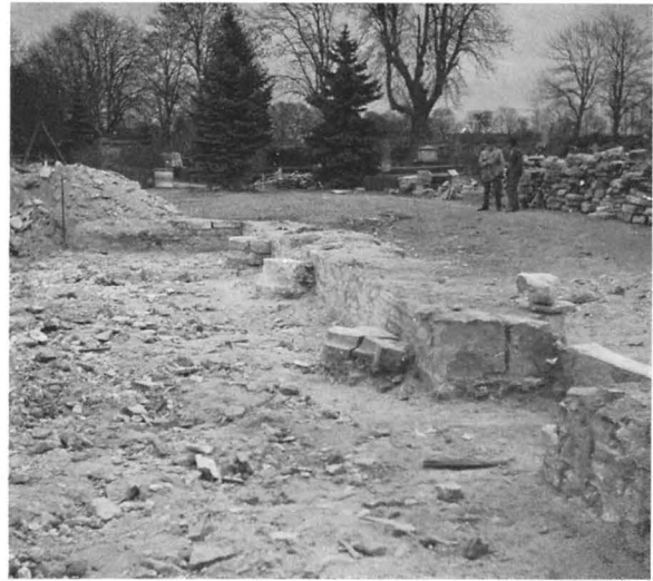
Fig 33. Ett stycke av södra långhusmurens insida med väggpelarna 2D, 3D och 4D. Längst t h sydportalen. Spettet längst t v i bakgrunden markerar triumfbågens södra begränsning. Foto R Boström 1953.
