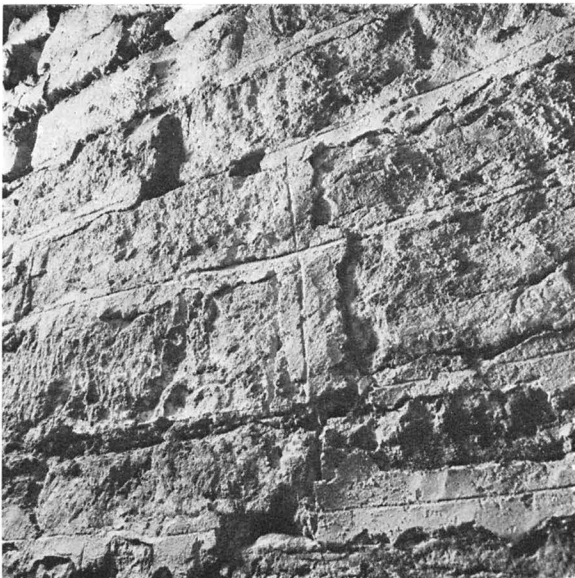
Fig 30. Ett stycke av nordmurens insida med kvaderritsade fogar. Foto S Hallgren 1975.
