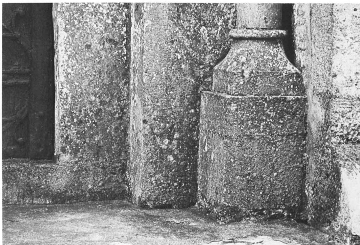
Fig 25. Norra tornportalens västra kolonnett med bas. Foto 1976. The west colonnette and base of the north portal of the tower.
