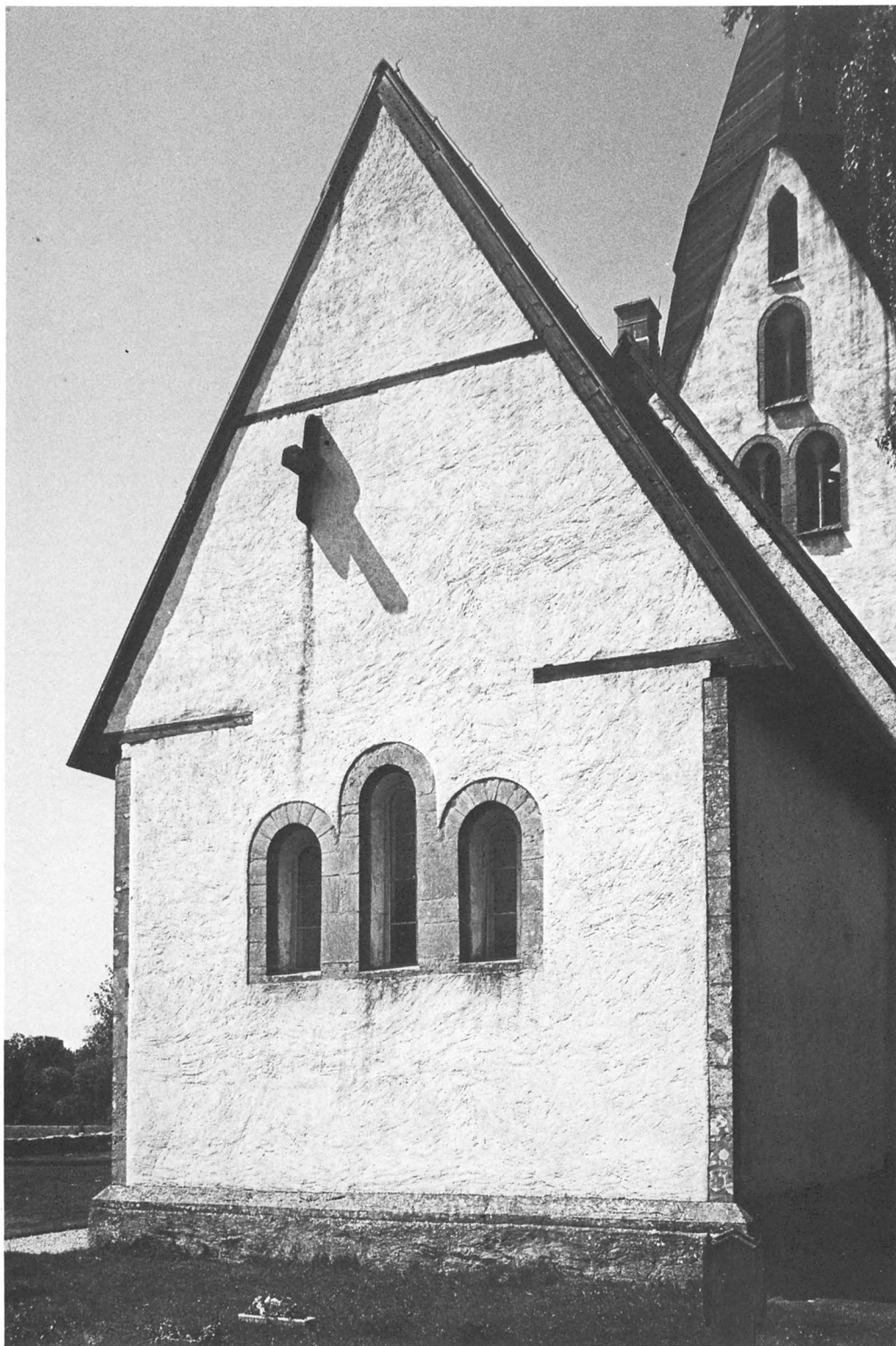
Fig 26. Korets östra fasad med romansk trefönstergrupp, 1200-talets första hälft. Foto 1976.
