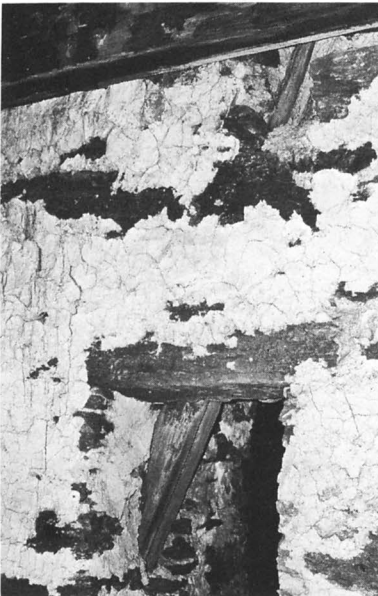
Fig 33. Öppning mot långhusvinden i tornets första övervåning. Märk bjälke med urtagning (nåträanna?). Foto 1976.
