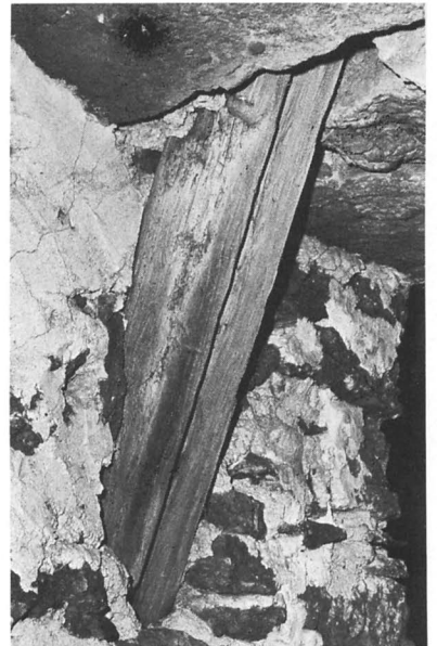
Fig 34. Bjälke med längsgående urtagning (nåträanna?) infogad i tornets östra mur. Foto 1976.
