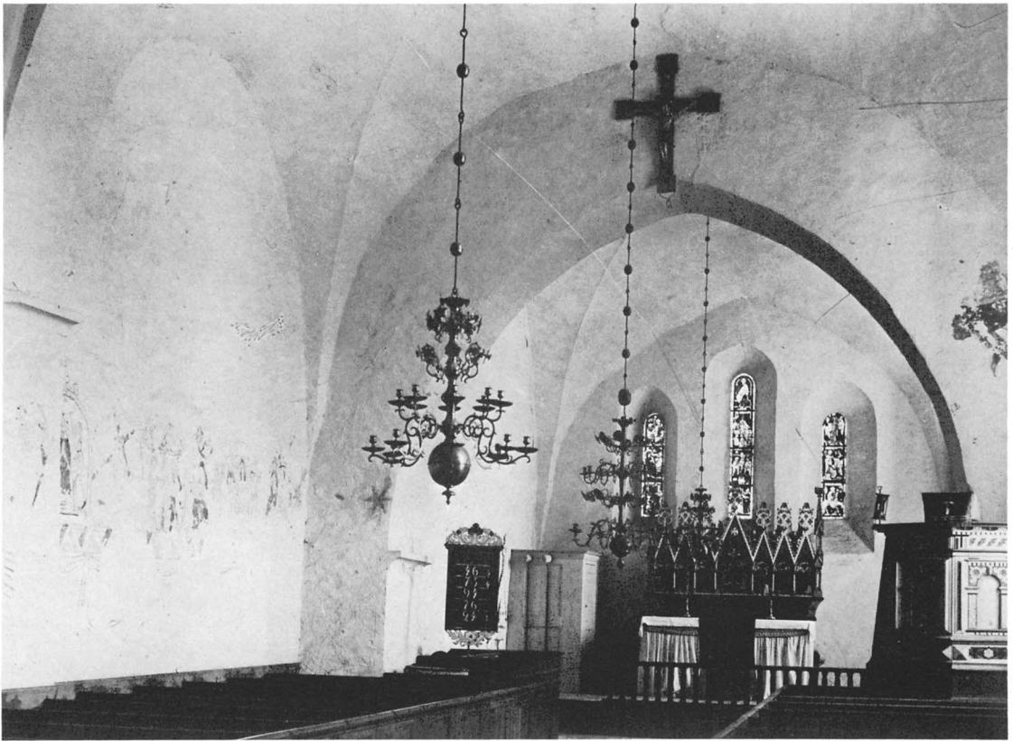
Fig 41. Interiör mot öster före 1923 års restaurering. Foto A Roland. Interior looking east before the restoration in 1923.
