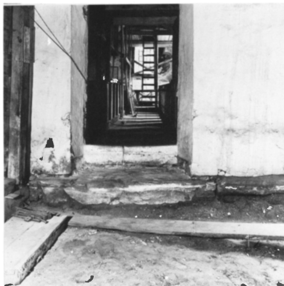
Fig 15. Tröskelsten framför långhusets västportal, frilagd i samband med restaureringen 1972–74. Foto R Nilsson 1973.
