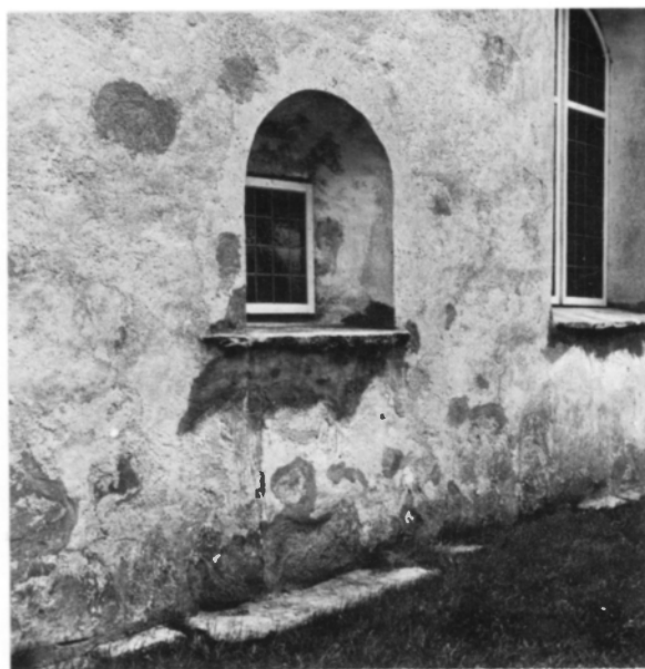
Fig 10. Ursprunglig sydportal, omgjord till fönster 1796. Foto 1974.
