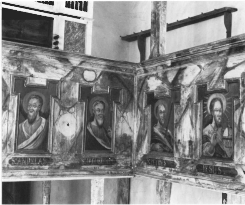
Fig 49. Hörnet mellan väst- och nordläktarna. Målningarna utförda 1749 av Johan Christian Zschotzscher. Foto 1974.
