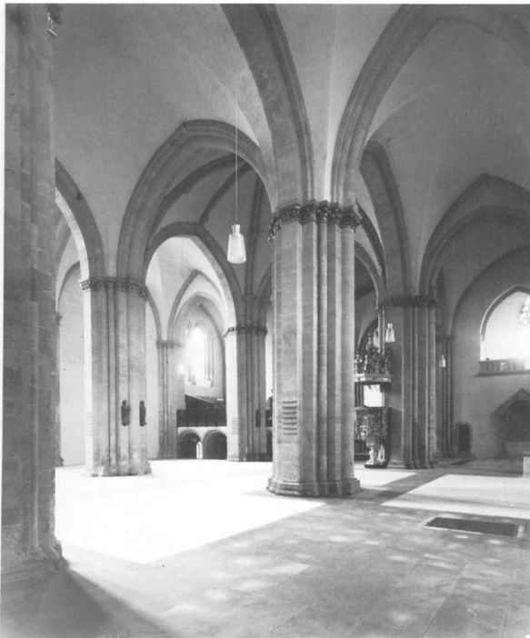
Fig 195. Herford i Westfalen, münstern. Den första stora hallkyrkan i Westfalen med lika höga skepp och utan mellanstöd i sidoskeppsarkaderna. Omkr 1220–1270. Exempel på den typ av kyrkorum, som planerades för Mariakyrkan, när östpartiet förnyades. Foto Landesdenkmalamt Westfalen-Lippe.
