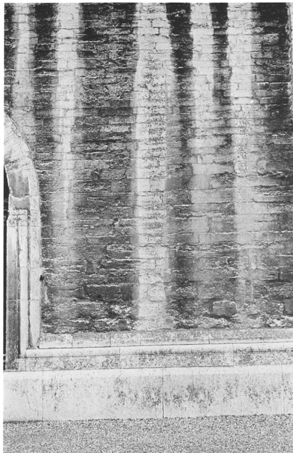
Fig 33. Västtornets västra fasad. Detalj visande växlingen i stenformat i höjd med portalens välvning. Foto G Svahnström 1976.
