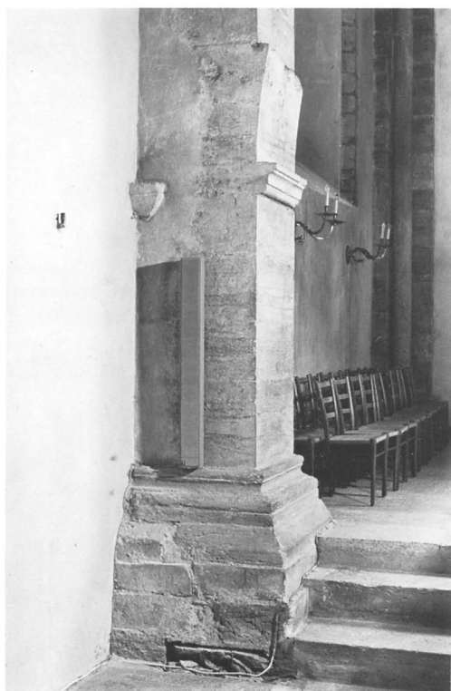
Fig 132. Pilastrern A 5 vid norra långhusmuren med början till valvbåge. Foto 1976.
