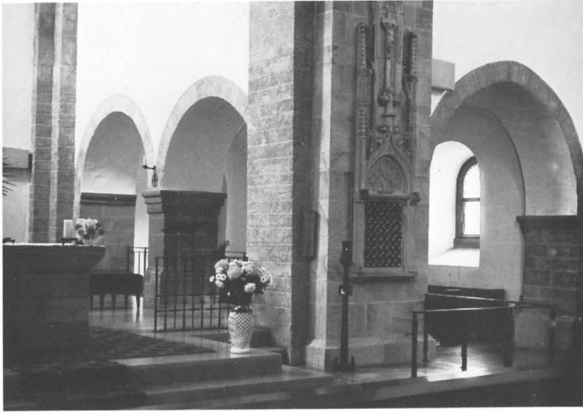
Fig 191. Büren i Westfalen. På ömse sidor om koret ligger låga kapell, som öppnar sig med valvbågar dels mot tvärskeppet, dels mot koret. 1200-talets förra hälft. En liknande anordning synes ha planerats i Mariakyrkan men aldrig färdigstälts. Foto G Svahnström 1977.
