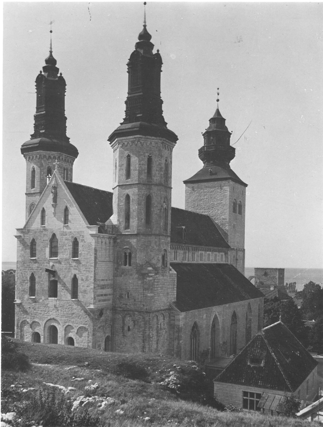
Fig 97. Kyrkan från nordost omedelbart efter restaureringen. Foto K J A Gardsten 1903. ViLA.
