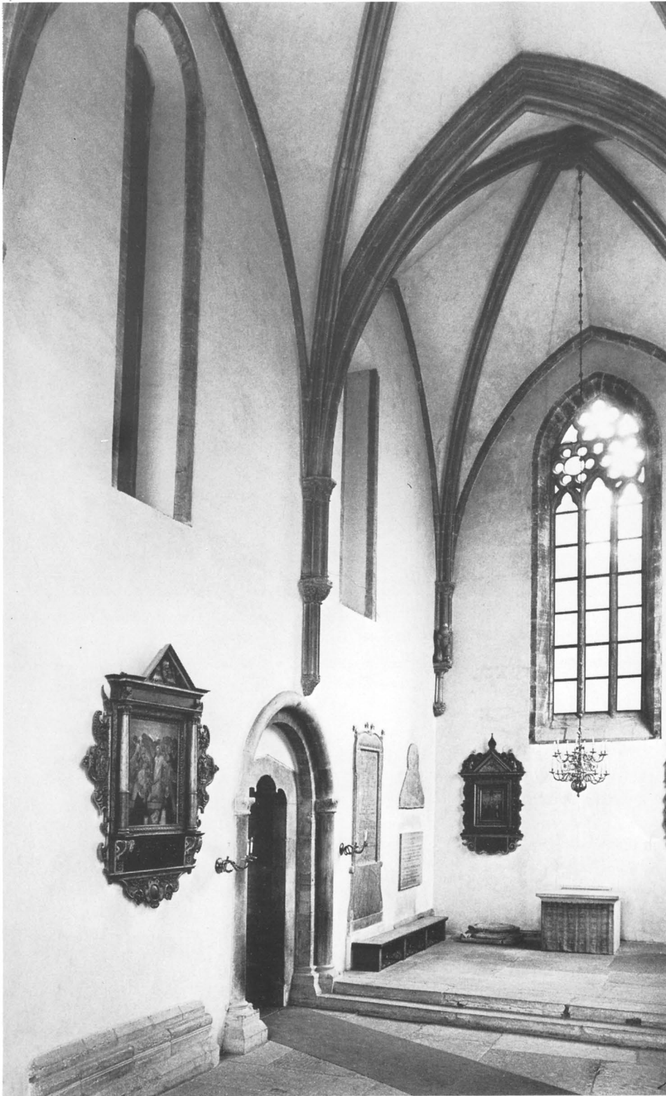
Fig 137. Stora kapellet mot öster. Väggen tv är långhusets södra yttervägg. Foto 1975.
