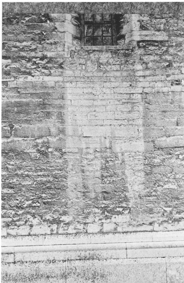
Fig 32. Långhusets norra fasad under fönster nr 1. Detalj visande återanvändning av äldre finhugget fasadmateriäl. Foto G Svahnström 1976.
