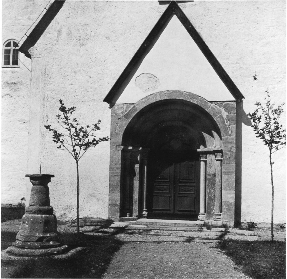
Fig 12. Det fristående soluret (fig 5:9) samt sydportalen före restaureringen 1957–1958. Foto P-O Westlund 1941.
