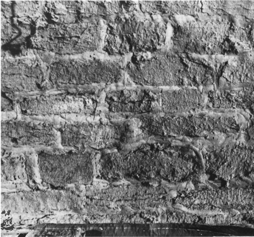
Fig 70. Detalj av korets murverk, synlig från sakristians vind. Endast enstaka lodräta fogar är ritsade. Foto S Hallgren 1976.
