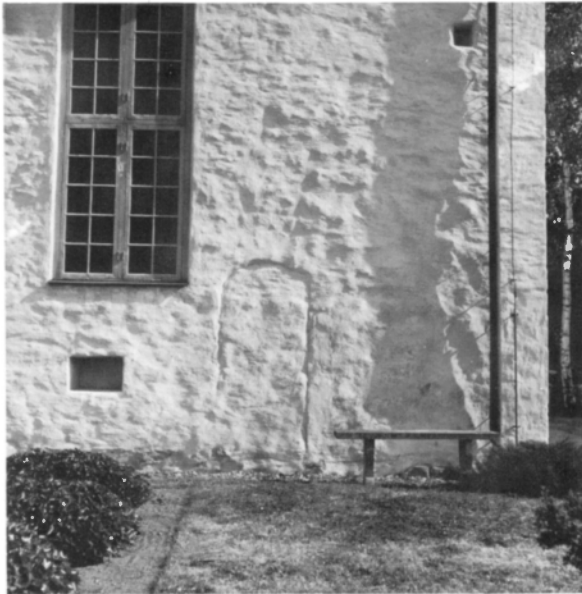
Fig 71. Nisch och igenmurad portal i korets södra mur. Foto R Boström 1969.
