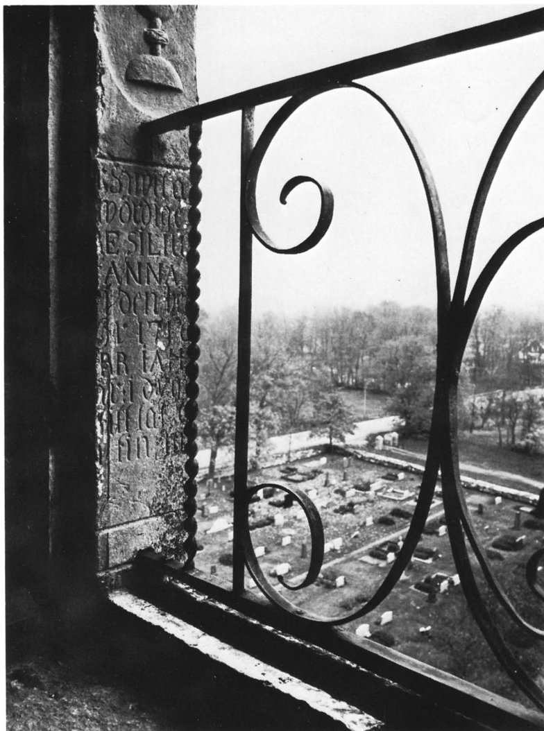
Fig 10. Mittpartiet av gravsten över prosten Jahan Gresilius och hans hustru Anna Pontin, båda döda 1710. Stenen styckad och använd som omfattning i tornets ljudgluggar 1845. Foto S Hallgren 1976.
