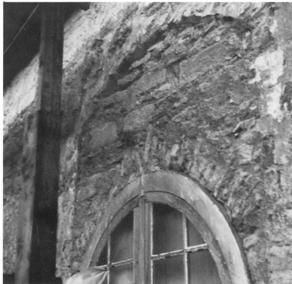
Fig 86 a–b. Långhusförlängningens södra mur med dess fönster. Foto N Carlgren 1957.
