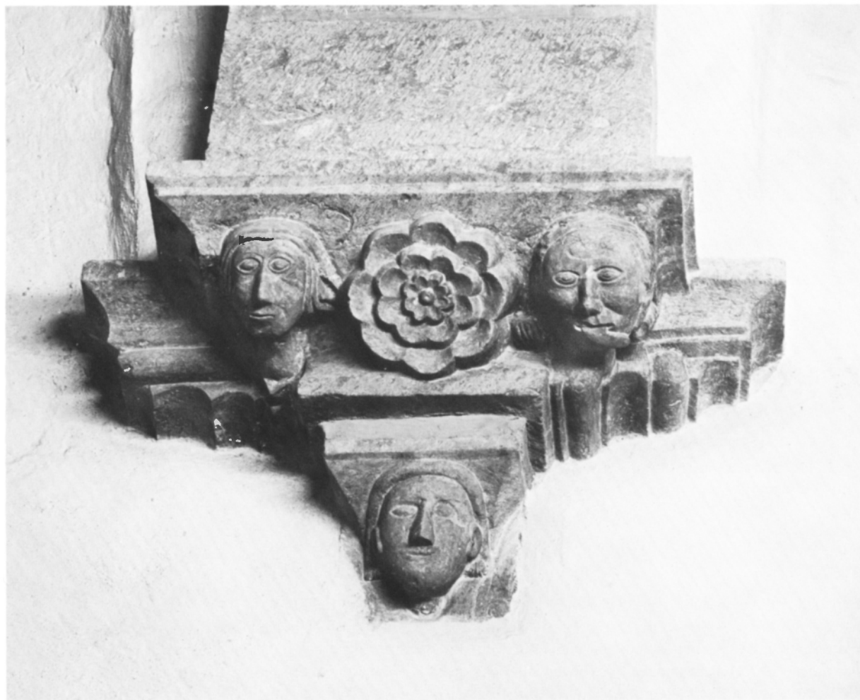
Fig 76–78. Södra konsolen under gördelbågen mellan travéerna II och III, 1300-talets förra hälft. Foto S Hallgren 1972.
