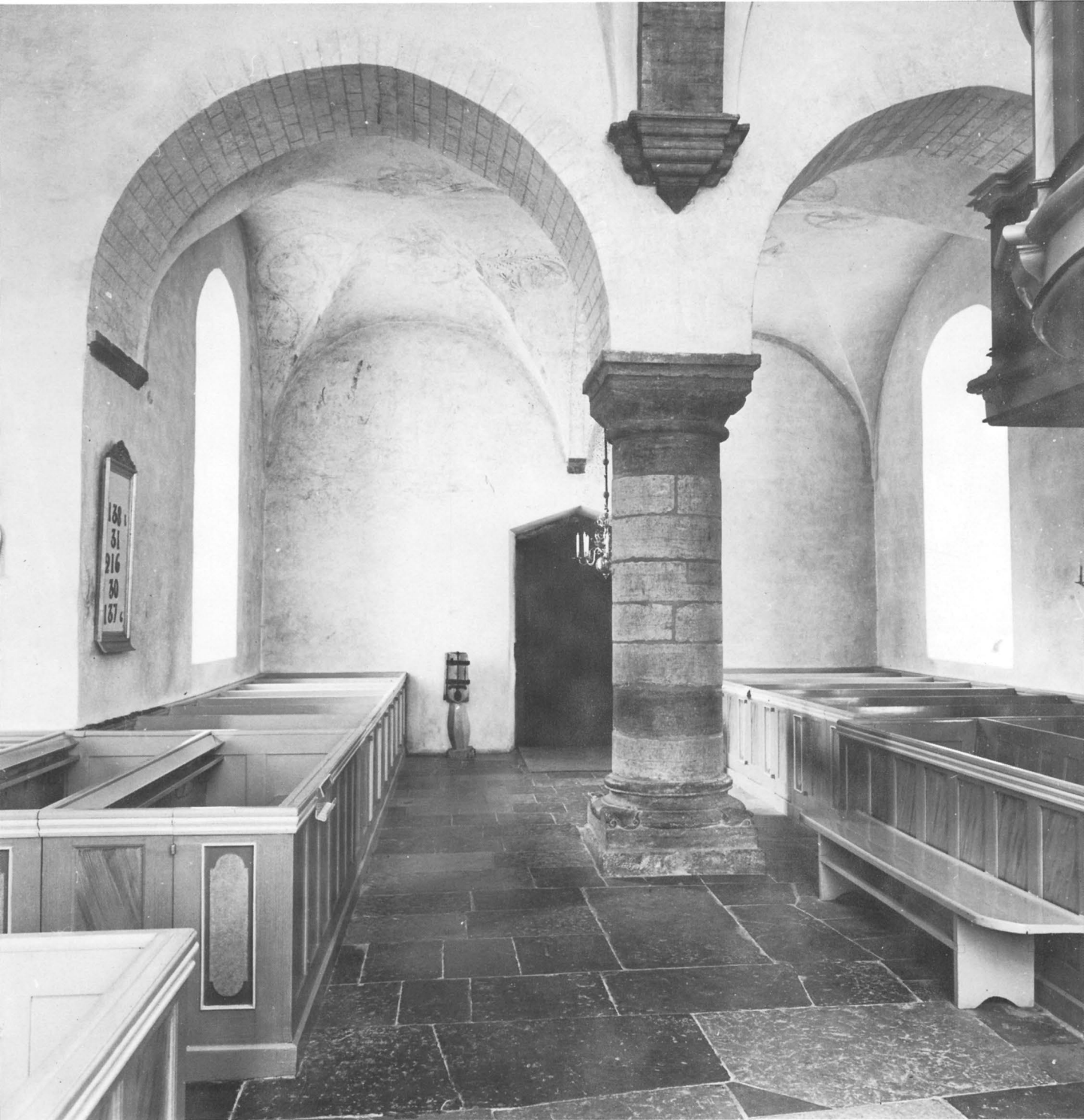
Fig 59. Interiör av södra korsarmen mot söder. Foto S Hallgren 1976.
